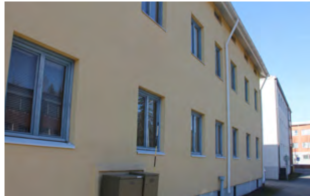
Kangastien suuntaan avautuva katujulkisivu on muodoltaan alkuperäinen.
