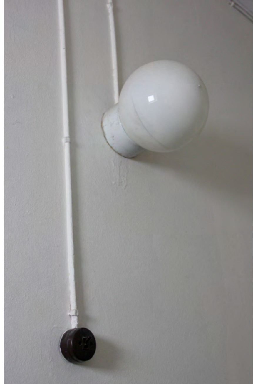
Yksittäinen katkaisija ja valaisin ovat jääneet muistoksi alkuperäisistä sähkökalusteista.
