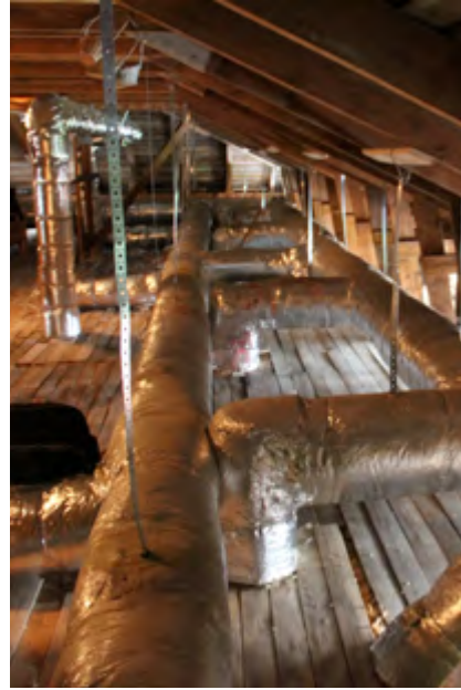
Ensikodin ilmanvaihtokoneelle on löydetty paikka komerosta. Kanaviston vaakalinjat on sijoitettu ullakolle.
