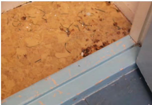
Toisen kerroksen länsisiivessä on lattiamateriaalien kerrostumia. Punainen lattiamateriaali keskellä on alkuperäinen.
