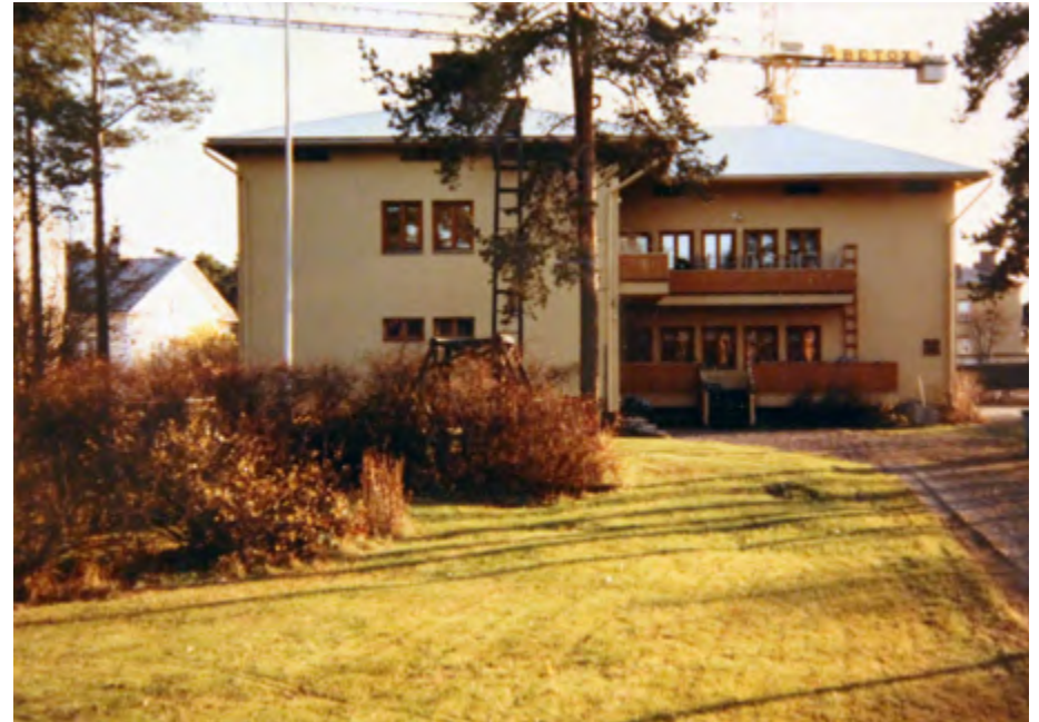
Ensikoti vuonna 1983 hieman ennen Turvakodin rakentamista. Rakennus on saanut uuden värityksen ja peltikaton. Ikkunat on vaihdettu. Turvakodin puurakennus näkyy kuvassa takana vasemmalla.
