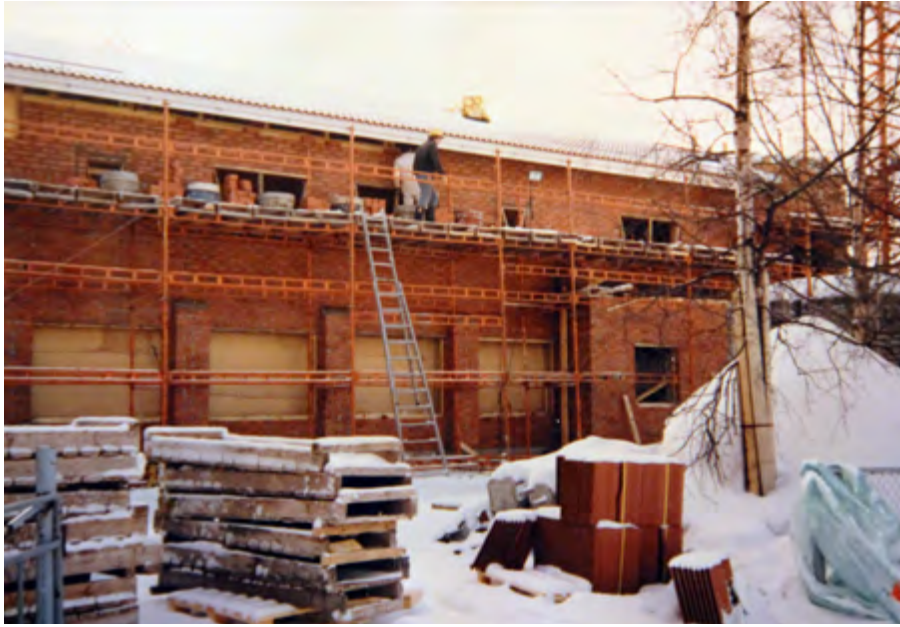
Kantava runko on toteutettu paikalla valettujen seinien ja pilareiden sekä sandwich-julkisivuelementtien yhdistelmänä. Välipohjissa on käytetty ontelolaattoja. Pilari-laatta-rakenne antaa rakennukselle muuntojoustavuutta.
