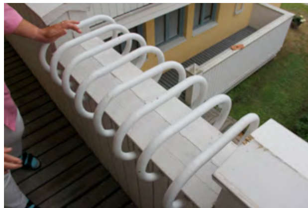
Matontuuletustelineet on lisätty 1980-luvun jälkeen.
