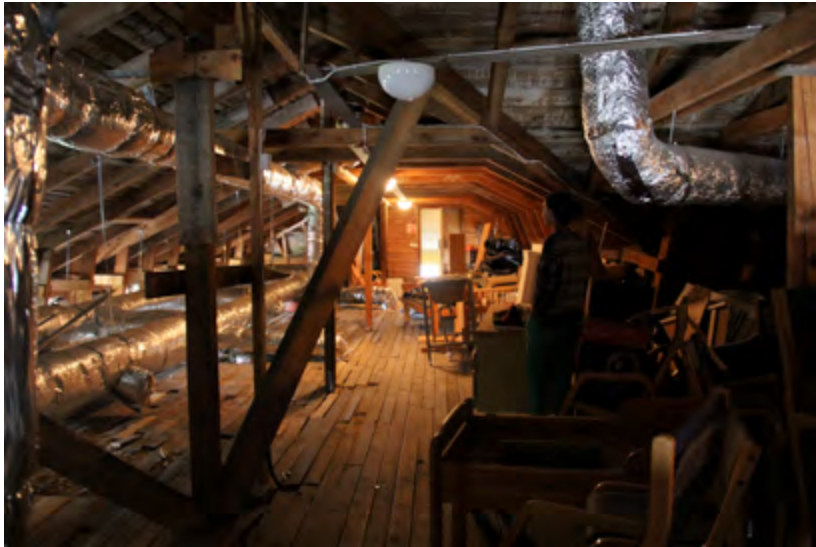
Näkymä ullakolle, jota hallitsevat ilmanvaihdon kanavistot. Oikealla vesikattorakennetta. Tärytiilestä muurattu runko näkyy kuvan oikeassa reunassa.
