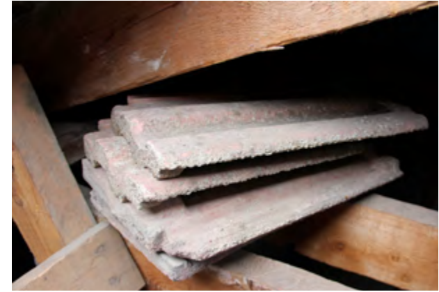
Ensikodin ullakolla on alkuperäisiä savikattotiiliä.
