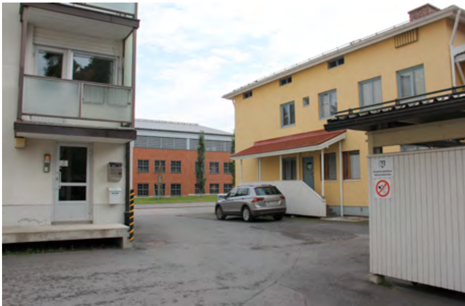
NÄKYMÄ C: Mäntykodin pihalta Ensi- ja Turvakodin talouspihalle. Oikealla näkyvä varistorakennus on näiden kahden toimijan yhteinen.
