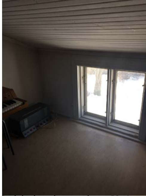
Ruokalarakennuksen vinttihuone. RL 5/2018.
