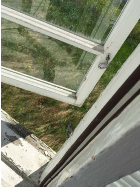
Toimistuhuoneen ikkuna joelle. RL 5/2018.
