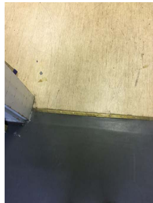
Ruokasalin ja keittiön lattiamatot. RL 8/2018.
