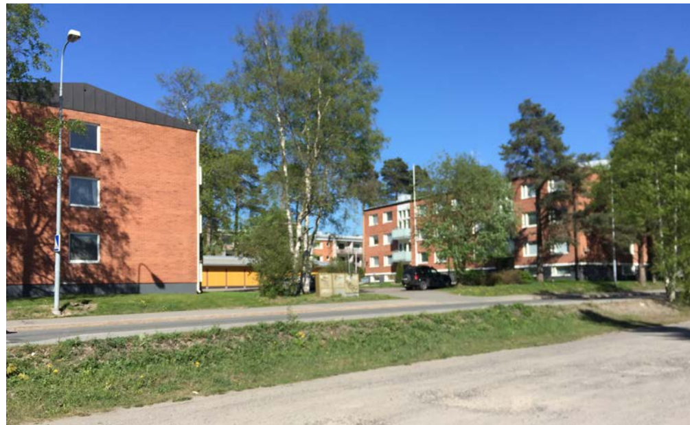
Hintantien toisella puolella olevia kerrostaloja. Kuva RL 5/2018
