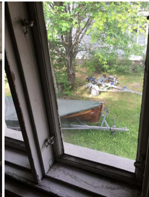
Ruokalarakennuksen ikkuna. RL 6/2018.
