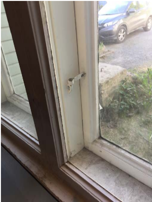
Eteiskäytävän ikkuna. Kuva RL 5/2018.
