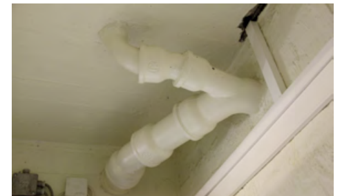
Valurautaisia viemäriinjoja kellarin alakatossa.
