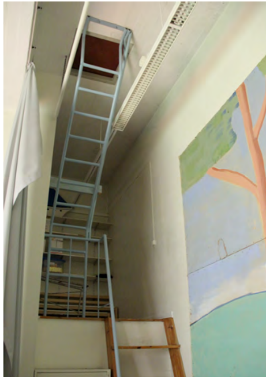
B-osan ullakolle johtavat terästikkaat on lisätty 1990-luvulla.
