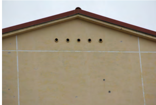
Ullakon tuuletus on järjestetty saviputkilla päädyistä ja sivuilta.
