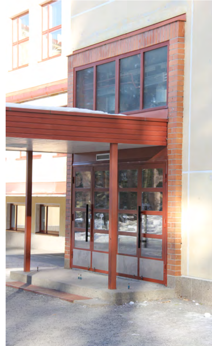
Pääsisäänkäyntiä korostaa punatiili-aihe. Alkuperäinen sisäänkäynti muodosti solan, kunnes pääovi siirrettiin ulkoiseinän linjaan. Sadekatos jatkuu pääoven levyisenä.
