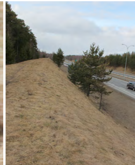
Nelikaistaista Pohjantietä reunustaa Lintulammen koulun kohdalla maamassoista rakennettu meluvalli.
