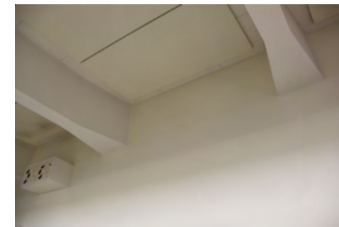
Pukkiholvin liittyminen kantavaan seinämuriin. Tiilimuurin kannattamat palkkien päät on levennetyt.
