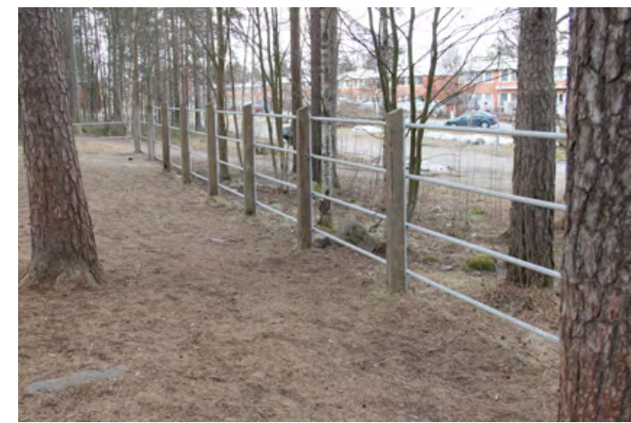
Nykyinen aita hyödyntää alkuperäisiä betonipilareita.
