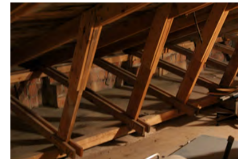
Käyttöullakon 'ruotsalainen kattotuoli' säästää tilaa.
