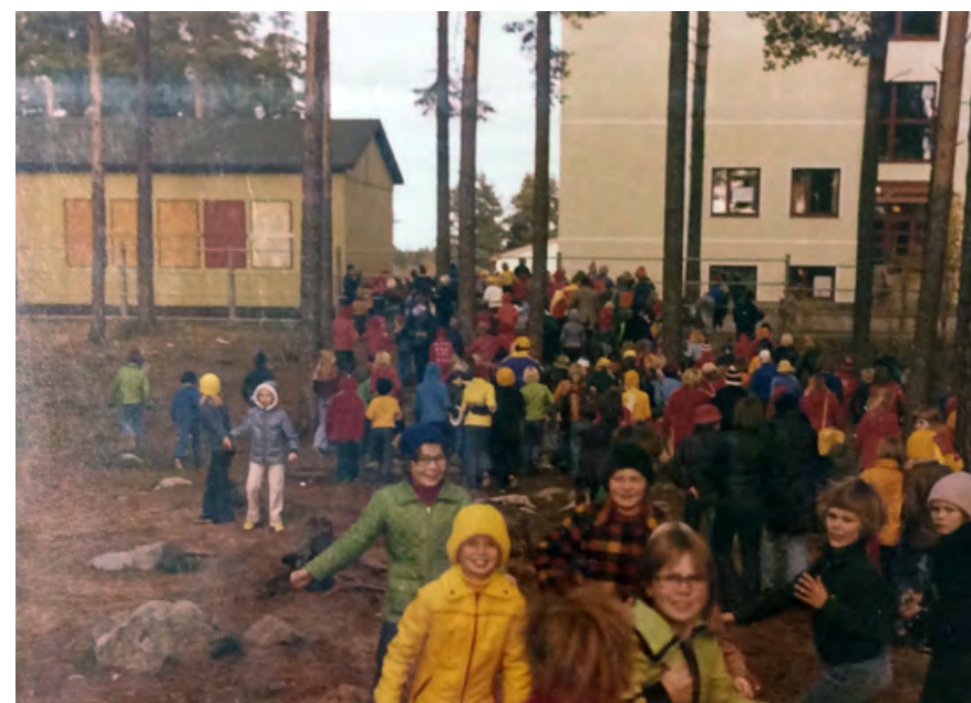
1980-luvun lopulla parakki oli tullut käyttökänsä päähän. Lintulammen puiston suuntaan ikkunat oli levytetty umpeen. Kuva: Lintulammen koulun arkisto
