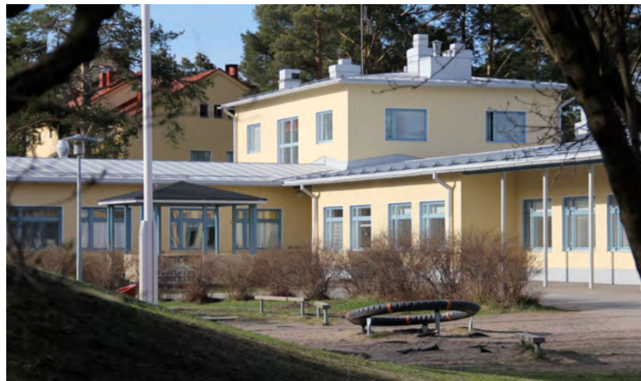
Taustalla näkyvän Martti Heikuran vuonna 1955 suunnitteleman Höyhtyän lastenkodin rakentaminen kytkettiin samaan hankkeeseen Nokelan koulun kanssa. Etualalla on niinikään Heikuran suunnittelema Höyhtyän lastentalo vuodelta 1963. Se oli valmistuessaan Oulun ensimmäinen tähän tarkoitukseen suunniteltu rakennus.
