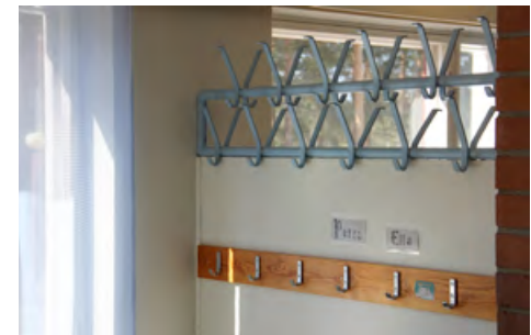
Alkuperäinen vaatenaulakko. Alle on lisätty seinäke.
