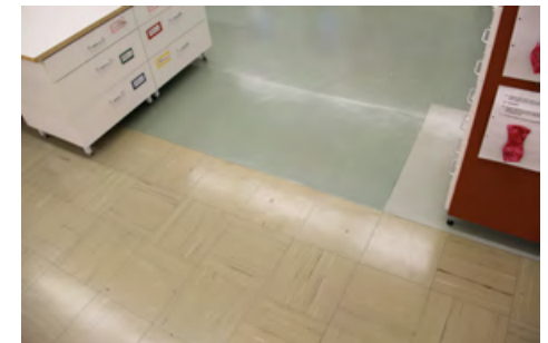
Kolmen erilaisen lattiapinnoitteen risteyskohta.
