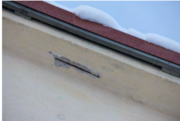
Teräsbetonista valettu räystääs on umpinainen.
