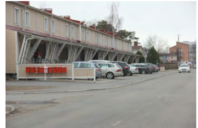
Höytyän alueen omaleimaisinta asumismuotoa edustavat Selvaakkitalot. Ne ovat norjalaistyypisiä rivitaloja, joissa asuminen liittyy tiiviisti katualueeseen.
