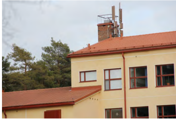
Savitiilikatto ja saman värinen pellitys. B-osassa on ollut 30 m 2 peltikatto.
