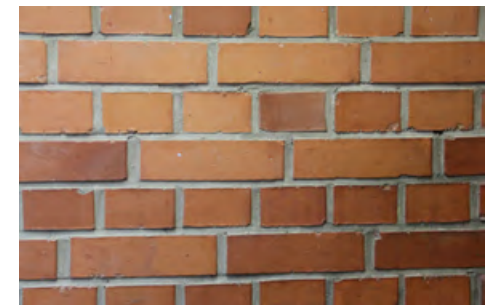
Puhtaaksi muurattu tiilimitys kertoo seinän rakenteesta.
