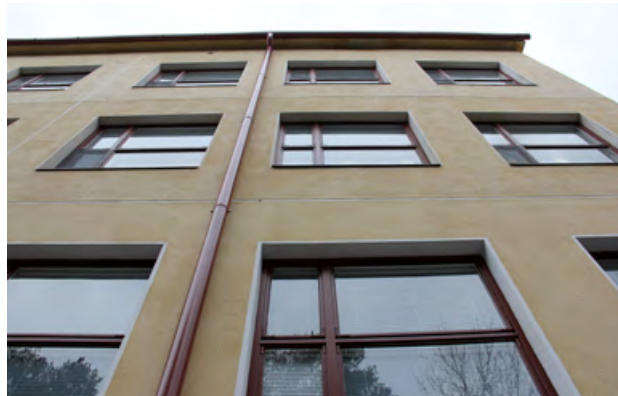
Itäjulkisivulla rappaus on kohtalaisen hyvässä kunnossa.
