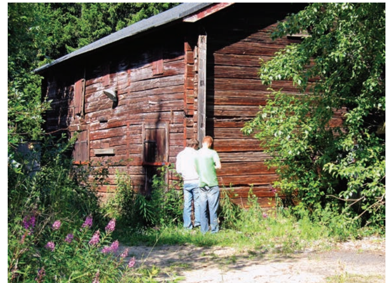
Kuva 115. Hirsirakenteista tallia mitataan kesällä 2009. Tatu Raitala.
