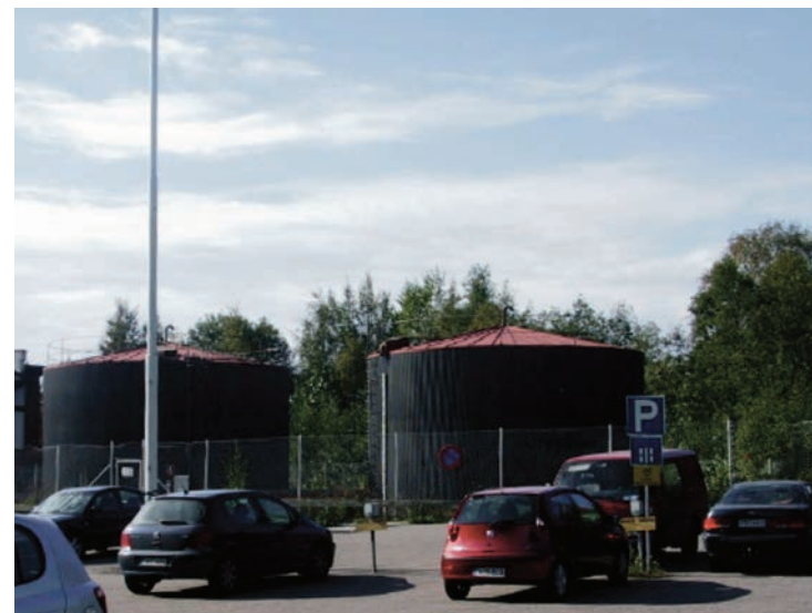
Kuva 105. Öljysäiliöt kesällä 2008. OTK.
