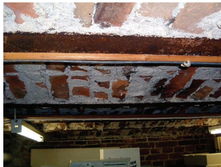
Kuva 162. Konttorirakennuksen kellarin välipohjan ratakiskoholveja. Alatulkkila et. al., 2004.
