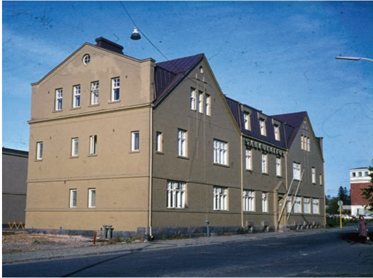
Kuva 88. Rakennuksen väritystä vuonna 1973. OYAO/AH.
