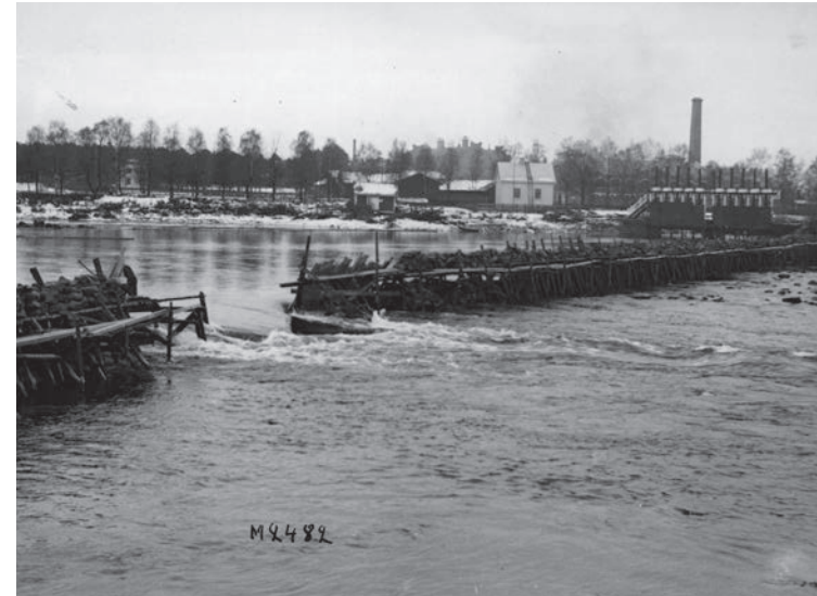
Kuva 96. Merikoskeen rakennettu talvipato vuonna 1939. SK.
