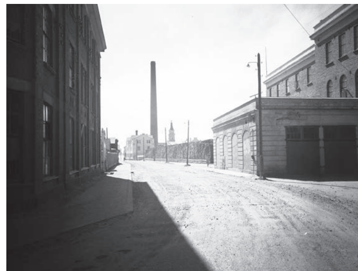
Kuva 148. Nykyisen taidemuseon (oik.) ja tehdasrakennuksen välinen katutila on ollut tiivis jo nahkatehtaan aikana. PPM.
