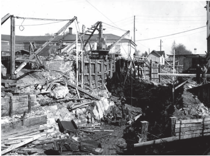
Kuva 75. Turbiinihallia rakennetaan huhtikuussa 1937. SK.
