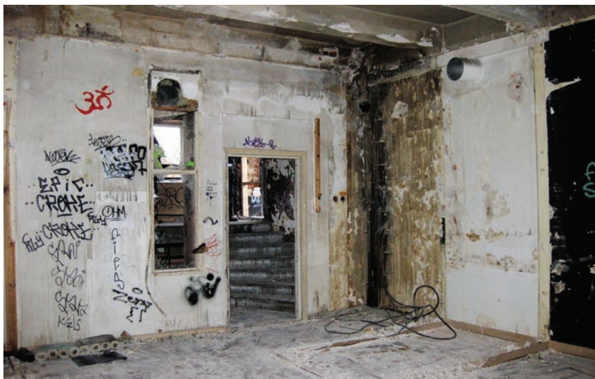
Kuva 131. Sisätiloja voimalarakennuksen toisessa kerroksessa syksyllä 2009. Kevyitä väliseiniä ja palossa vaurioituneita pintoja on purettu. AM.
