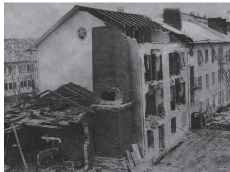
Kuva 101. Asuinkerrostaloksi muutettua koneremmittehtaan rakennusta puretaan. OYAO/AH.
