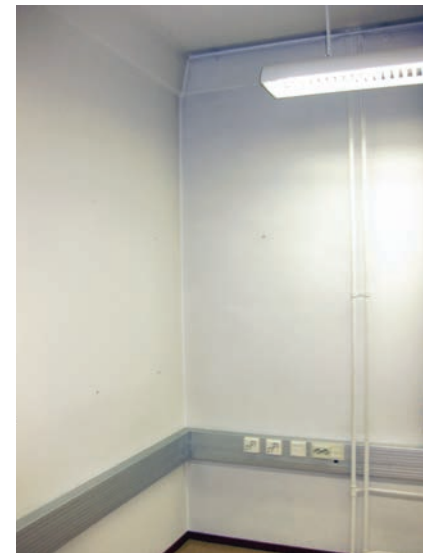
Kuva 143. Toimistohuoneiden sisäkaton muoto on säilynyt. AM.
