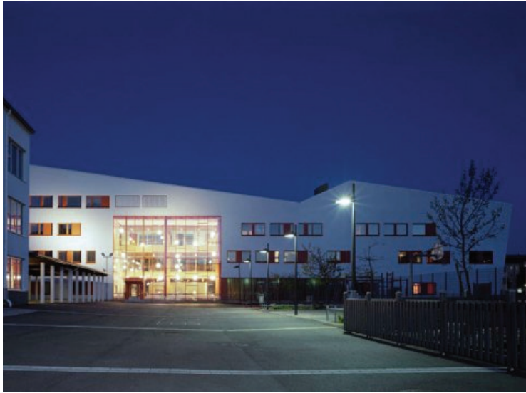
Kuva 50. Vuonna 2009 valmistunut Tervaväylän koulun Lohipadon yksikkö. Linja Arkkitehdit.
