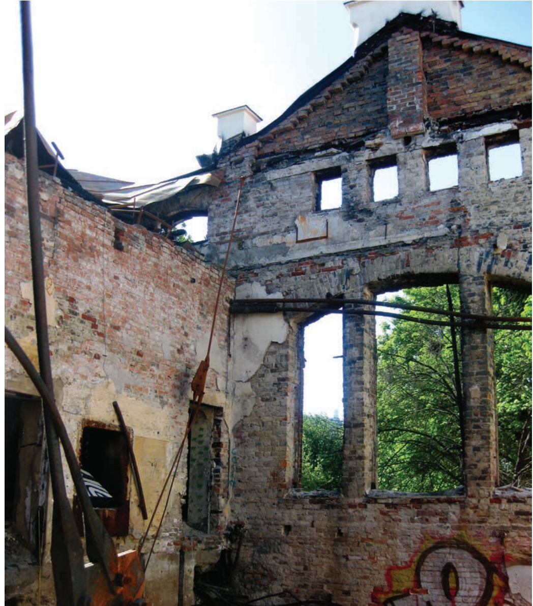
Kuva 123. Vanhan turbiinihallin sisätilaa kesällä 2009. Vasemmalla seinässä aukot konehuoneeseen. Päätykolmio ikkunoiden yläpuolella purettiin saman vuoden syksyllä. AM.
