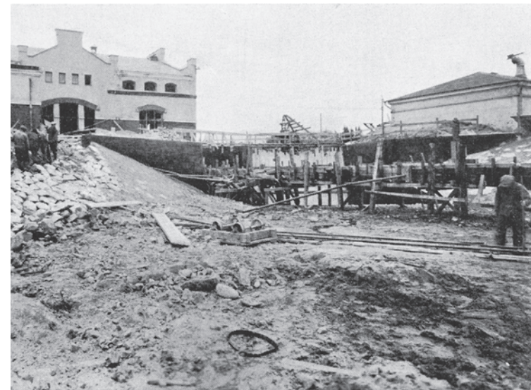
Kuva 97. Työmiehiä sähkölaitoksen vesialtaalla turbiinihallin rakennustöiden yhteydessä vuonna 1937. Junnelius, 1939.
