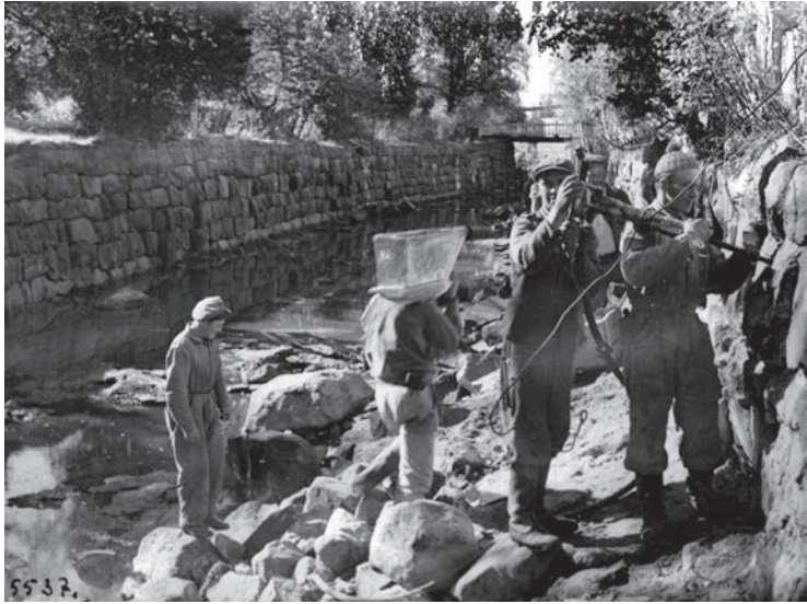
Kuva 98. Miehiä korjaamassa yläkanavaa vuonna 1948. SK.
