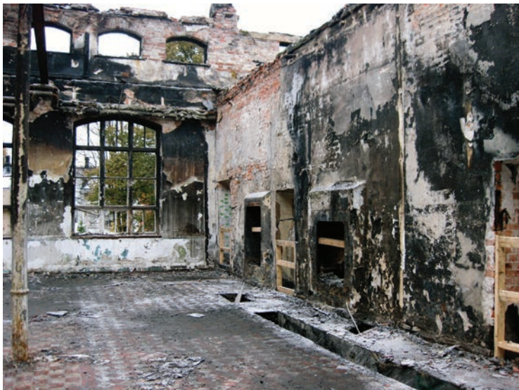
Kuva 126. Generaattoreita ja turbiineja yhdistäneet aukot ovat säilyneet. Lattiasta voi havaita myös koneiden paikat. AM.
