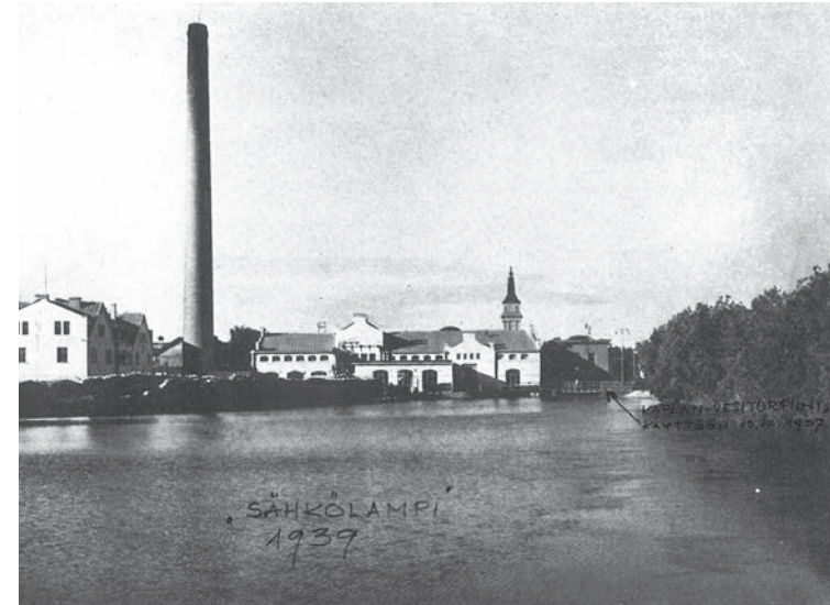
Kuva 77. Sähkölaitos toisen maailmansodan aikana vuonna 1939. Vesialtaan rannalla sodan aikainen polttopuutarasto. OE.
