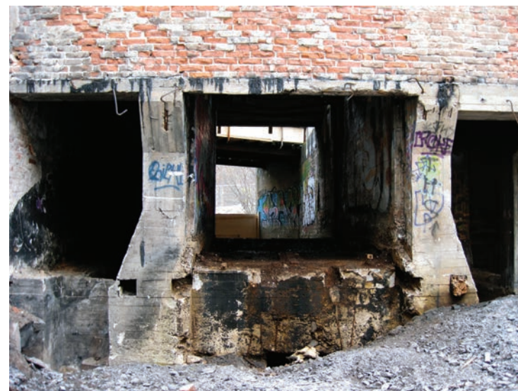
Kuva 158. Vuonna 1903 rakennettuja vettä ohjaavia rakenteita voimalaitoksen sisällä syksyllä 2009. AM.
