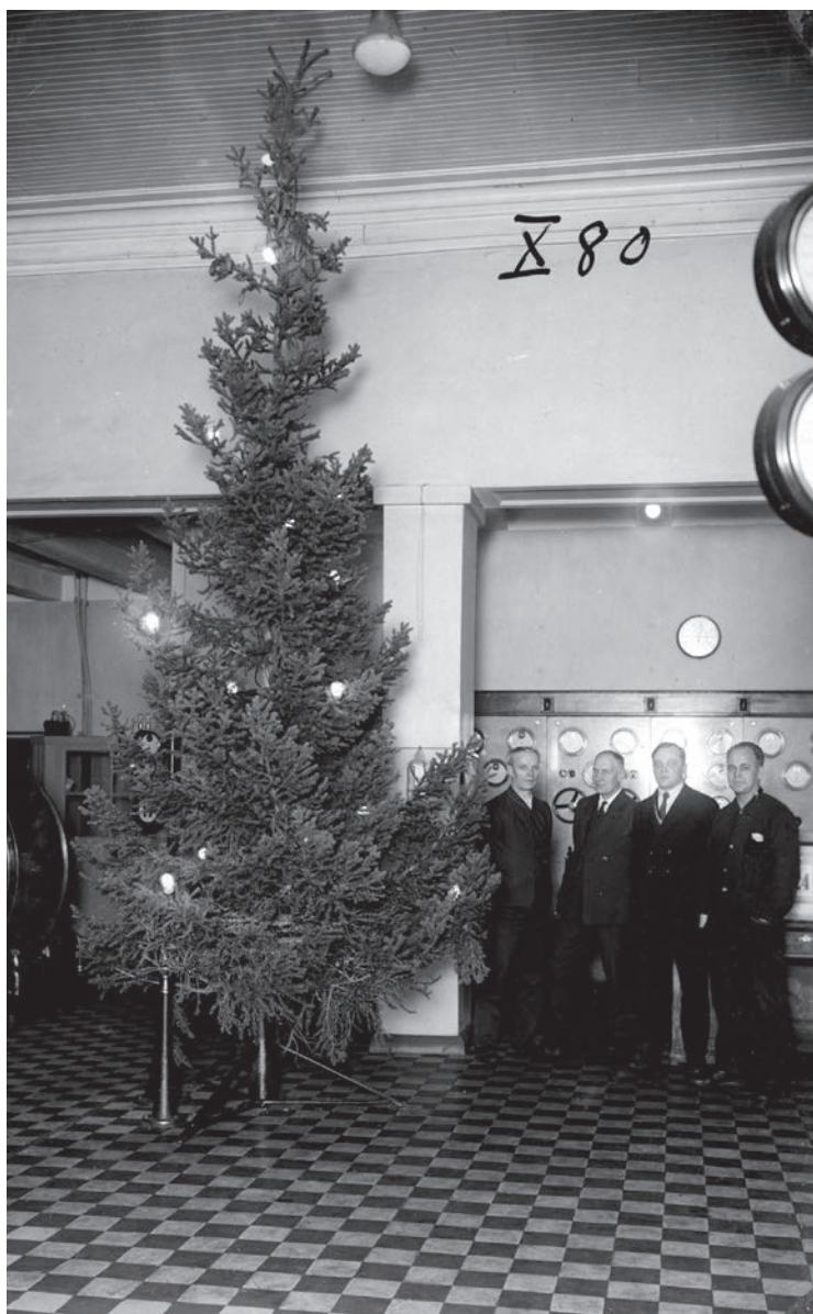
Kuva 4. Joulun viettoa voima-aseman konehuoneessa vuonna 1931. SK.
