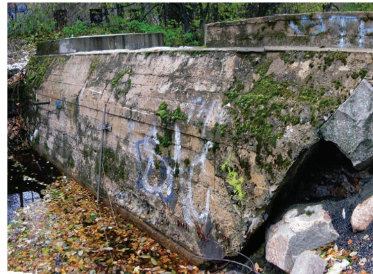
Kuva 94. Maapadon eteläisin tyhjennysaukko ja "lämmitettävän huoneen" perustukset syksyllä 2009. AM.
