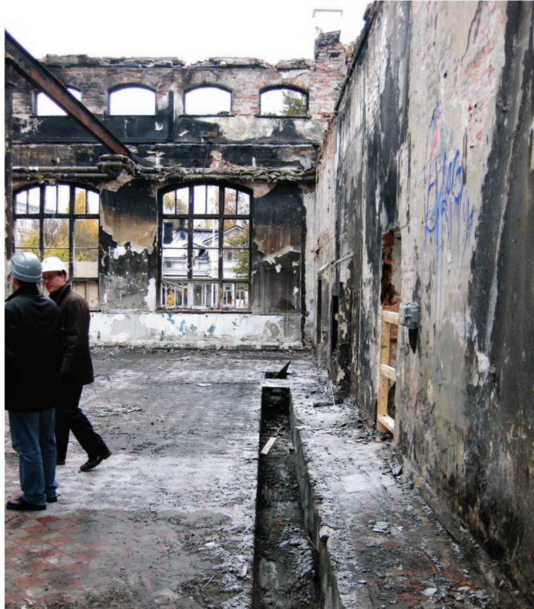
Kuva 127. Voimalan vanhinta osaa, vuonna 1903 rakennettu konehuone syksyllä 2009. Lattialaatoitus ja palaneen välipohjan teräspalkki ovat alkuperäisiä. AM.
