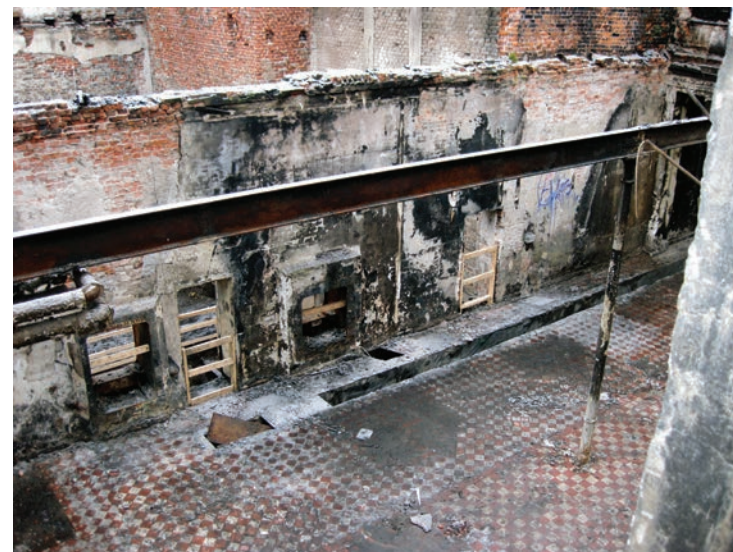
Kuva 157. Vanhan konehuoneen säilyneitä alkuperäisiä rakenteita syksyllä 2009. AM.
