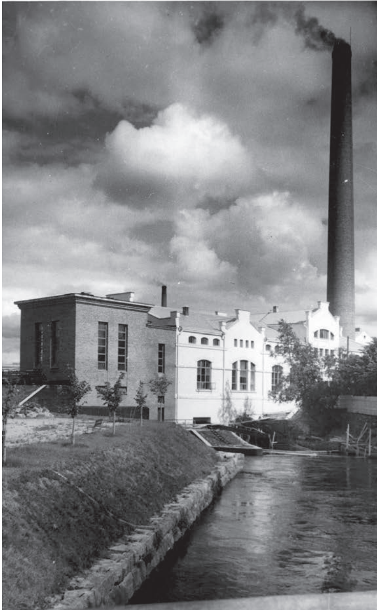
Kuva 152. Lasarettinväylän sähkölaitos elokuussa 1939. SK.
