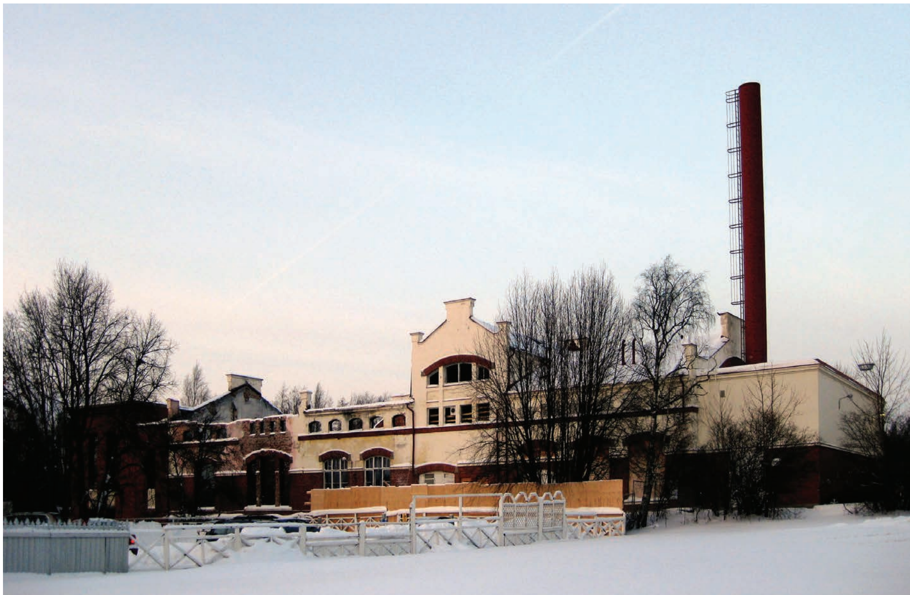
Kuva 61. Sähkölaitoksen entinen voimalarakennus helmikuussa 2010. AM.
