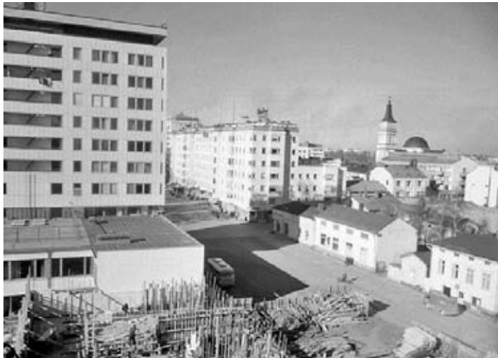
Kuva 73. As Oy Väylänvarsi rakenteilla vuosina 1961-62.
