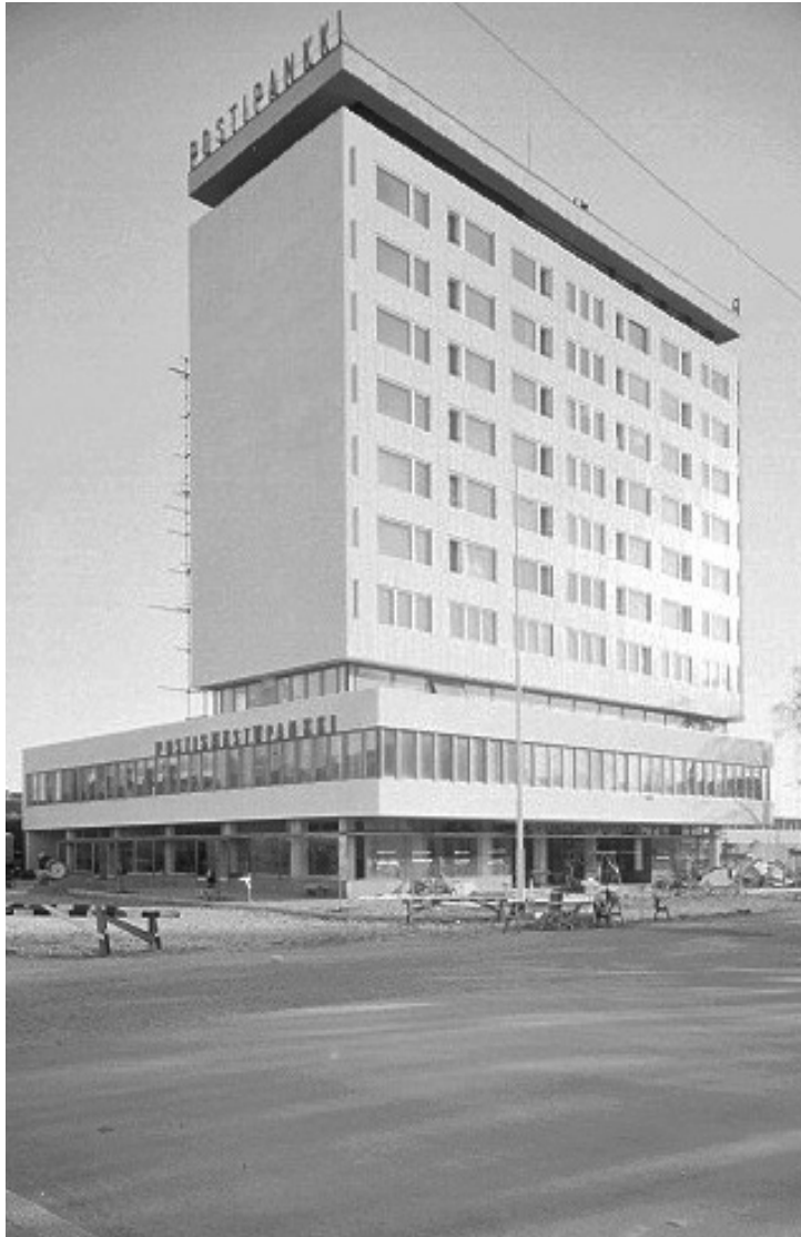
Kuva 32. Lähes valmis Klubitalo, takajulkisivun puolella on vielä rakennustelineet, vuosi 1960. Vanha puuklubi on huutokaupattu ja siirretty pois.
