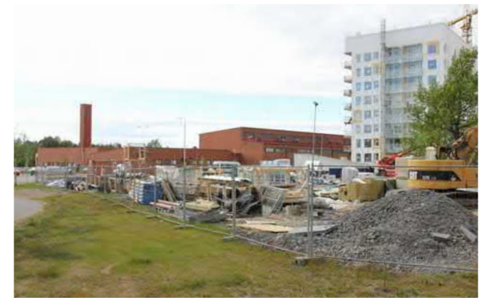
8. Näkymä Koskitien länsipäästä, jossa ajorata Kaupunginvarikon suuntaan on katkaistu. Oikealla näkyy rakenteilla oleva Lipporannan kortteli.
