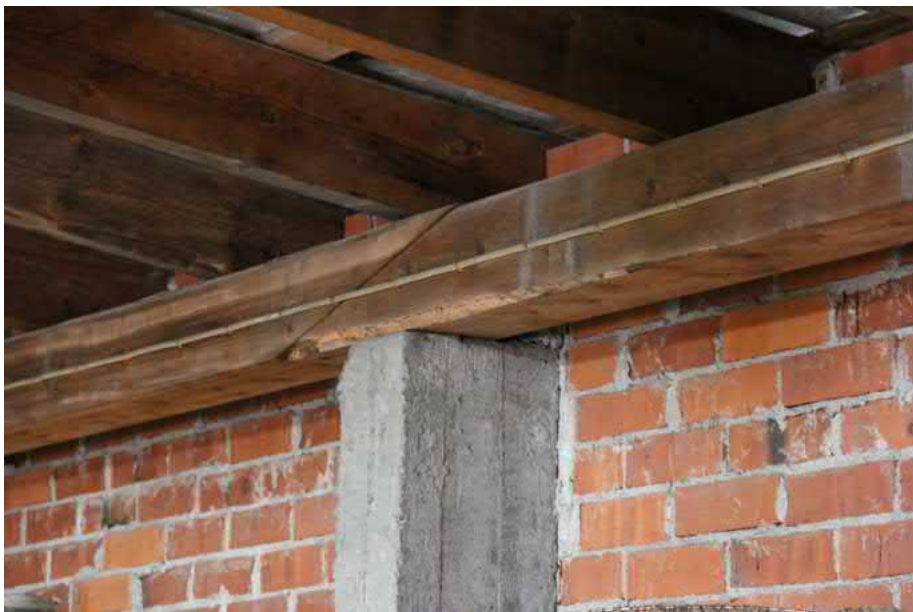
178. Betonipilarit kannattelevat puista vesikattorakennetta.
