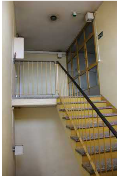
160. Vesihuollon toimistoihin johtava rappukäytävä.
