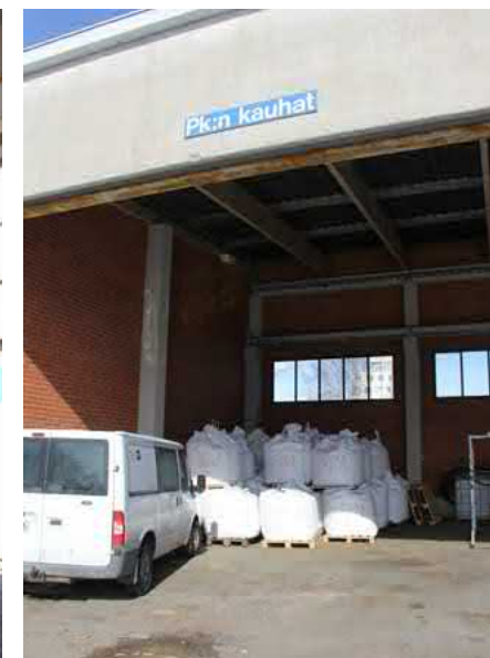
173. Konekatos tehtiin suurille koneille ja painaville laitteille. Katosta käytetään myös lyhytaikaisessa varastoinnissa.
