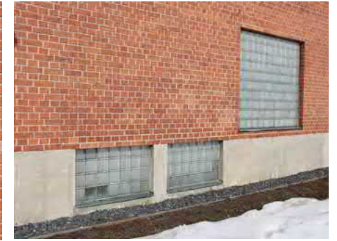
89. Lasitiili-ikkunat toimistosiiven eteläpäädyssä.
