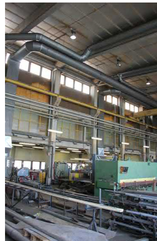
146. Uudempi korjaamohalli. Taustalla toimistoparvi.
