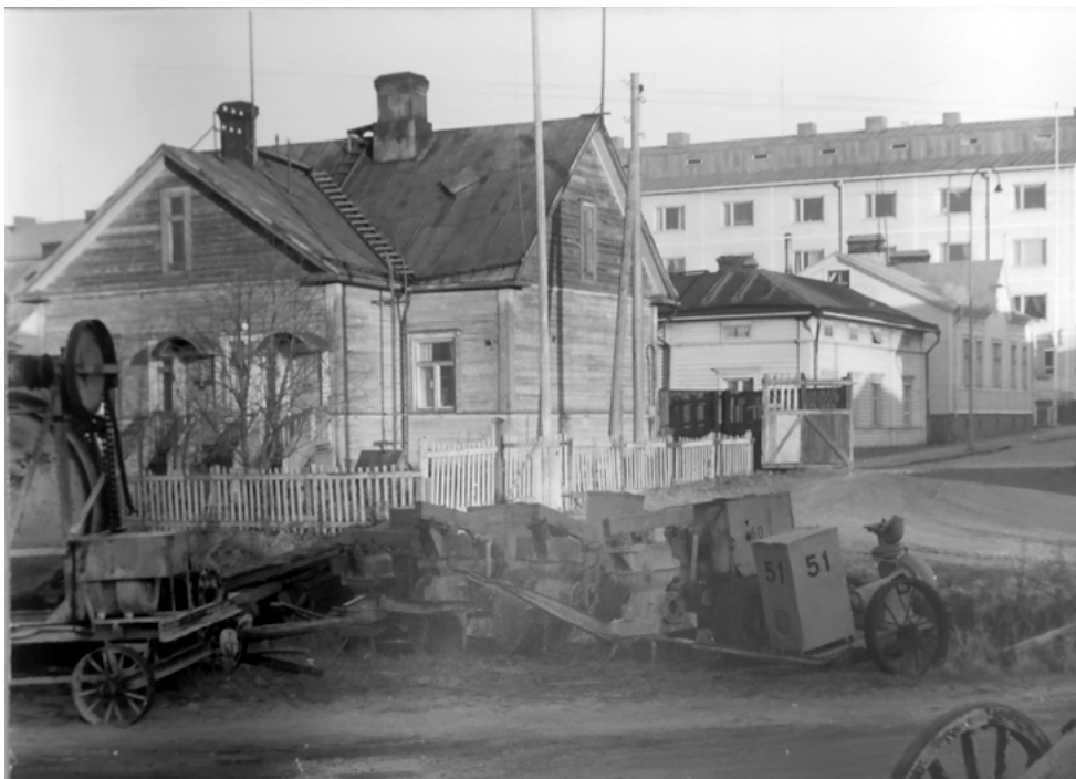
13. Etu-Lyötyin korjaamon rakennuksia: Putkimestarin asunto ja pumppuvarasto KUVA: Kaupungin varikon arkisto
