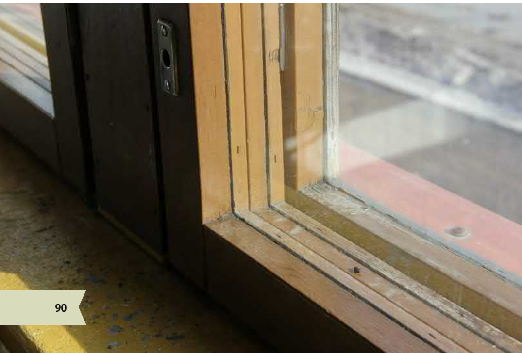
151. Laajennusosan ikkunat ovat kolmilasisia MSK-ikkunoita.
