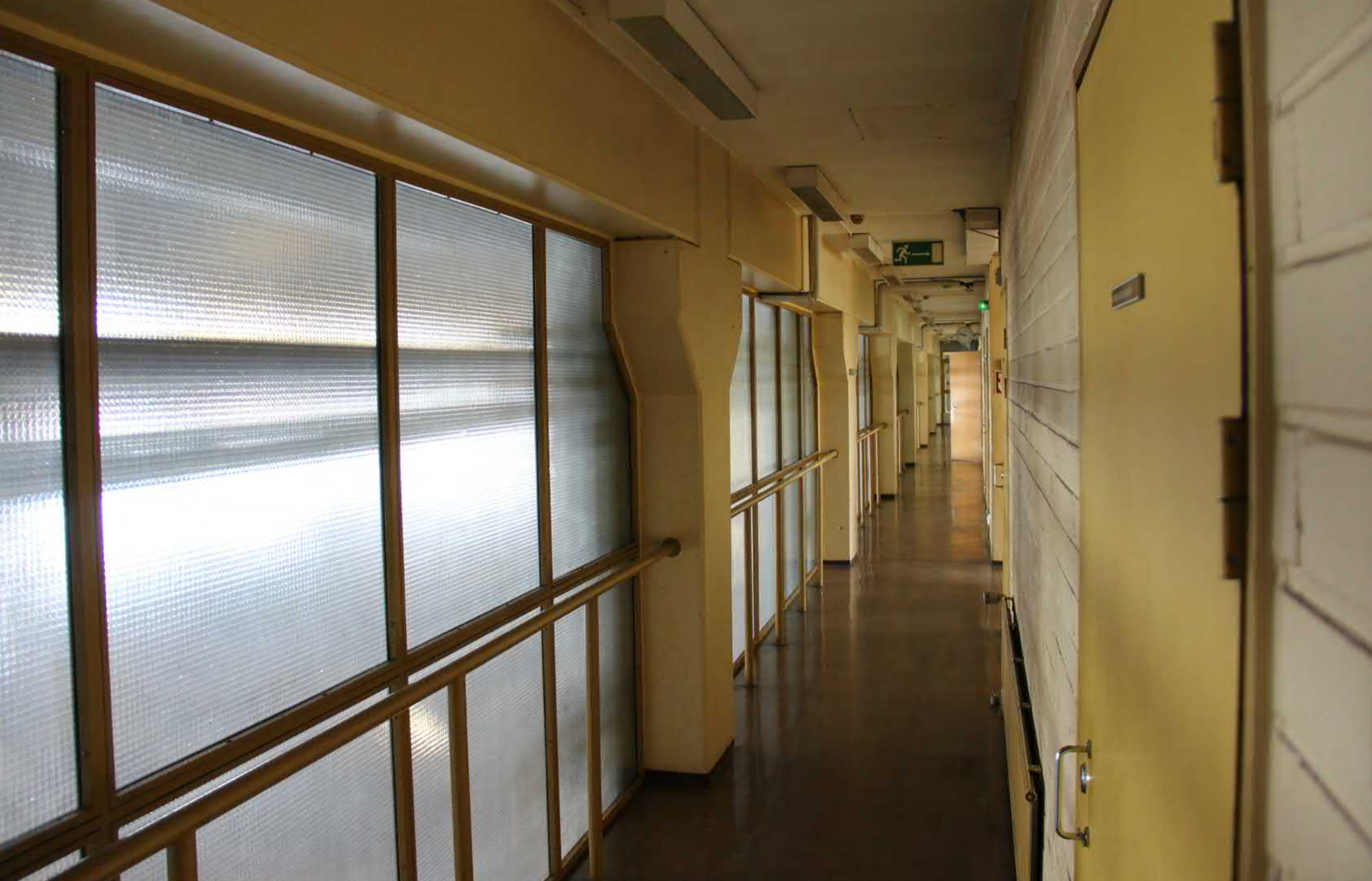
148. Laajennusosan parvi on toteutettu samalla periaatteella kuin vanhemmassa osassa, mutta detajit ovat pelkistyneet. Runko on rakennettu tehdasvalmisteisista elementeistä.
