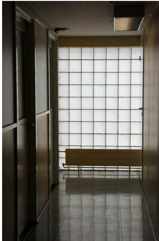
111. Lasitiiliseinä toimiston käytävän päätteellä.
