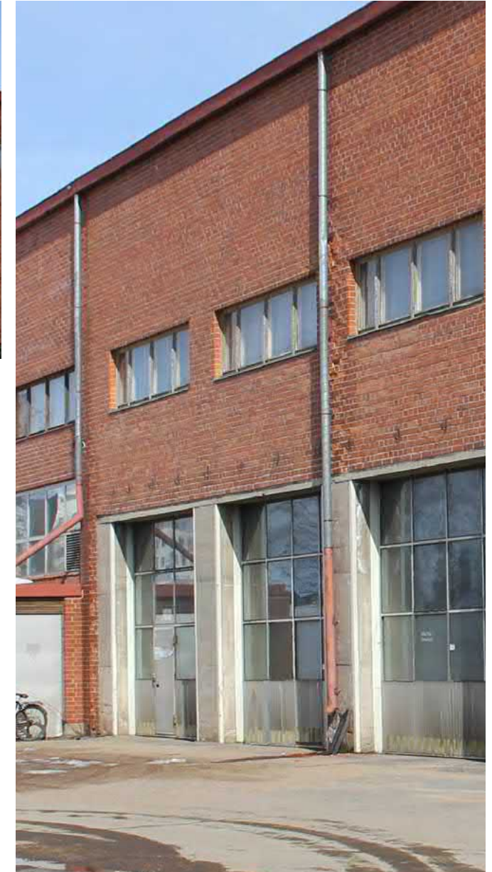
93. Pihan puolella syöksyt johtavat veden ajopihan kuivatusjärjestelmään.
