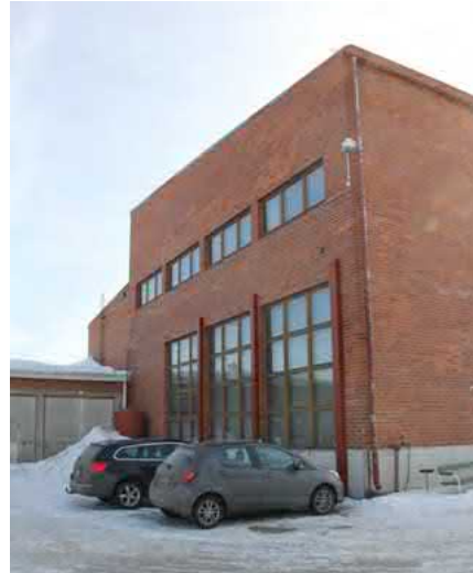
86. Vesihuollon päätyjulkisivun suuret ikkunat.
