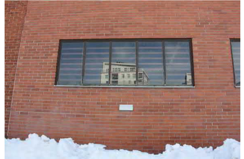
87. Autosuojan laajennuksen ikkunat vuodelta 1982.
