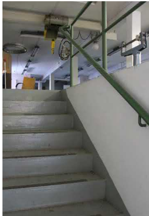
130. Kerrosten väliseen tavaroiden siirtoon käytettiin sähkövinssiä.
