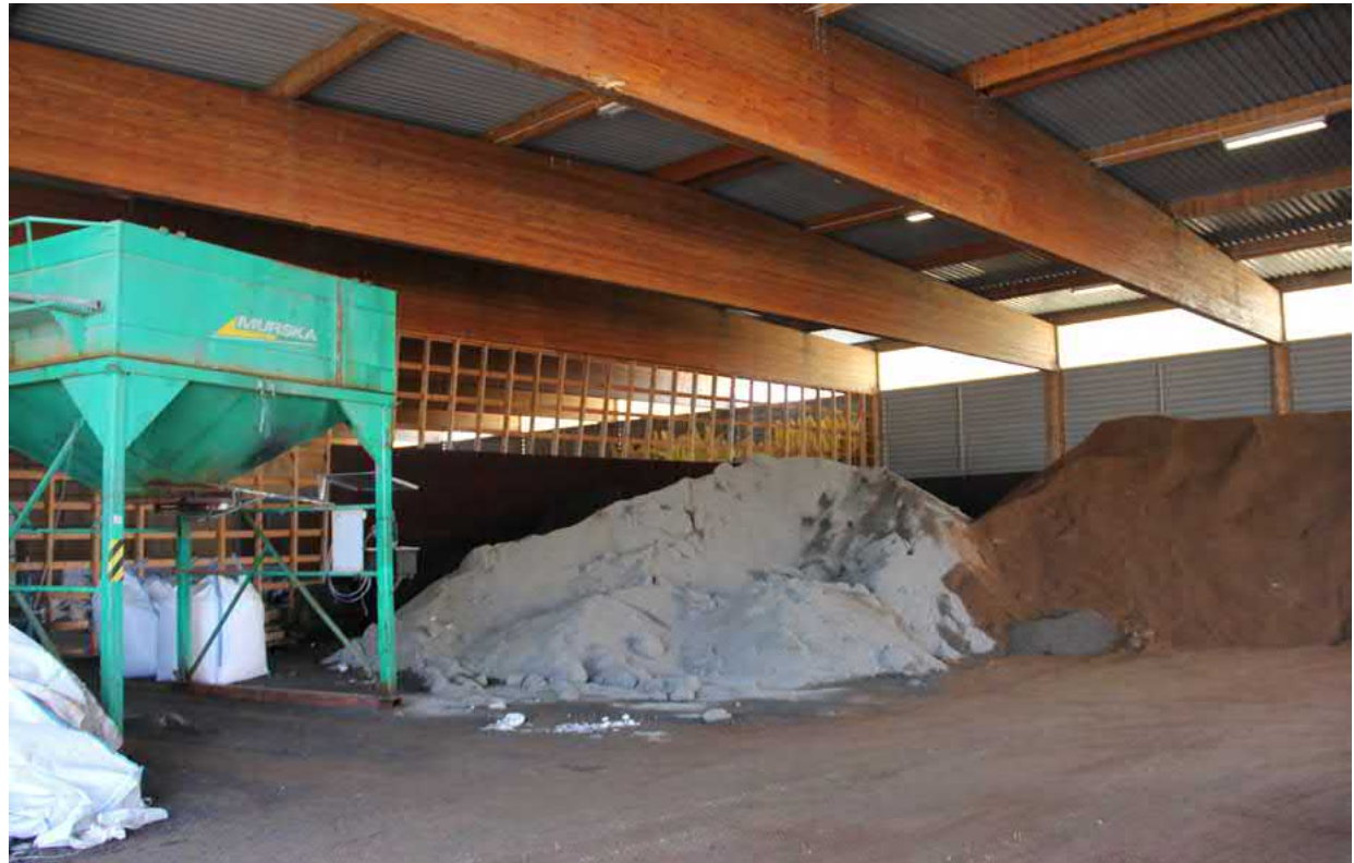
180. Varastohallin järeitä liimapuurakenteita.
