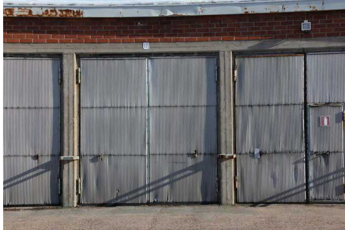
169. Autohalliin poimulevystä tehdyt teräsrunkoiset pariovet.
