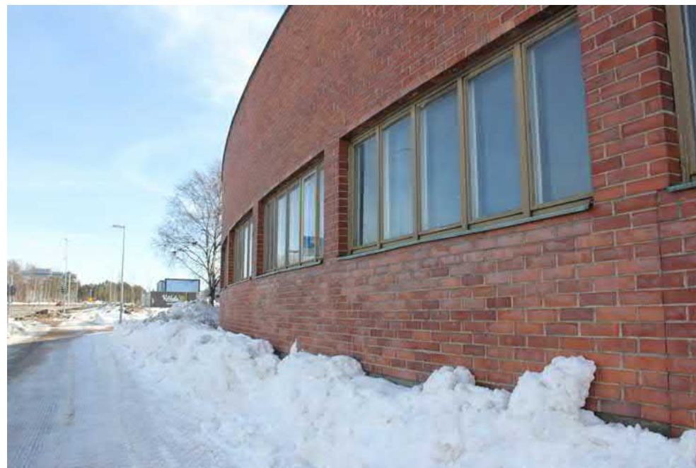
74. Laajennusosan julkisivuissa on 1970-luvulle tyypillinen tasalimitys.
