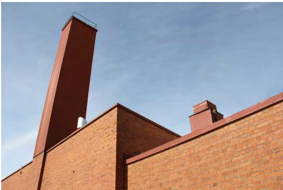
73. Vanhimman osan muurauksessa on käytetty ristilimitystä.
