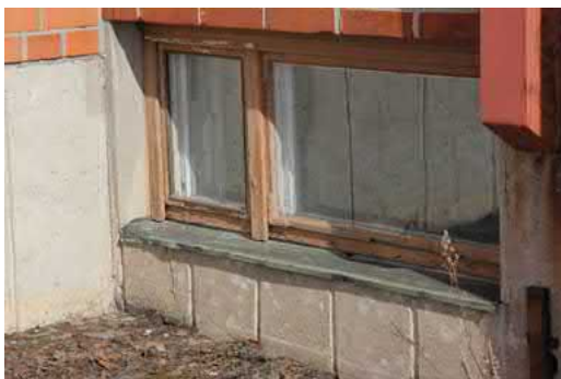
88. Alkuperäisiä puuikkunoita ja niiden kupariset ikkunapellit.
