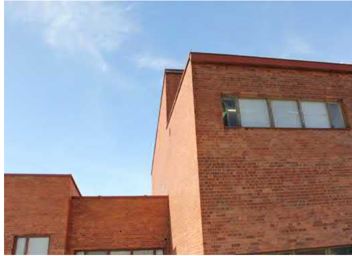
92. Katujulkisivuilla vesikatto on räystäätön. Korjaamon matalampi lape laskee kadun suuntaan.
