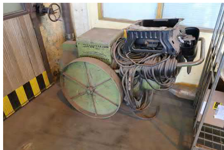
144. Korjaamon vanhinta konekanta.
