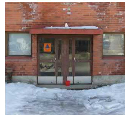
83. Käynti kadulta uuden korjaushallin tiloihin.
