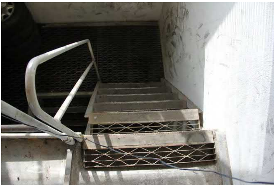
97. Huoltohallista kellariin johtavat alkuperäiset teräsportaat.
