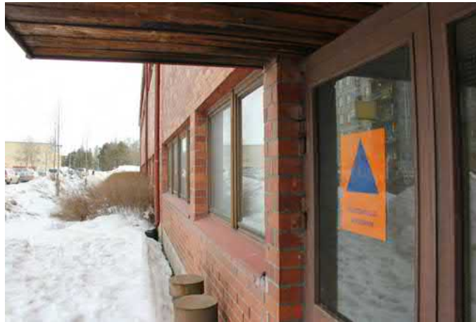
156. Väestönsuojaan ja entisiin Vesihuollon tiloihin on käynti kadun puolelta.
