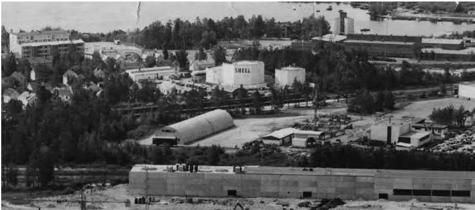
49. Kaupungin varikko pohjoisen suunnata otetussa Ilmakuvassa taustalla. Kuvassa varikon ensimmäinen ja toinen rakennusvaihe ovat toteutuneet. Tontin perällä on vuonna 1963 valmistunut hiekkasiilo.
