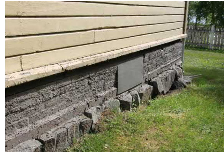
188. Lohkareista tehtyä perustusta on jatkettu muuraamalla.
