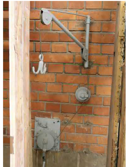
132. Alkuperäinen käsikäyttöinen vinssi.
