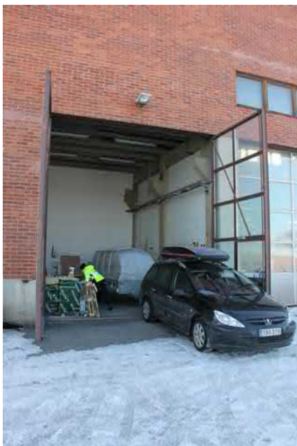
77. Vesihuollon hallin suuri pariovi.
