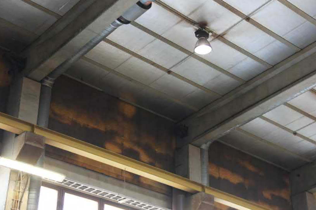
149. Uudemman korjaamohallin järeitä betonisia runkorakenteita.
