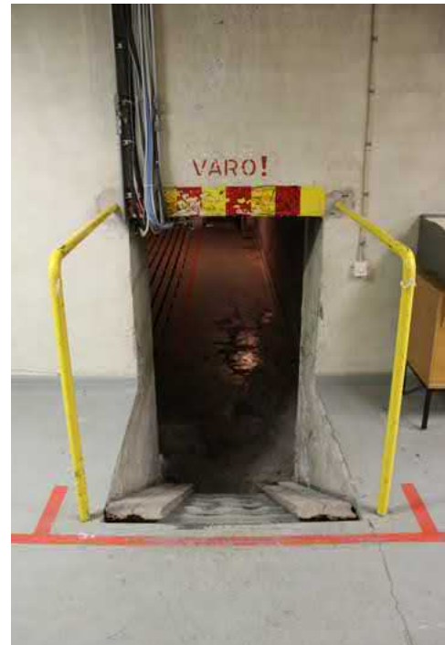
131. Kellarin varastosta johtaa yhteys alemmalla tasolla olevaan polttoainevarastoon.
