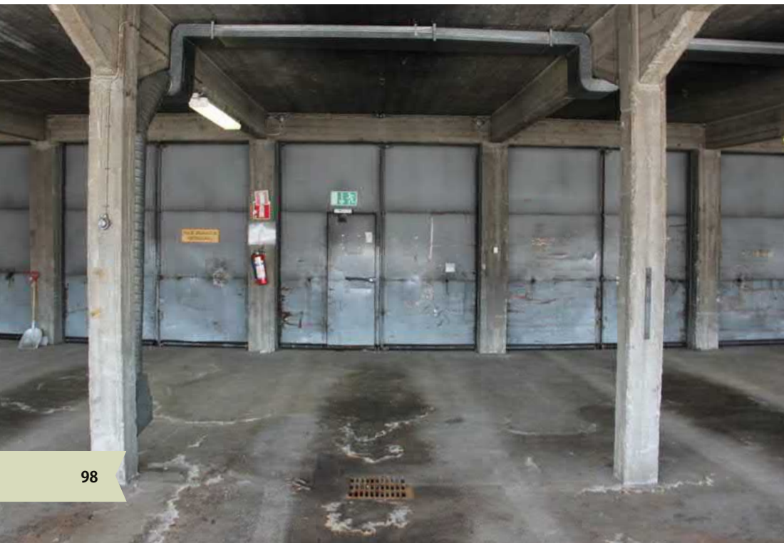
168. Hallin ovet sisäpuolelta.
