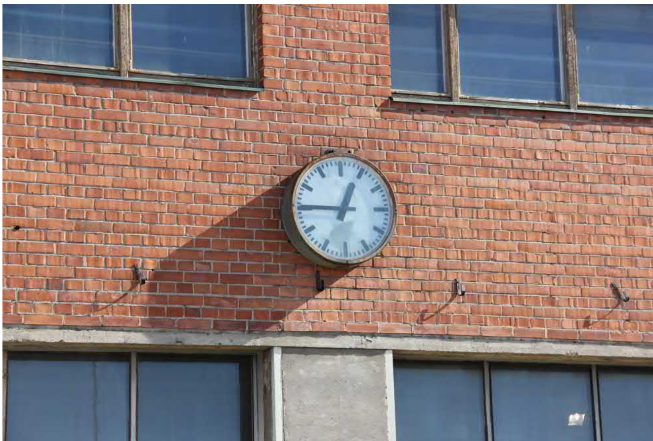
72. Varikon vanhemmassa korjaamohallissa on teräsbetonista valettu pilari-palkki-runko. Punatiilestä muurattujen julkisivujen keveys muodostuu siroista nauhaikkunoista. Detaljiikkaa edustavat myös kupariset ikkunapellit.
