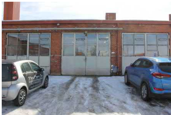
84. Käynti kadulta uuden korjaushallin tiloihin.
