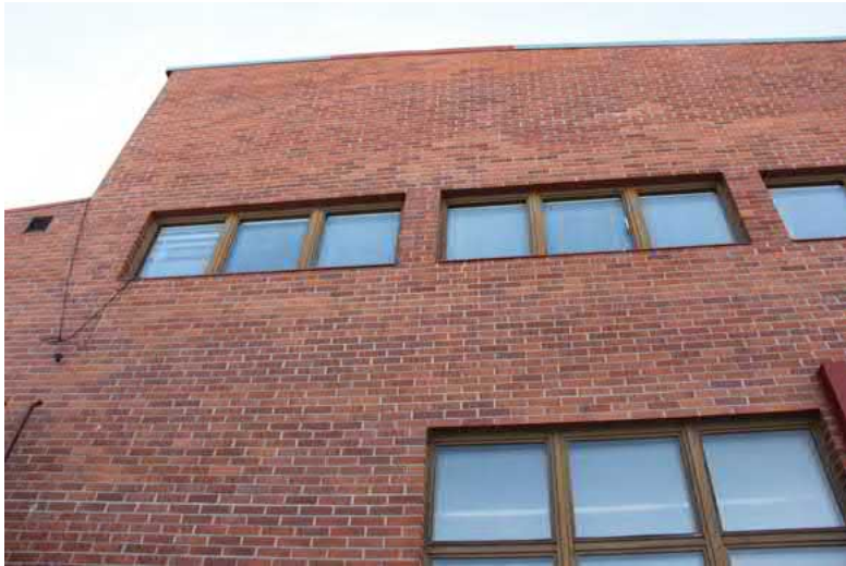
85. Alkuperäiset ikkunat korjaamon katujulkisivulla.
