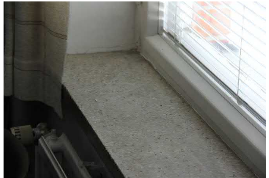
120. Ikkuna ja sementtimosaikkinen ikkunapenkki ovat alkuperäisiä.
