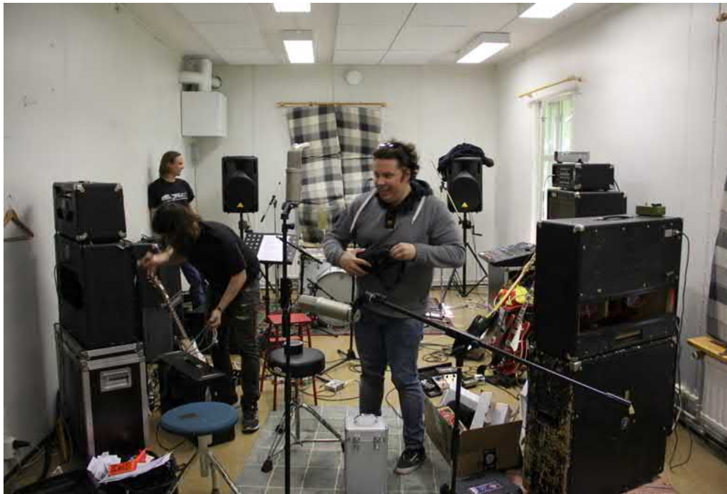
190. Sisätilat on riisuttu ja rakenteet on peitetty rakennuslevyllä ja muovimatoilla.
