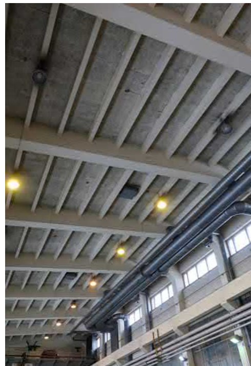
141. Kattoruoteiden väleissä on Toja-levyt.
