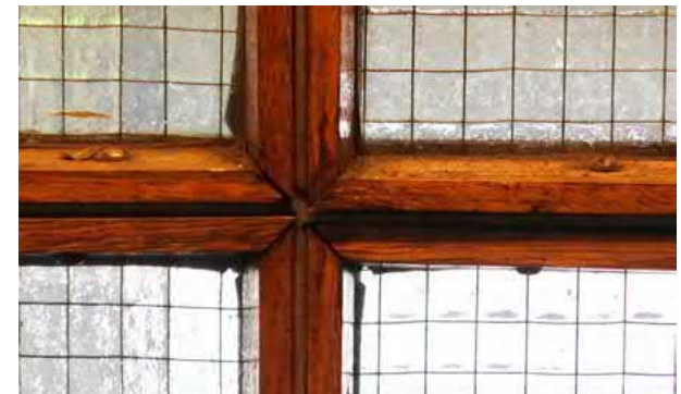
135. Rautalankalasi on kiinnitetty metallirunkoon siroin tammilistoin.
