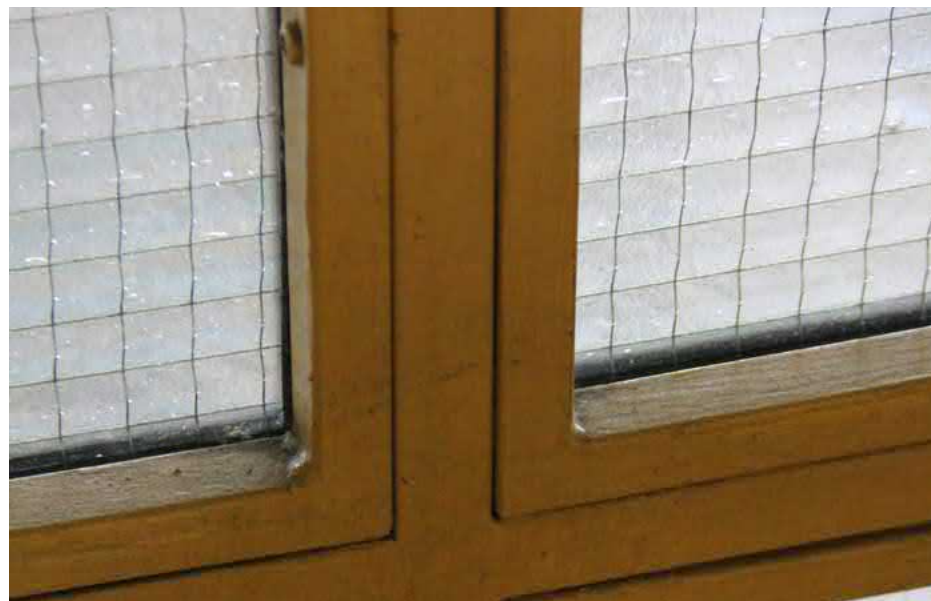
154. Laajennusosan parven ikkunadetaljit on tehty teräksestä ja ovat vanhempaan osaan verrattua yksinkertaisempia.
