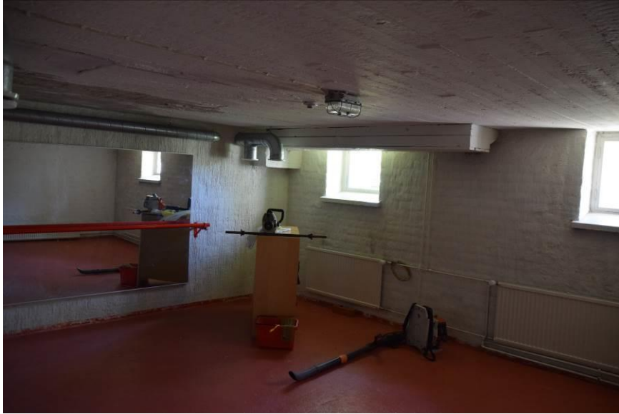
Kellarikerroksen varastotilaa. Alun perin tila toimi ulkoiluvälinevarastona.
