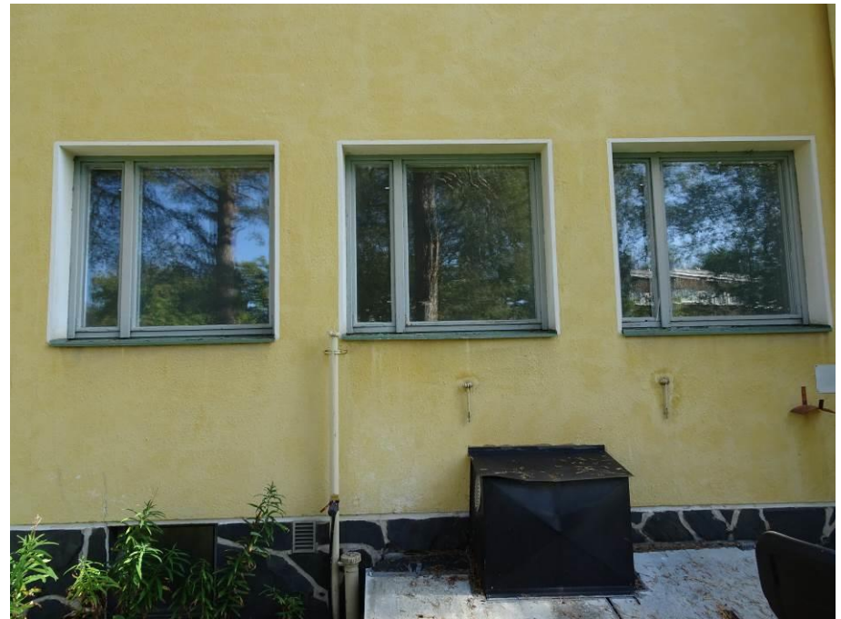
Rakennuksen ikkunoita. Ikkunat ovat säilyneet alkuperäisinä. Ylinnä vasemmalla olevassa kuvassa näkyy ilmastoinnin poistoilmasäleikkö. Alaoikealla on kellarin halkoluukku ja sen päällä ilmastoinnin poistokanava.
