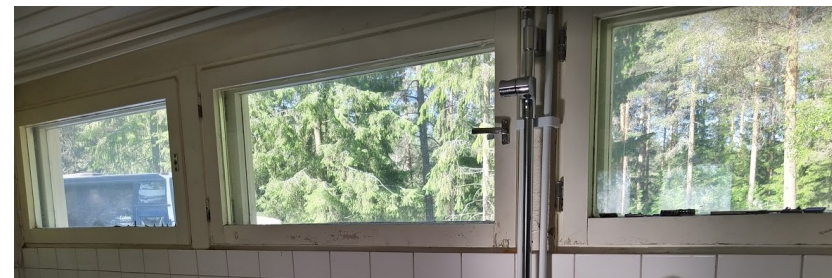
Kuva 59. Laajennusosassa peseytymistilan ikkunat.
