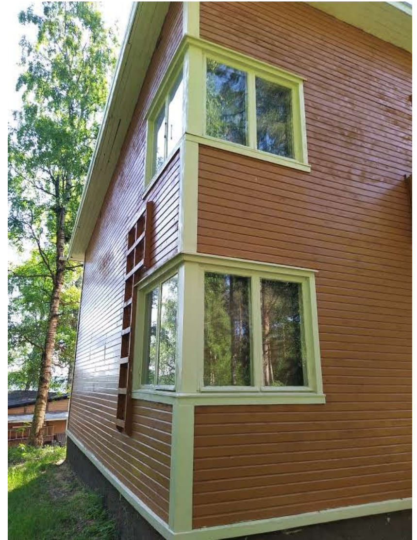
Kuva 13. Rakennuksen alkuperäisen osan kulmaikkunat.
