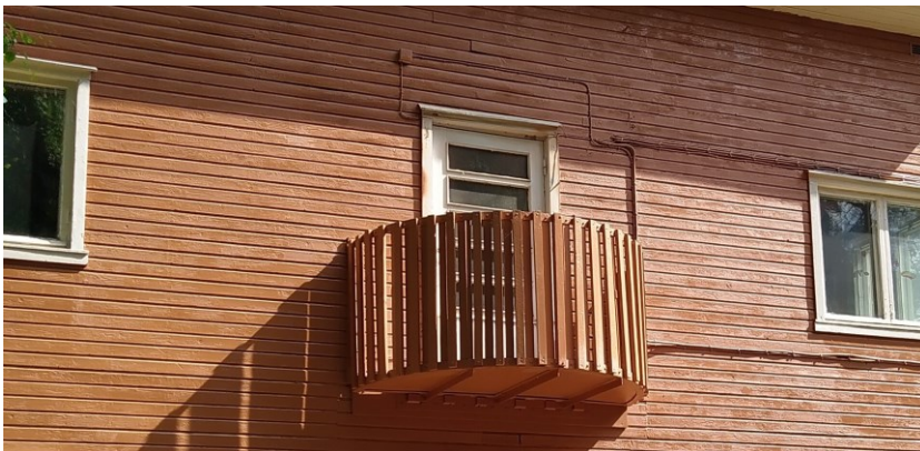
Kuva 37. Rakennuksen uusittu parveke.
