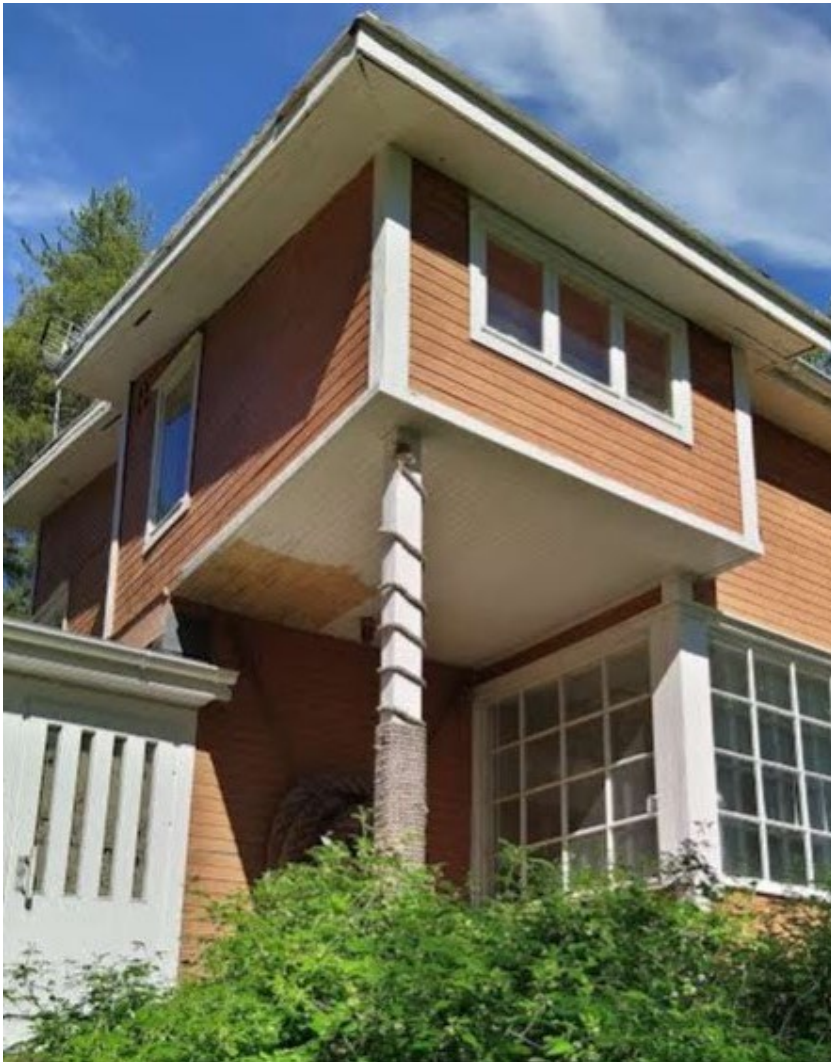
Kuva 10. "Linnunpönttö" -uloke.
