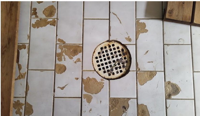
Kuva 53. Laajennusosassa sijaitsevan peseytymistilan laattalattiaa.
