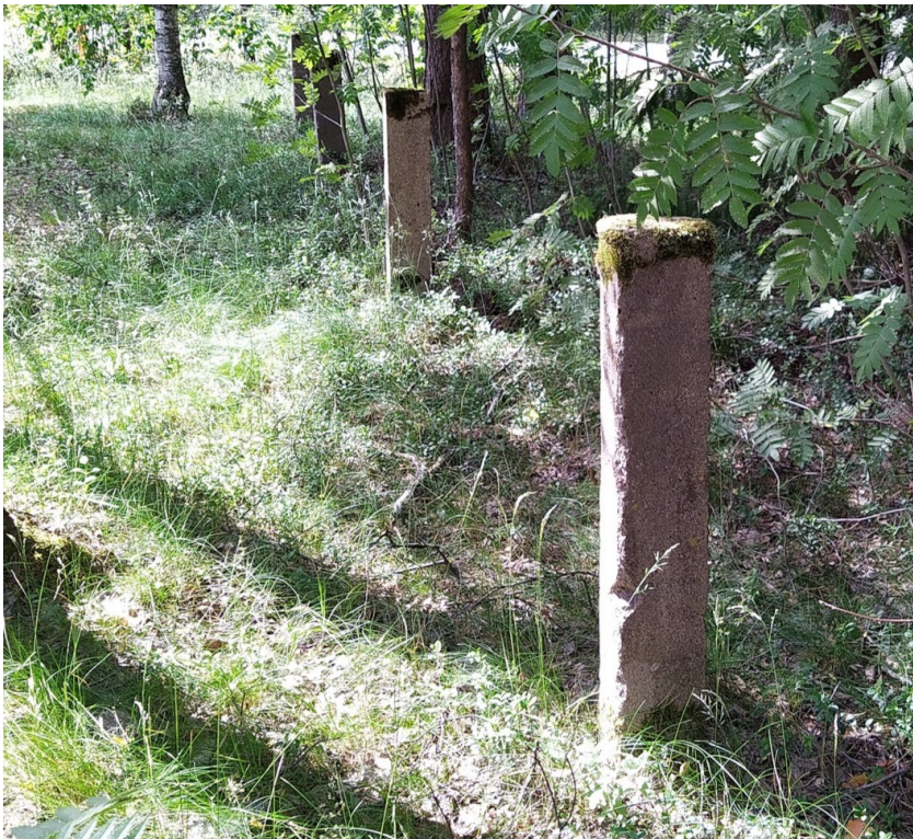
Kuva 29. Huvilarannantie 28:n rajaamat betoniset aitapylväät.
