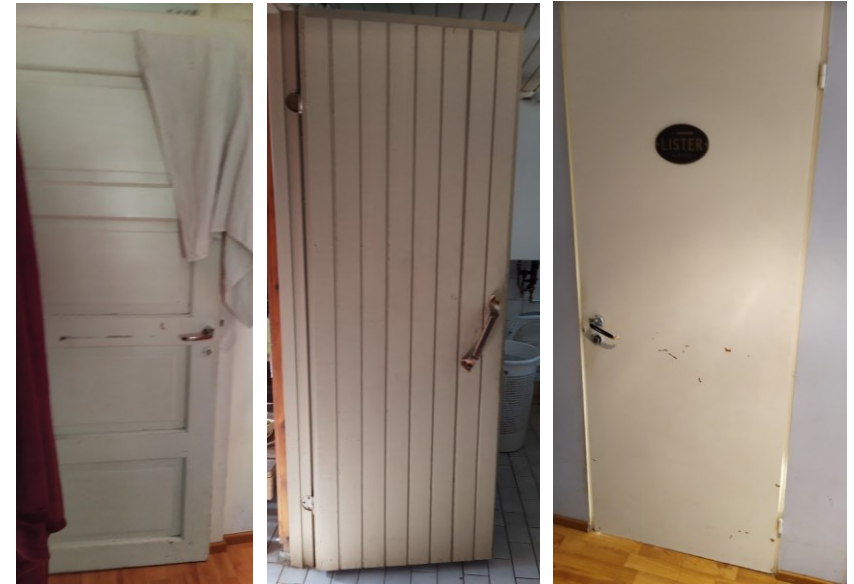
Kuvat 54, 55 ja 56. Rakennuksen väliovia.
