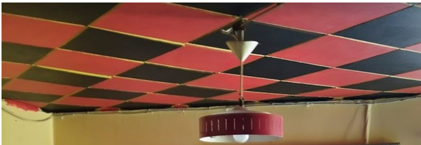
Kuva 46. Yläkerroksen toisen huoneen värikäs alakatto.
