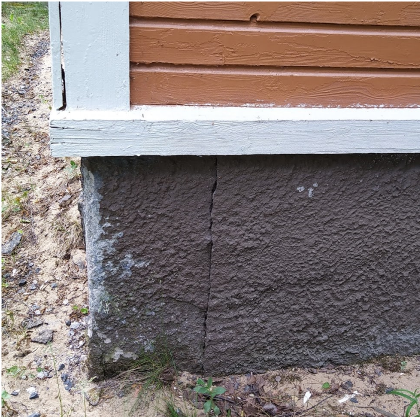
Kuva 35. Vanhemman rakennusosan pilarianturaperustus.
