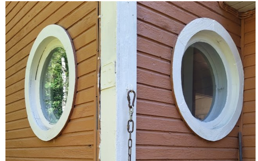
Kuva 38. Rakennuksen alkuperäisen osan pyöreät ikkunat.
