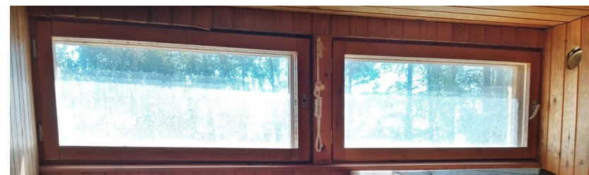
Kuva 60. Laajennusosassa saunan ikkunat.
