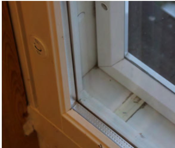
Alkuperäiset ikkunat on korvattu puisilla MSE-ikkunoilla.
