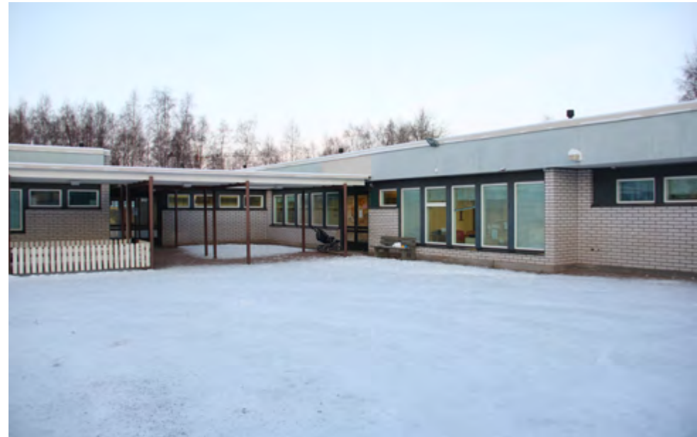
Näkymä atriumpihalta pääsisäänkäynnin suuntaan. Alkuperäinen sadekatos yhdistää sisäänkäynnit.
