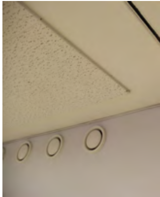
Ilmanvaihtventtiilejä eri aikakausilta
