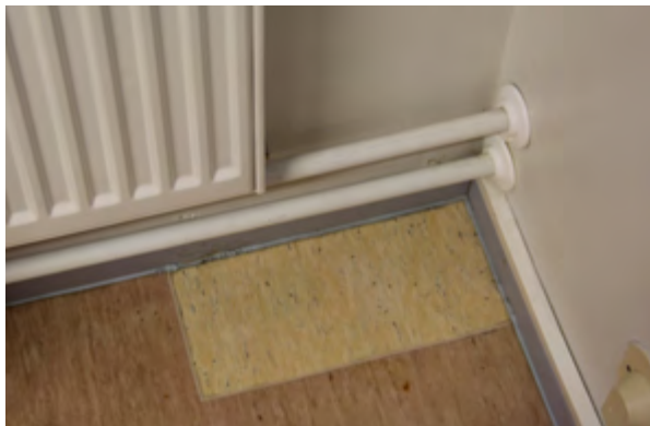
Lämmitysputket on siirretty lattialaatasta katonrajaan. Yläkuvassa kotelo.
