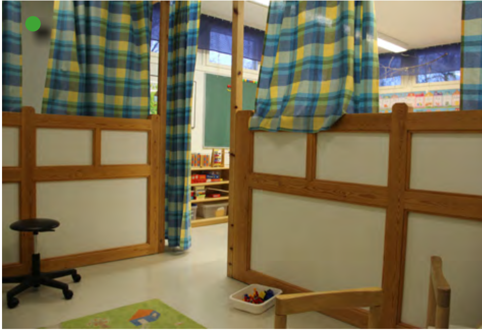
Kevyellä väliseinällä erotettu leikkutila sisäpuolelta.
