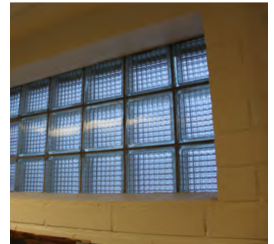
Käytävän yläikkuna on tehty INSULUX-lasitiilistä.
