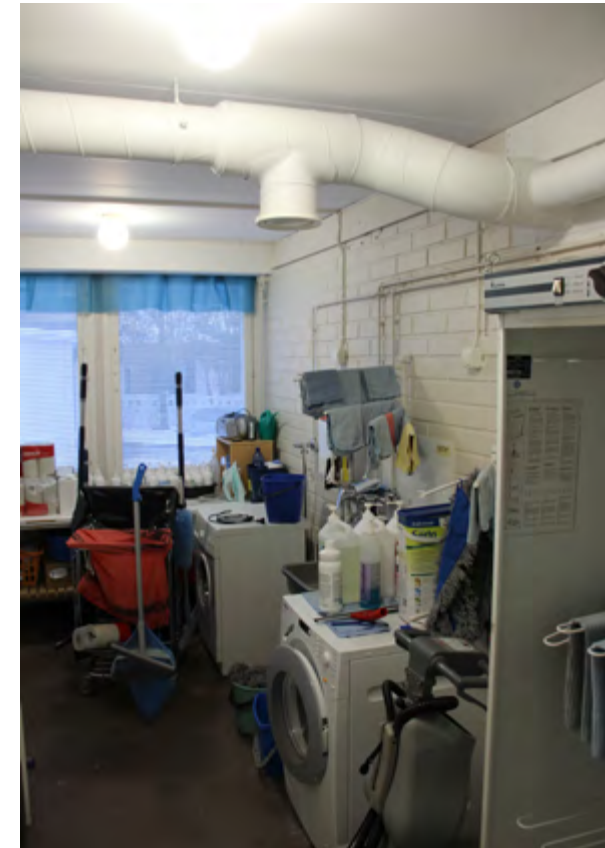
Vaatehuoltotilassa käsitellään päiväkodin liinavaatteet.
