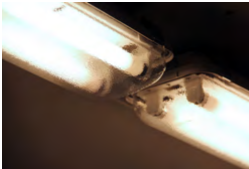
Alkuperäisiä valaisimia ja sähkökalusteita.
