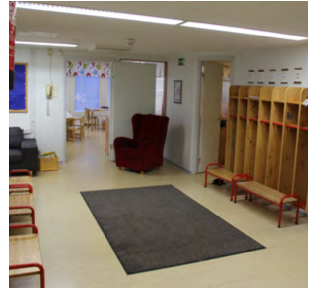
Uusimmat jonovalaisimet on upotettu alakattoon.
