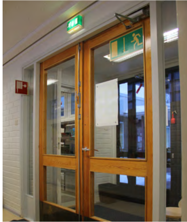
Alkuperäinen pääsisäänkäynnin väliovi.
