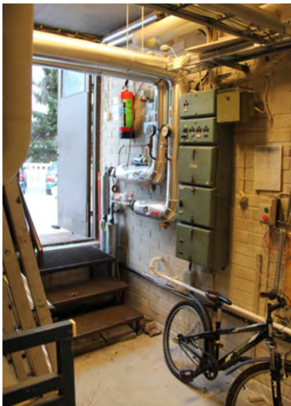
Lämpökeskuksen lattia on 600 mm maanpinnan alapuolella.
