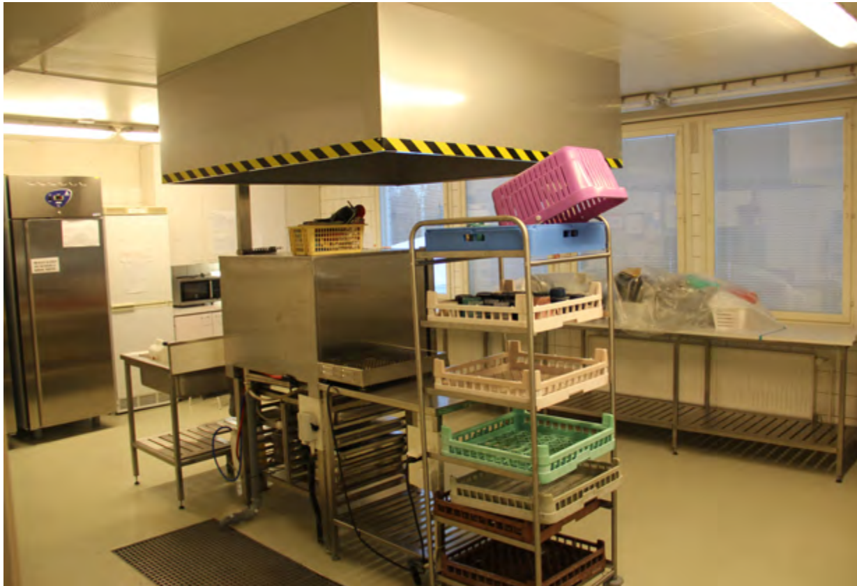
Keittiö on muutettu valmistavasta jakelukeittiöksi. Keskeisiä koneita on poistettu. Lattialaatat on poistettu ja tilalle on tehty epoksinnoite.
