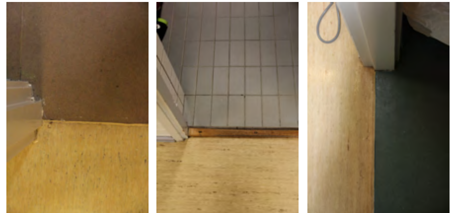
Lattiamateriaaleja kynnyksiltä kuvattuna. Alkuperäinen lattia oli tummansininen ja lattialaatat kuusikulmaisia.
