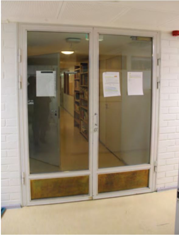
Huoltosiipeen johtavan käytävän teräksinen palo-ovi on alkuperäinen.
