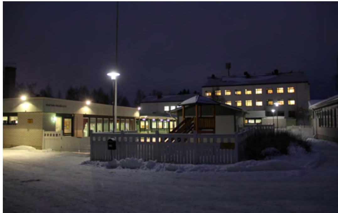
Hintan päiväkoti on yksikerroksinen ja siinä toimii viisi kokopäiväistä ryhmää sekä ryhmäperhepäiväkoti. Päiväkodin taustalla näkyy Hintan ala-aste.
