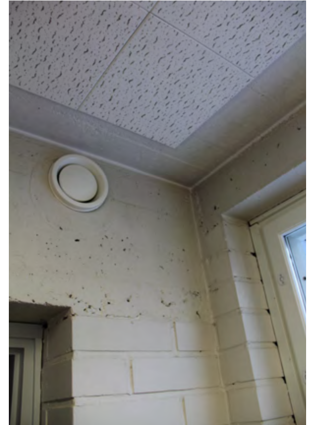
Pääsisäänkäynnin yhdyskäytävä on muurattu ja holvattu.
