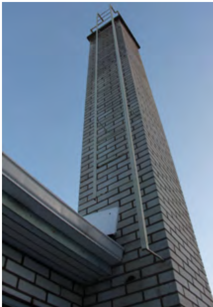
Lämpölaitoksen piippu on käyttämätön.
