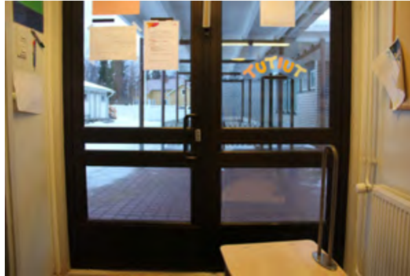
Puiset ulko-ovet on vaihdettu alumiinisiin.
