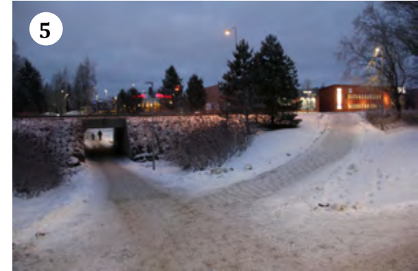
Vaalantien alittava pyörätie johtaa Kynsilahdon kaupunginosaan.
