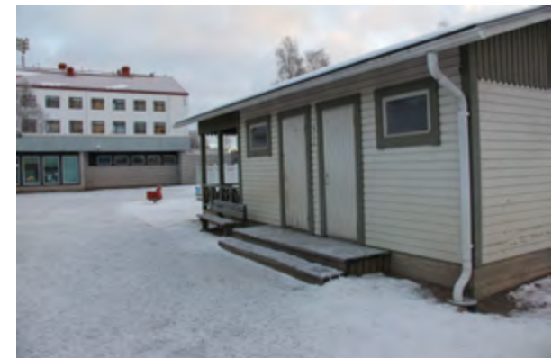
Pihavarasto rakennettiin uima-altaan paikalle.
