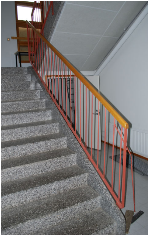
Laajennusosan portaikon kaide.
