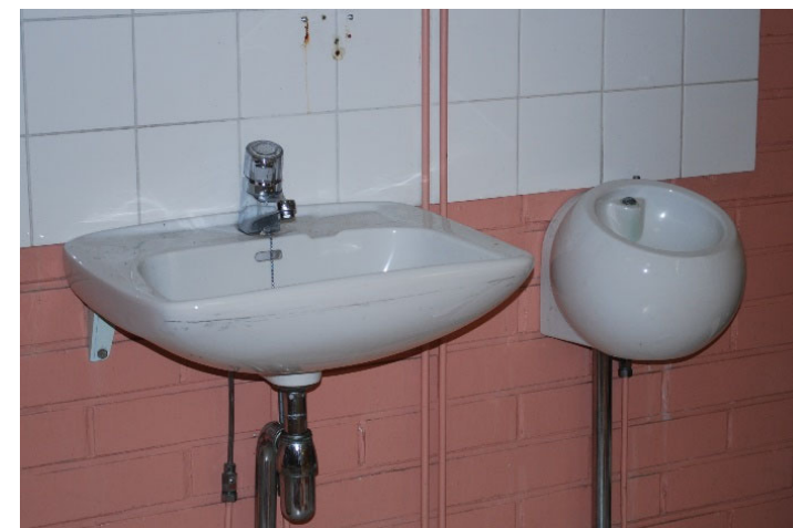
Käytävien ja luokkien vesikalusteet on uusittu ilmeisesti vuoden 2007 tekniikkaremontin yhteydessä.
