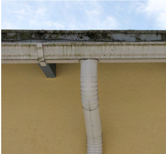
Pohjoissivulla on 1990-luvun kantikas vesikouru.
