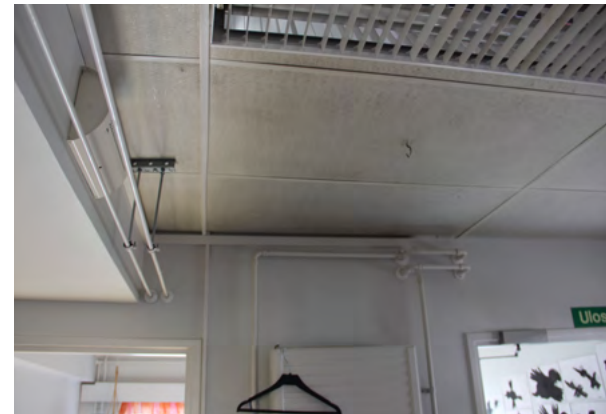
Talotekniikkaa risteilee seinillä ja katoissa.
