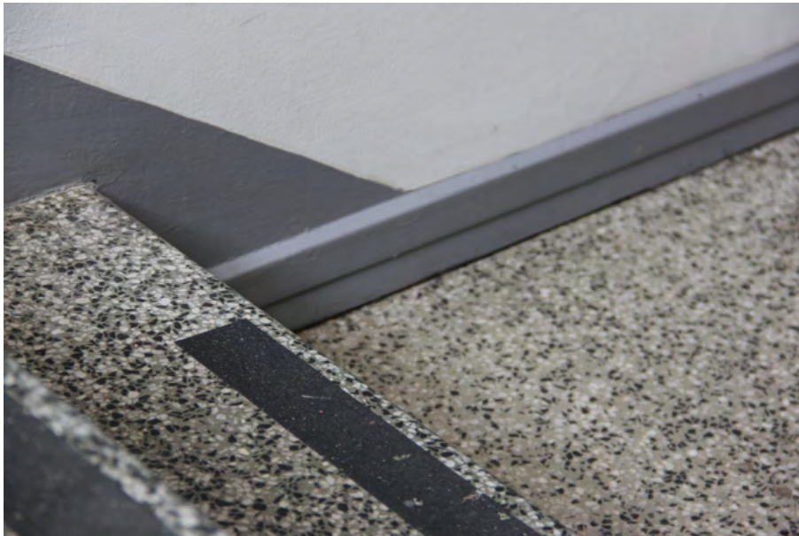
Sementtiosaaiikkipintainen lattia ja porras.
