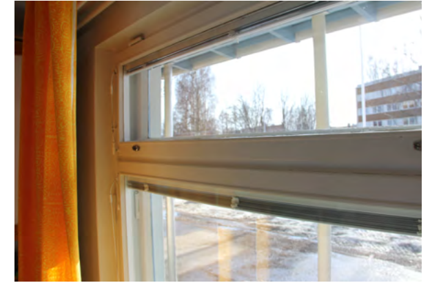
Yläosastaan avautuva ikkuna päivähoito-osastolla.
