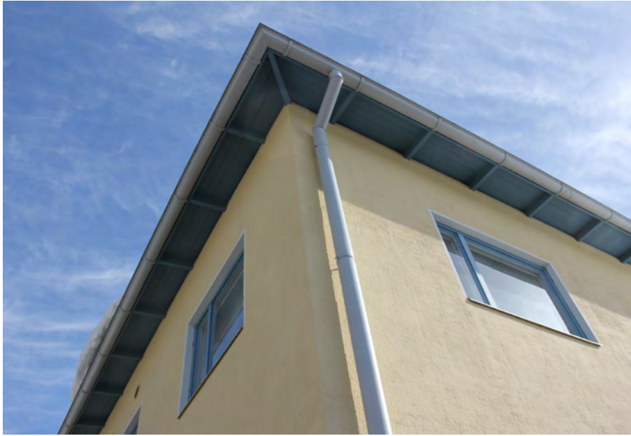
Kaksikerroksisen osan rapattua seinää etelä- ja länsisivuilta.
