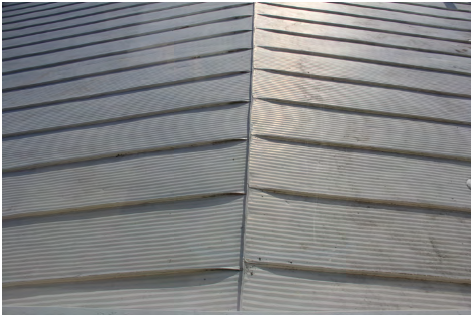
Konesaumattu vesikate on tehty galvanoiduta teräspellistä. Kate on alkuperäinen.
