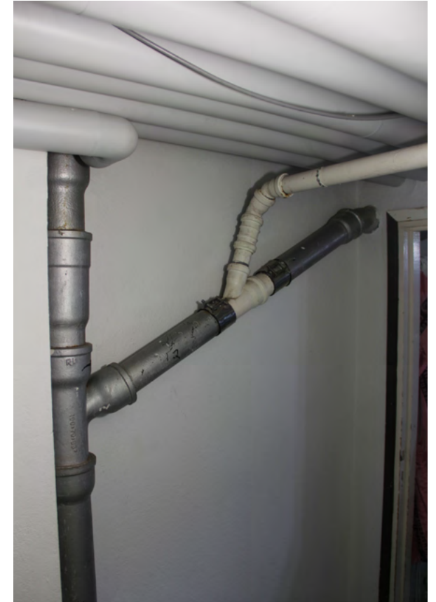
Valurautainen viemäri on alkuperäinen. Siihen on tehty lukuisia lisäyksiä.
