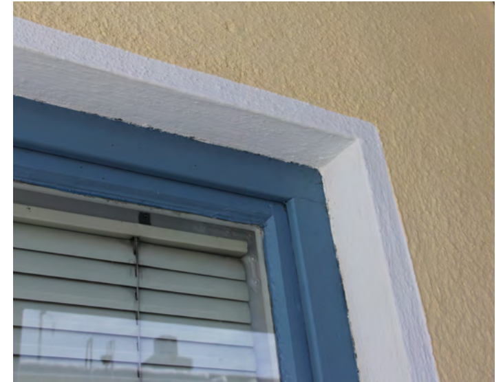
Karmit on istutettu julkisivurappaukseen, johon on maalattu valkoinen kehys.
