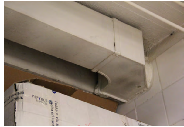
Kellarista löytyy vielä alkuperäisiä ilmanvaihtokanavia.
