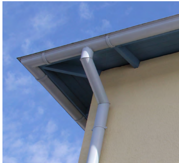
2000-luvun vesikouru on puolipyöreä. Syöksyt ovat myös pyöreät.
