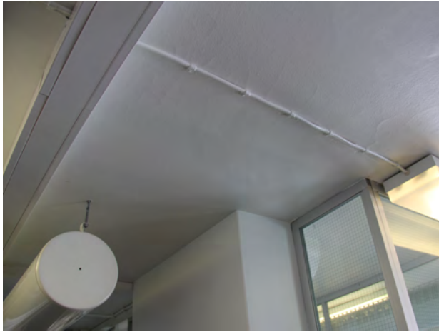
Tasoitettu ja maalattu betonikatto keittiöstä.
