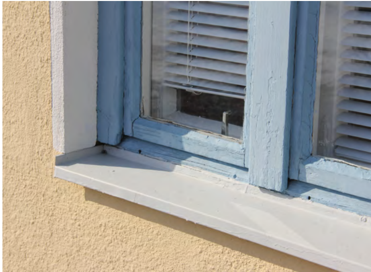
Ikkunat ovat alkuperäisiä. Puuosat ovat paksun maalikerrostuman alla.
