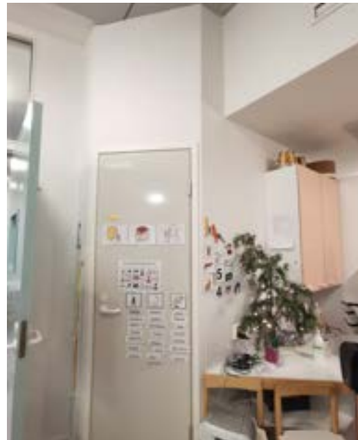
Alkuperäinen ovi, varasto (03) harmaa NCS S 0901-Y10R Kuva: Juho Turpeinen 2024
