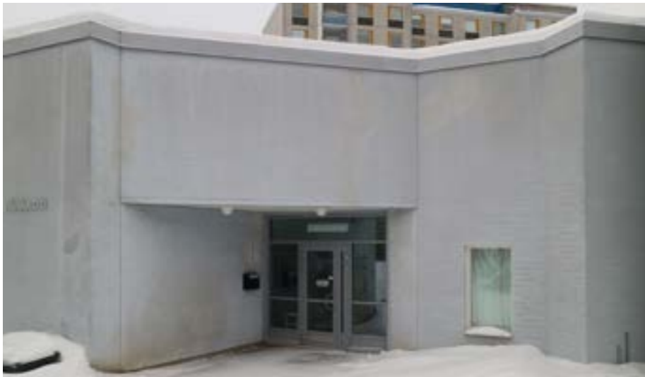
Alunperin rakennusta jakoi kahteen osaan tunnelimainen kylmä käytävä, jotta silloiset palomääräykset täyttyisivät. Palomääräyksissä ollaan sittemmin joustettu ja tila ollaan voitu muuttaa sisätilaksi. Kuva: Kim Ramsay 2024.
