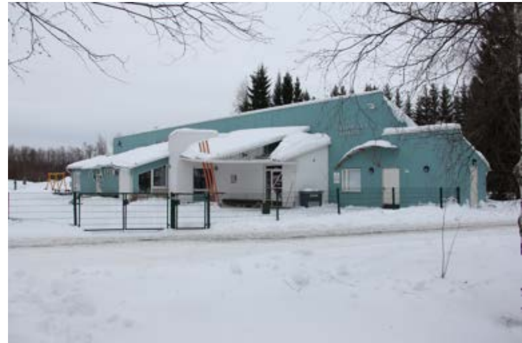
Korkea keskimassa muodosti rakennuksen selkärangan ja sen kaarevat ulokkeet, tekivät siitä omintakeisen. Kuva: Veli-Pekka Huhmo, Arkkitehtitoimisto Jorma Teppo, 2019
