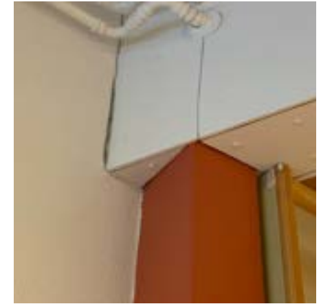
Vaurio 1. Ratkeama palkin koteloinnissa. Huone 13. Adele Pikkuaho 2024.
