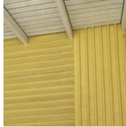
Julkisivun loma- ja vaakalaudoitusta. Katja Maaninka 2024
