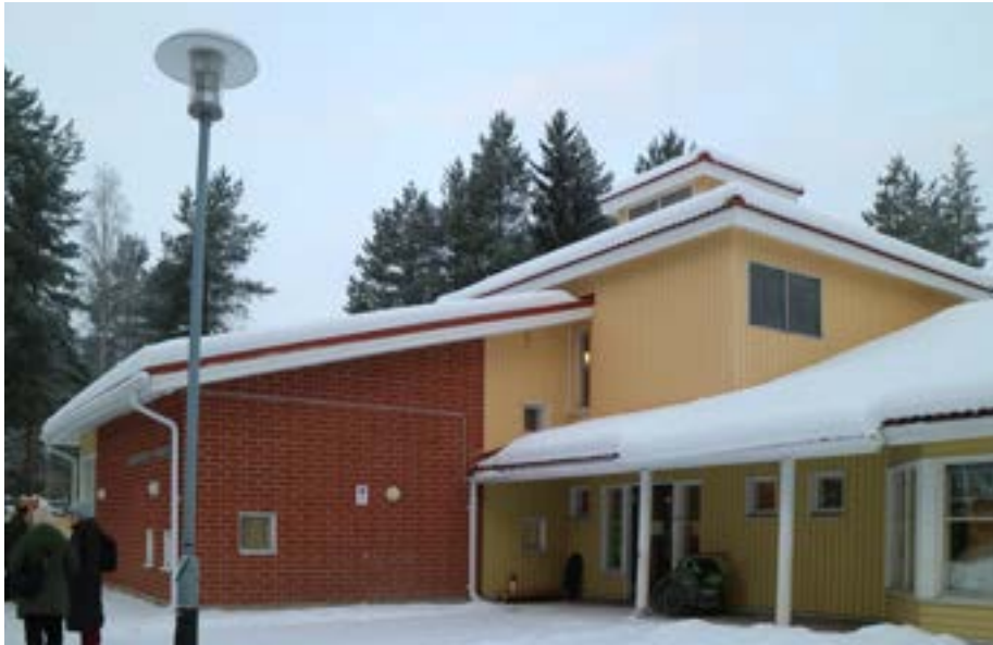
Päiväkodin torniaihe on rakennuksen hahmolle ominainen piirre. Julkisivussa vaihtelevat keltaiseksi maalattu puuverhous sekä punatiili. Kuva: Kim Ramsay, 2024.
