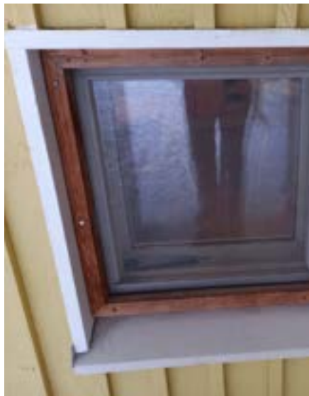
6. Karmit ovat maalaamatta yksittäisessä ikkunassa. Kuva: Kirsikka Lehtiniemi 2024
