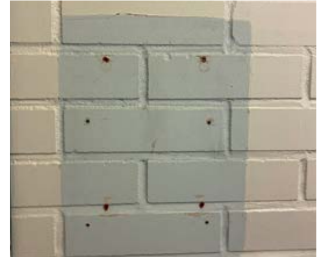
Pesuhuoneen (08) seinä Kuva: Violet Raitala 2024
