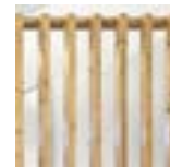
Rimaseinä 40x40, väli 150 mm
