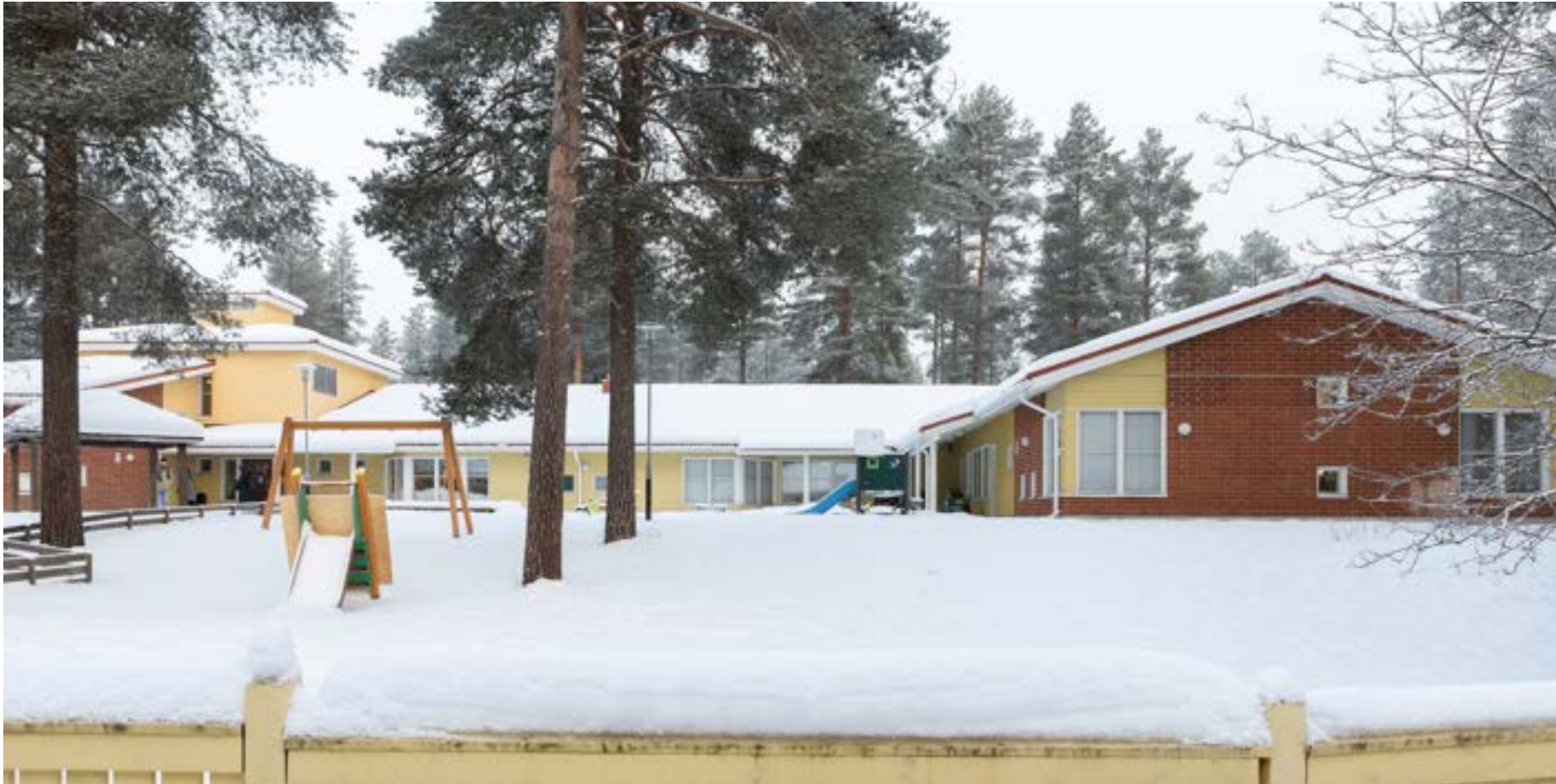
Kangaskontion päiväkodin pääjulkisivu Kuva: Juho Turpeinen 2024
