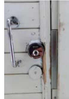
Kuvassa eteläisen varaston ovi. Molempien varastojen ovien lukkopesät ovat kuluneet. Kuva: Kirsikka Lehtiniemi 2024
