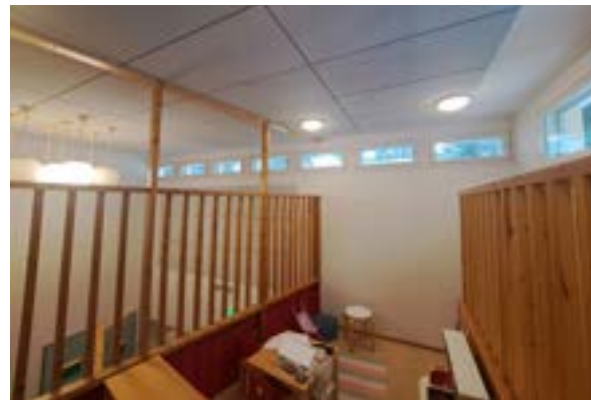
Vaate-eteisen yläpuolella oleva leikki-parvi, portaan vieressä olevaa kaidetta on korotettu, ja sisäkaton akustiikkalevyt on vaihdettu. 57 Parvi. Kuva: Sonja Juutinen 2024
