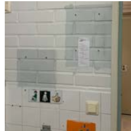
Vaurio 39. Vanhoja maaleja sekä kiinnitysreikiä seinissä. Huone 21. Kuva: Salli Nokelainen 2024.
