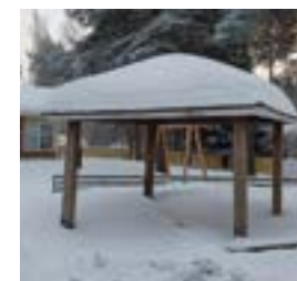
6. Vanhan mallin mittasuhteilla tehty uusi katos
