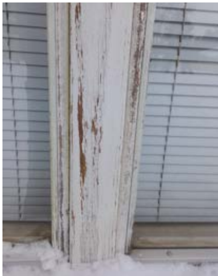
5. Esimerkki eteläisten ikkunankarmien tyypillisestä kulumasta. Kuvat: Kirsikka Lehtiniemi 2024
