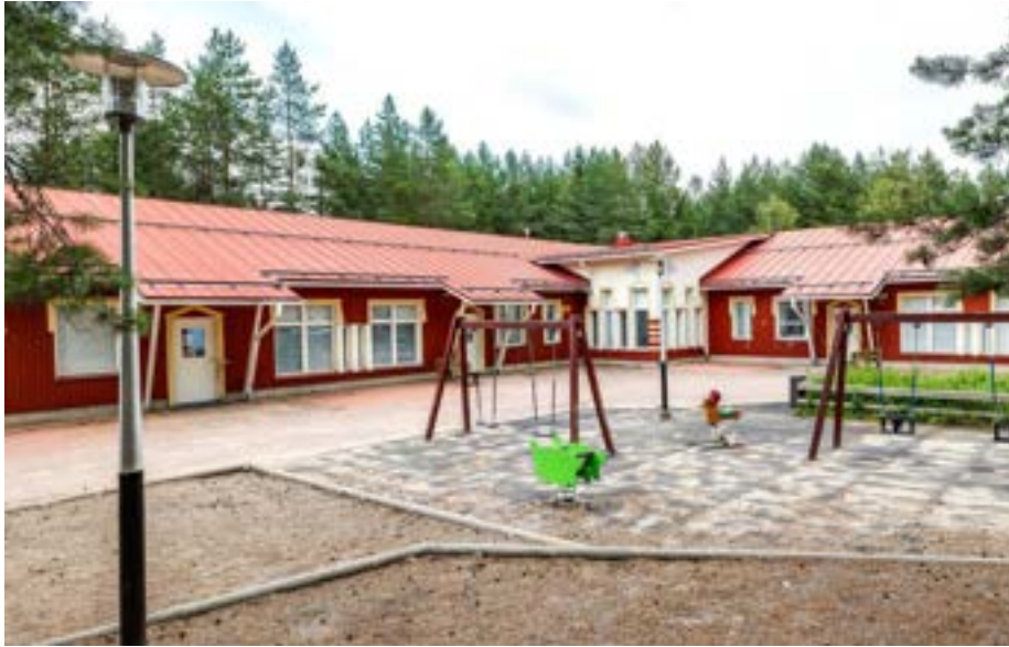
Voimakkaan punainen pystylaudoitus on piirteenä regionalistinen ja keltaiset ikkunan- ja ovenkarmit leikkisästi sommiteltuja. Kuva: Oulun kaupunki, vuosi tuntematon.
