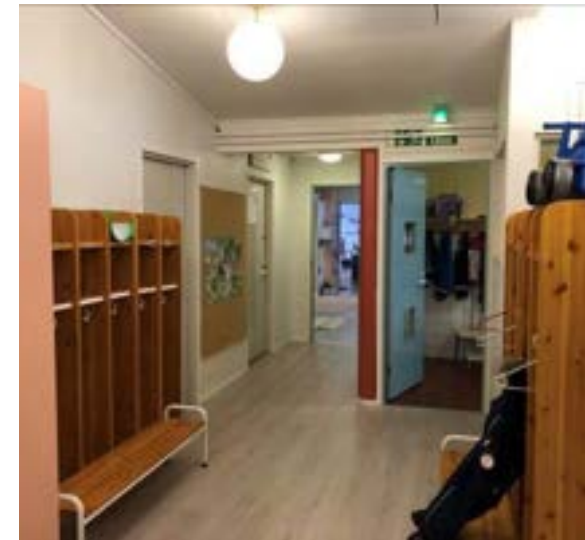
Kuraeteisen alkuperäinen keltainen väritys, nykyisellään se on maalattu umpeen. Kuva: Kangaskontion päiväkodin kosteus- ja sisäilmämatutkimus 2020
