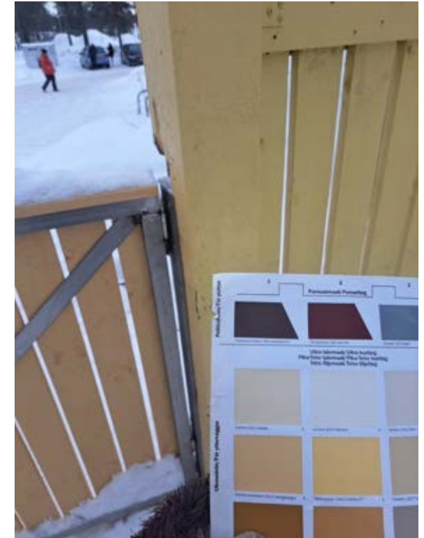
Pihan pääportin ja aidan välillä on sävyeroa: etualalla Kangaskontion päiväkodin rakennusvuoden talomaalikartasto 1988 ja julkisivujen alkuperäinen Kartanonkeltainen -sävy.
