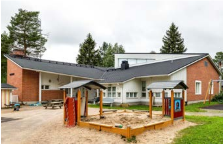
Pienen päiväkodin julkisivut on jaettu erilaisiin punatiilellä ja valkoisella puupaneelilla verhoiltuihin osiin. Ikkunat ovat monimuotoisia. Kuva: Oulun kaupunki
