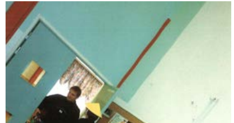
Alun perin seinissä käytetty turkoosi värisävy oli lähellä ovien sävyä, mutta ilmeisesti hiukan vaaleampi, joko tarkoituksella tai johtuen erilaisista maalityypeistä. Kuva: Pirkko Tikkanen
