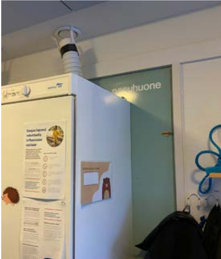
Kuraeteiseen (15) johtava pesuhuoneen ovi on peitetty kuivauskaapilla. Kuva: Violet Raitala 2024.
