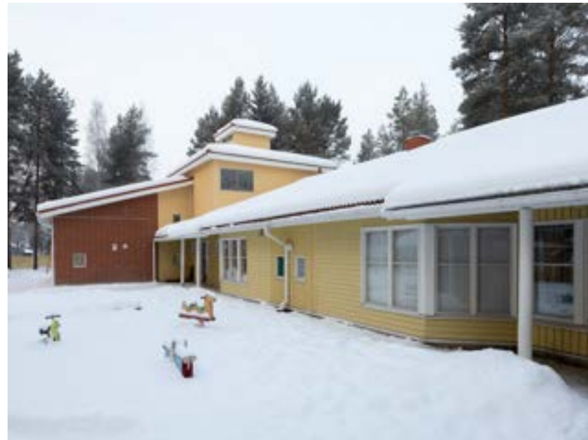
Kuva: Pääjulkisivun torniaihe, Juho Turpeinen 2024
