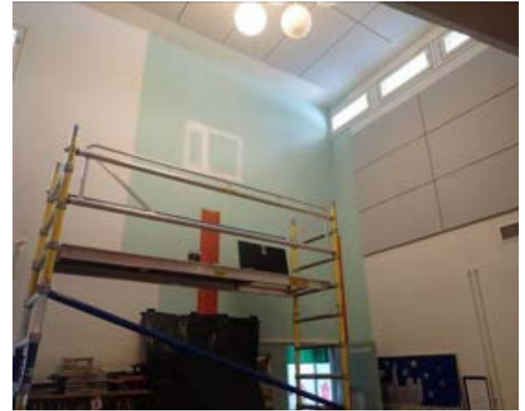
Vaate-eteinen II alkuperäisiä värejä vuonna 2022. Toisen seinän akustiikkapaneelit ovat myöhempi lisäys. Seinässä näkyy kuntotutkimuksen yhteydessä tehdyn rakenneavauksen kohta. Paikkausten peittäminen saattoi olla osasy seinien valkoiseksi maalaamiselle seuraavana vuonna. Kuva: Kosteus- ja sisäilmatekninen kuntotutkimus 2022
