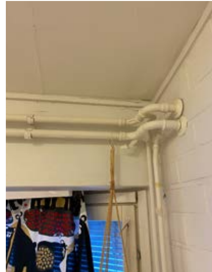
3. Kattolistan ja seinän maalipinnassa on halkeamia. Kuva: Hilda Peltokorpi 2024
