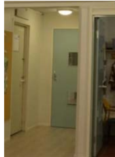
Jälkikäteen lisätty ovi (käyt. 51). Muutoksessa on kunnioitettu rakennuksen tilallista ilmettä
