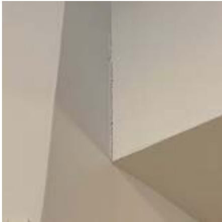
Katto, maalattu Gyproc-levy, Adele Pikkuaho 2024
