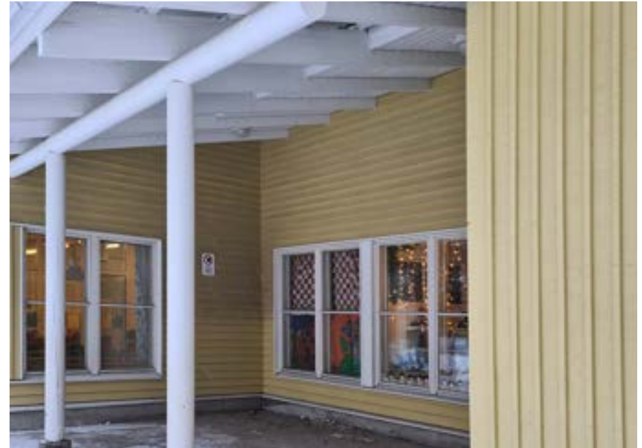
Eri muotoisia ruutuikkunoita ja vaihtelevaa laudoitusta. Rakennuksen länsipäädyssä. Kuva: Petteri Hiltunen 2024
