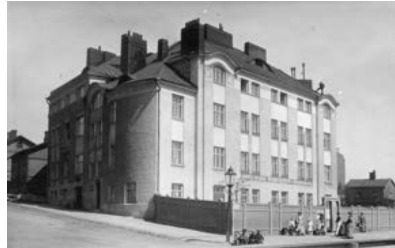
Kuva 6. Jugendtyyliä edustava 1908 valmistunut Ebeneser-talo oli ensimmäinen lastentarhaksi suunniteltu rakennus Suomessa. Arkkitehti Wivi Lönn halusi korostaa lapsille suunnatussa talossa kodikkuutta ja inhimillisyyttä. Kuva: Lastentarhamuseo (Finna.fi).
