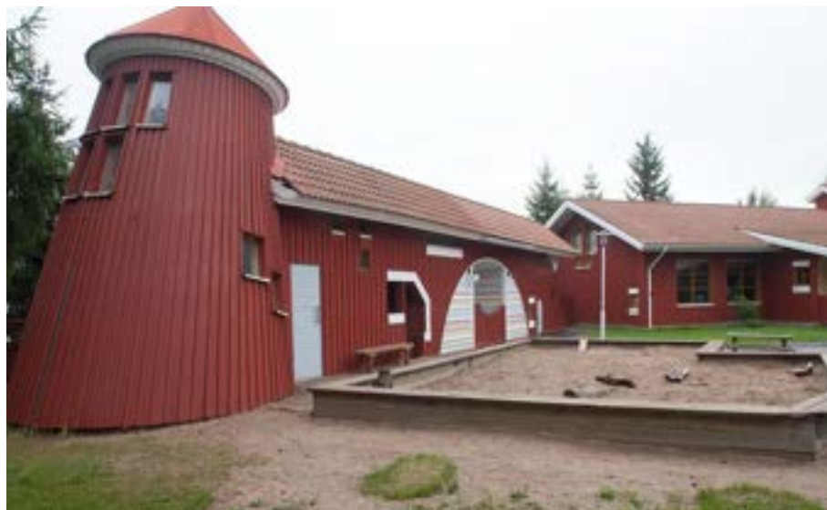
Oulun koulu ilmenee erityisesti rakennuksen massassa sekä pintojen sommittelussa ja materiaaleissa 25 . Saloilan Päiväkoti (1986) Kuva: Anni Vartola 2014
