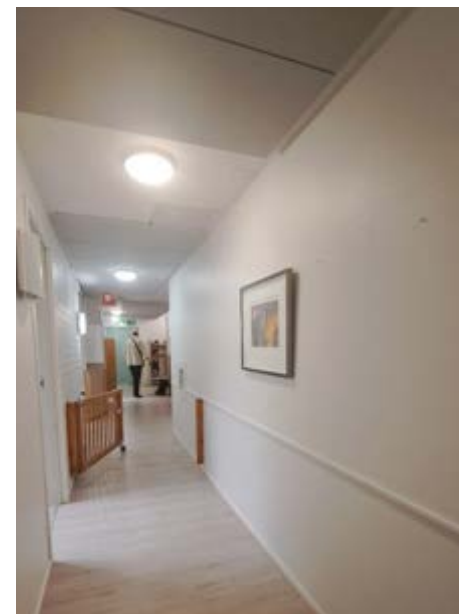
Kangaskontion päiväkodin käytävätila vuonna 2024: käytävän listat ovat pääosin hyvässä kunnossa. Kuva: Sonja Juutinen, 2024
