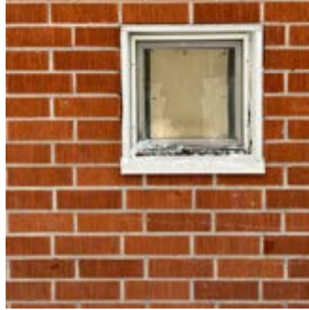
Julkisivun tiilipintaa. Katja Maaninka 2024
