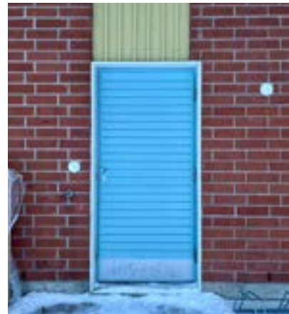
Rakennuksessa on säilynyt yksi alkuperäisistä puu-ulko-ovista. Katja Maaninka 2024
