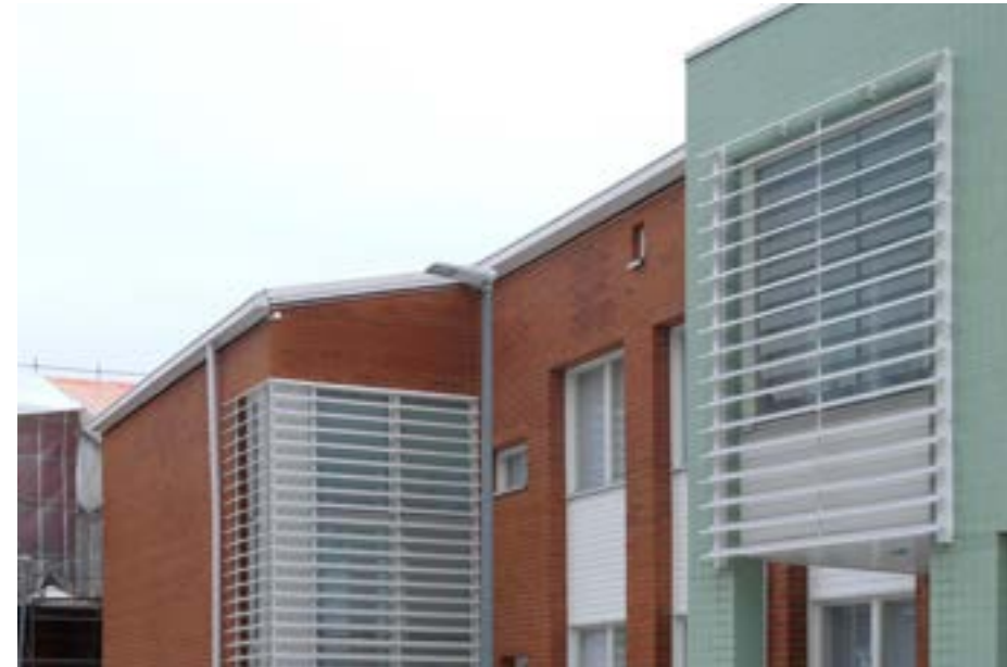
Maikkulan yläasteen peruskorjauksessa vaihdettuja ja lisättyjä ikkunoiden metalliritilöitä. Kulmaikkunan ritilöitä ei aiemmin ollut, mutta kokonaiskuvassa muutos on huomaamaton. Kuva: Lauri Antila 2024
