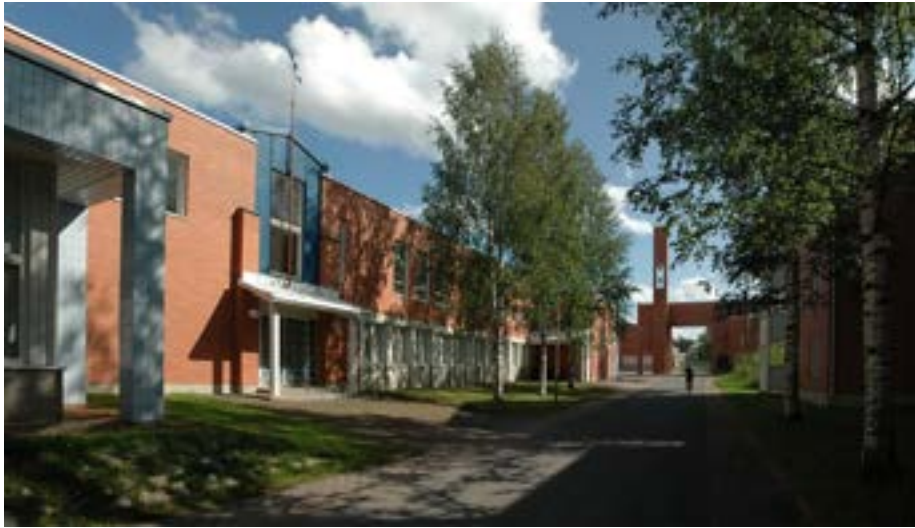
Maikkulanraittia. Kuva: Harri Rynnänen 2014
