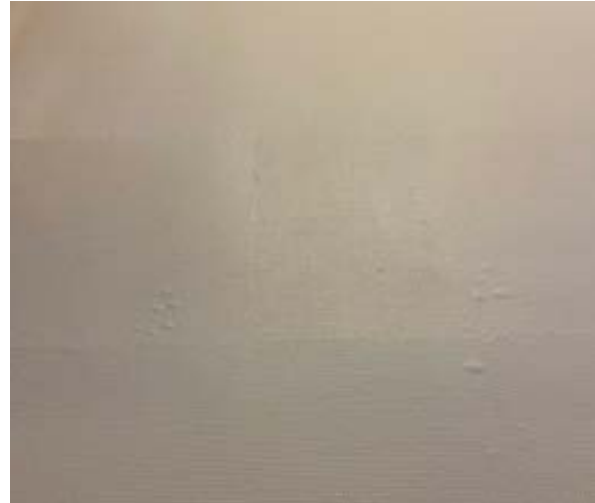
Vaate-eteisen (11) tapetti kupruilee Kuva: Violet Raitala 2024
