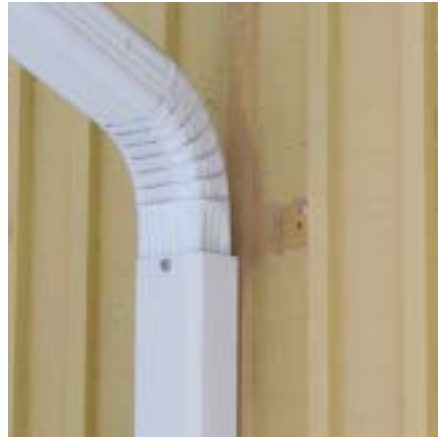
Vaurio 7. Vanhojen syksytorvien kiinnitysäljet näkyvissä. Roope Mustonen 2024.
