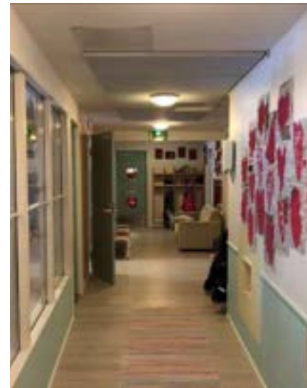
Käytävän (24) alkuperäistä värytystä Kuva: Kangaskontion päiväkodin kosteus- ja sisäilmämatutkimus 2020
