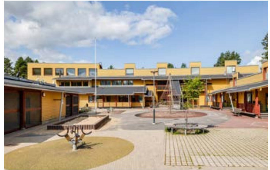
Rakennus suojaa sisäpihaa massallaan. Julkisivu on leikkisän monimuotoinen ja verhoiltu iloisen keltaiseksi. Kuva: Oulun kaupunki
