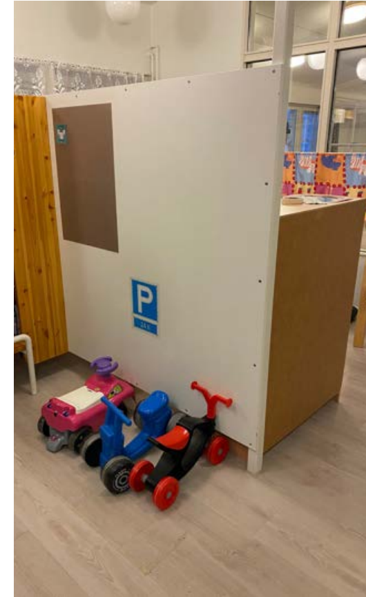
Vaate-eteinen on muutettu jakotilaksi kevyellä väliseinärakenteella. Kuva: Violet Raitala 2024
