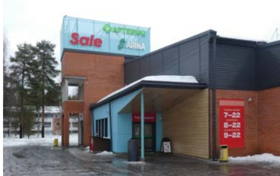
Liikekeskuksen uusia julkisivumateriaaleja. Sekä nykyinen sisäänkäyntikatos että tornin vaaleansininen metallikehikko on lisätty samassa yhteydessä. Puuta jäljittelevää julkisivulevyä on käytetty myös Maikkulanraitin puoleisessa julkisivussa. Kuva: Lauri Antila 2024
