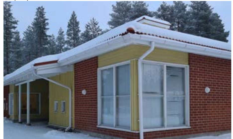
Eri muotoisia ruutuikkunoita ja vaihtelevaa laudoitusta. Rakennuksen länsipäädyssä. Kuva: Petteri Hiltunen 2024
