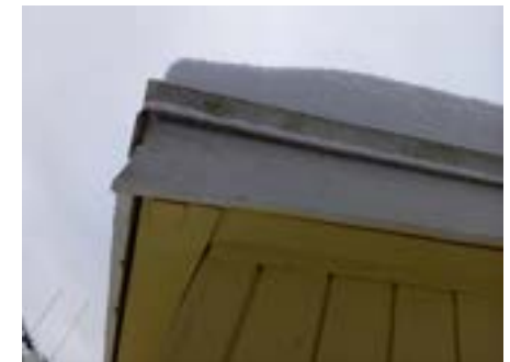
Varastojen katot olivat tarkasteluheikellä lumen peitossa. Katteen päällä vaikuttaisi olevan jonkin verran sammalta. Kuva: Kirsikka Lehtiniemi 2024
