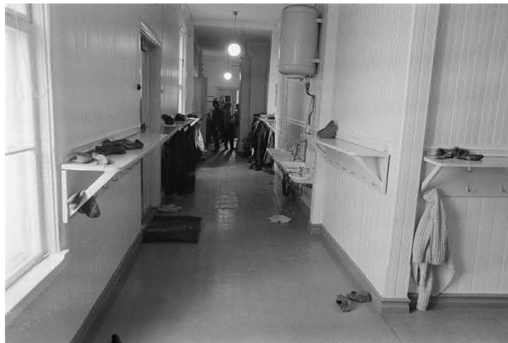
Päärakennuksen sisätiloja kuvattuna 1970-1980-lukujen vaihteessa. Ylemmässä kuvassa juhla- ja liikuntasalista peruskorjauksen purkutyöt ovat jo käynnissä. Sali muutettiin ruokalaksi ja osa siitä purettiin uuden ulkoseinäjän siirryttyä sisäänpäin. Kuvat: Raimo Ahonen.
