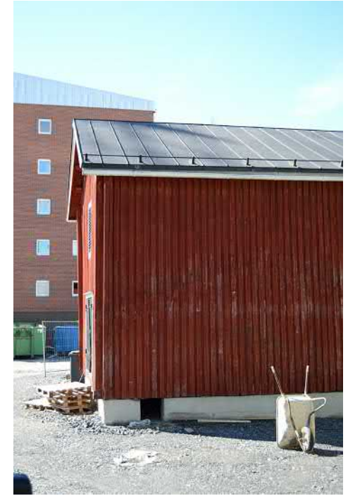
Makasiinirakennus uudella paikallaan korttelin länsikulmassa elokuussa 2022.
