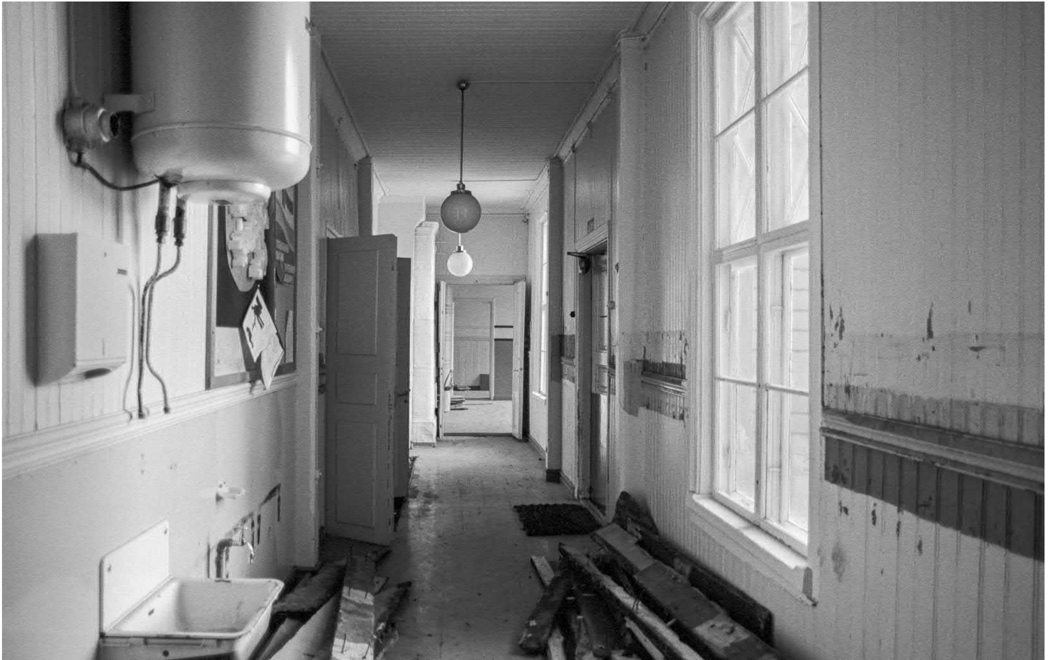
Päärakennuksen käytävä kuvattuna 1970-1980-lukujen vaihteessa. Peruskorjauksen purkutyöt ovat jo käynnissä ja purettujen naulakkojen takaa on paljastunut aiempia maalikerroksia. Koulun sisätilojen väritys on vaihdellut. Kuva: Raimo Ahonen.
