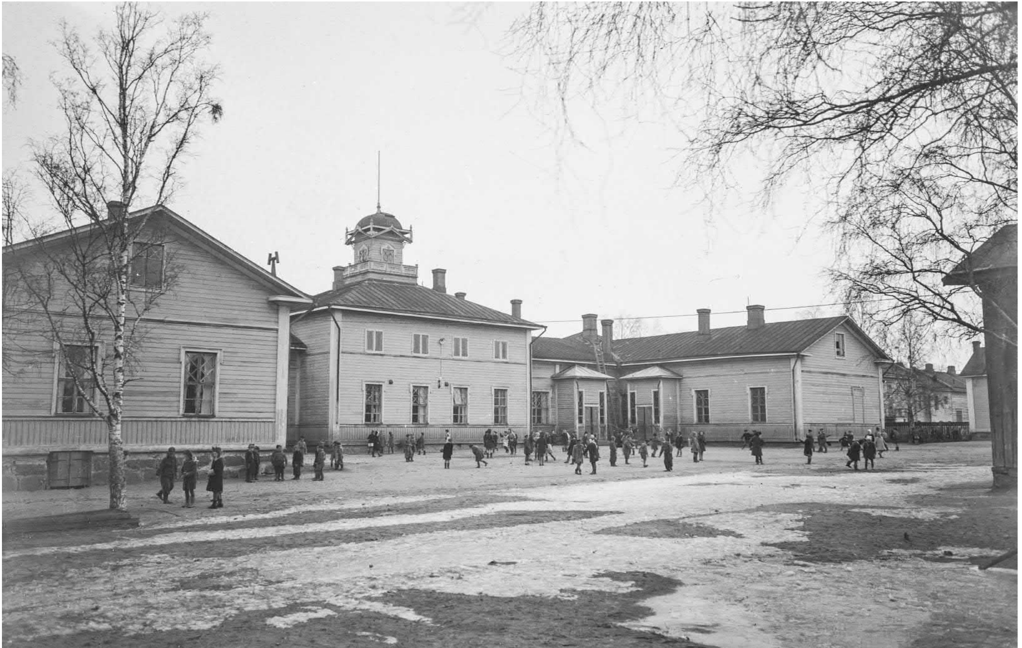
Heinätorin koulun päärakennus ja koulun piha-alue vuonna 1949. Kuvassa näkyvät hyvin arkkitehti Westlingin suunnitelmasta poikkeavasti rakennetut sisäänkäyntikuistit. Siipirakennuksen päädystä näkyy valeikkuna. Lähde: Journalistinen kuva-arkisto, JOKA.
