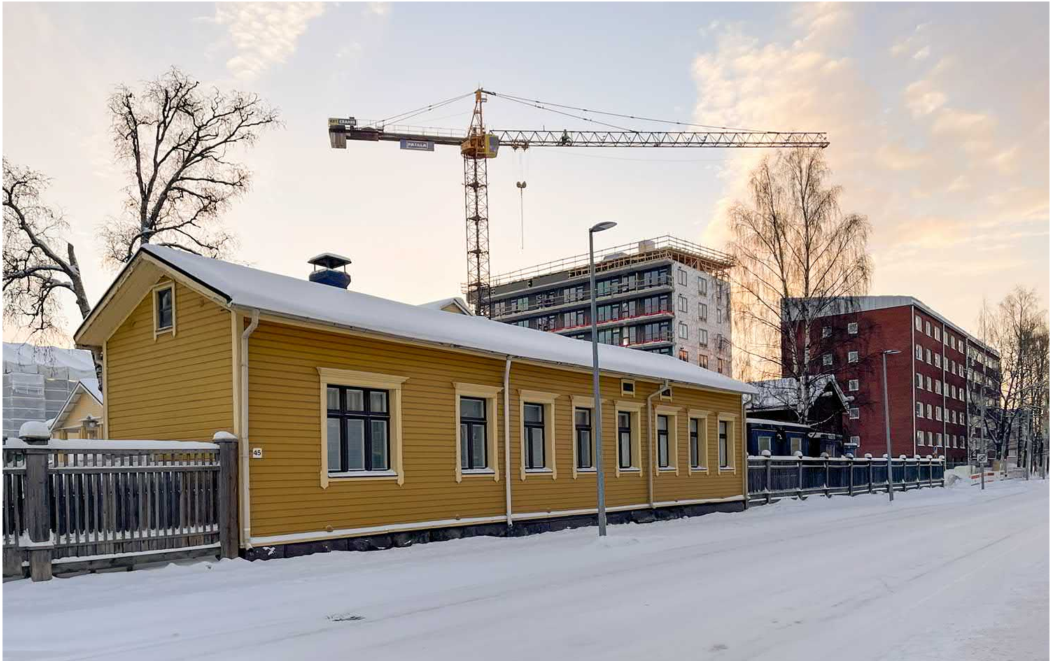
Heinätorin koulun naapurikortteliin ollaan rakentamassa Heinäpään täydennysrakentamisen toteutusselvityksen periaatteiden mukaisesti uutta asuinkerrostaloa. Taloyhtiö oli mukana selvityksessä pilottihankkeena. Kuvassa joulukuulta 2022 uudisrakennus näkyy taustalla kuvan keskellä. Kuva: Maisa Seppänen.
