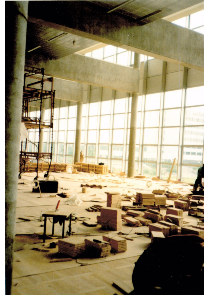
Kuva 11 Linausosaston parketin asennustyöt menossa
