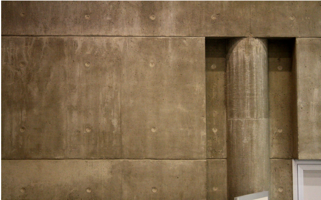
Kuva 22 Sileävalettua seinää
