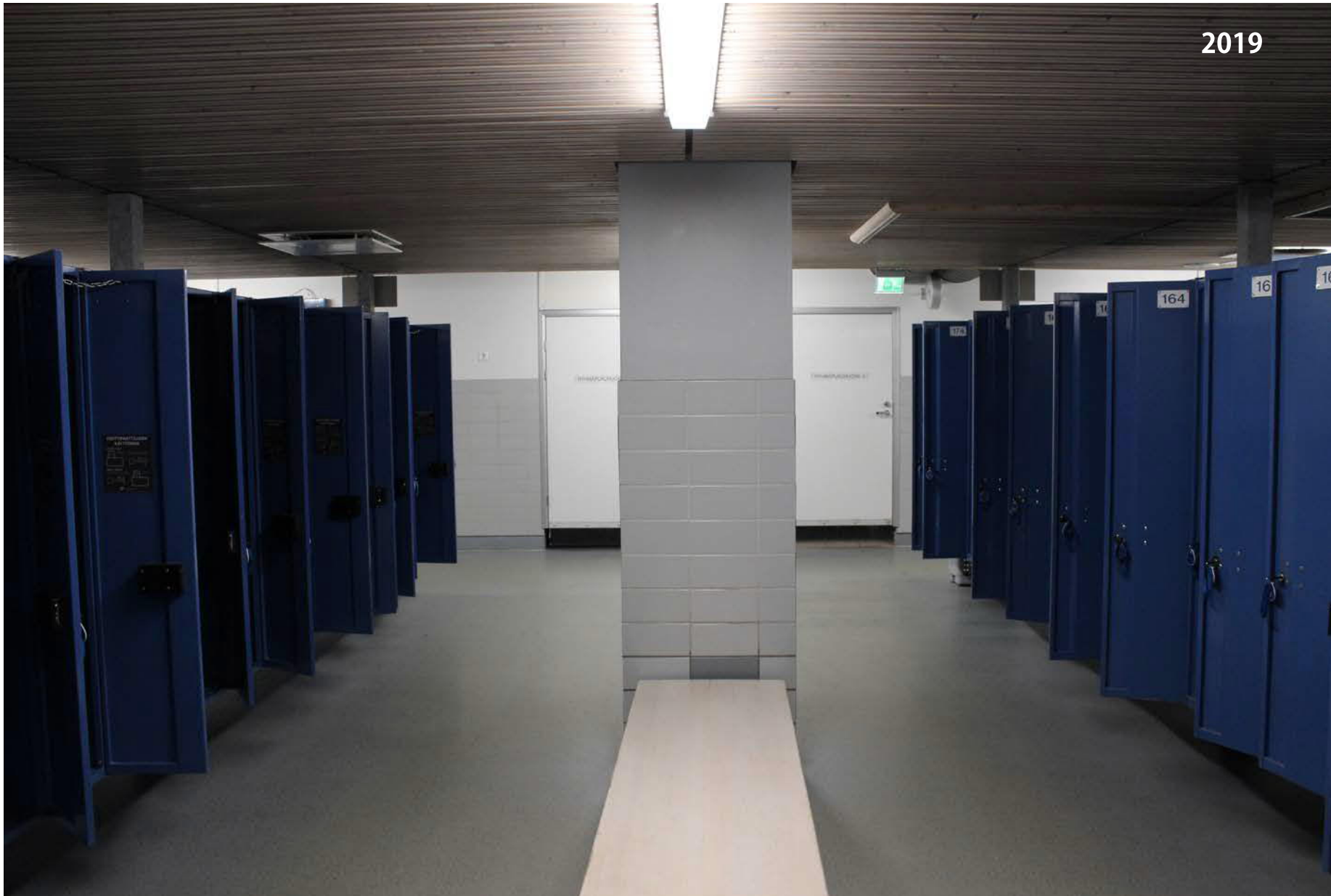
62. Tiili- ja betonipinnat on maalattu tai laatoitettu. Alakaton metalliprofiili on vaihdettu puurimaan. Lattialaatta ja sitä myöhemmin seurannut muovimatto on vaihdettu akryyllattiaan. Pukukaappien sininen sävy on säilytetty.
