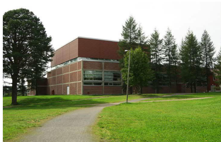
53. Takajulkisivu koillisesta katsottuna. Hyppytornin kohdalle tehty korkea osa on vuoden 2001 peruskorjauksessa rakennettu uudelleen ja saanut ohutlevypinnan tilalle. KUVA: Pohjois-Pohjanmaan liitto, Riitta Kosonen.
