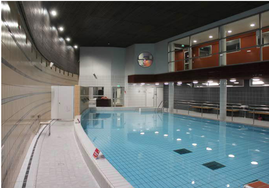
82. Vuonna 2001 rakennettu terapia-allas on muodoltaan kaareva. Oikealla ylhäällä on aulan ylätasanne.
