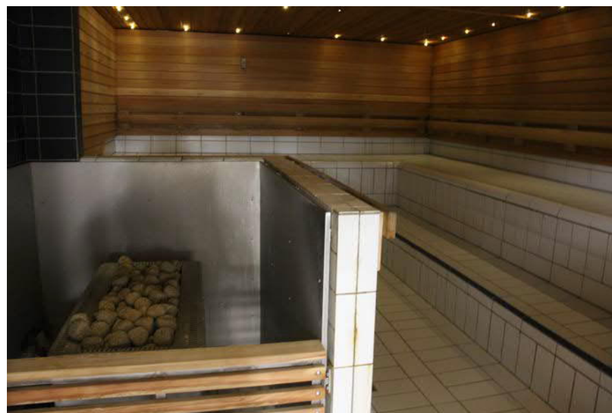
89. Laatoitetut lauteet jäädytetään allasvettä kierrättämällä.
