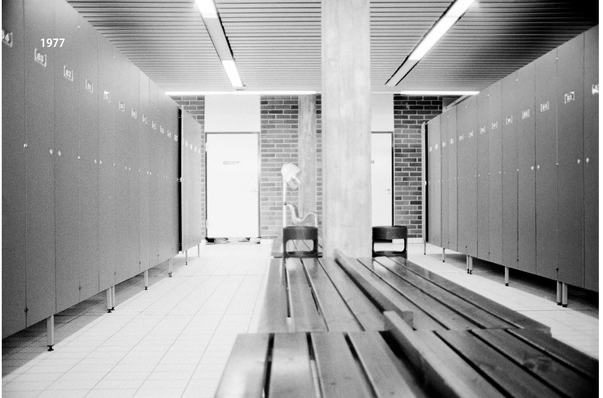
61. Miesten pukuhuone vuonna 1977. Lattiassa on sama valkoinen nappulalatta kuin allashuoneessa. Alakatot on päällystetty rei'itetyllä alumiiniprofililla. Peräseinä on punatiiltä ja pilari betonipintainen. KUVA: Raimo Ahonen
