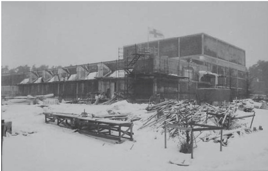
39. Laajennusosan harjannostajaisia vietettiin 15. tammikuuta 1988 KUVA: Eljas Sallmén / Kaleva / JOKA / Museovirasto
