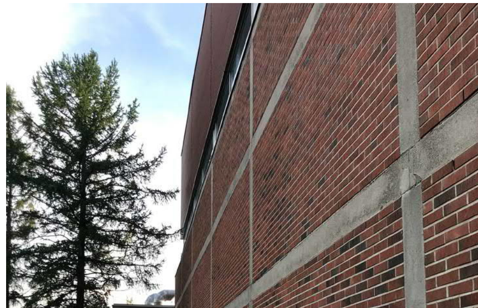
54. Julkisivujärjestelmä muodostuu teräsbetonielementeistä, joiden välit on täytetty puhtaaksi muuratulla punatiilillä.
