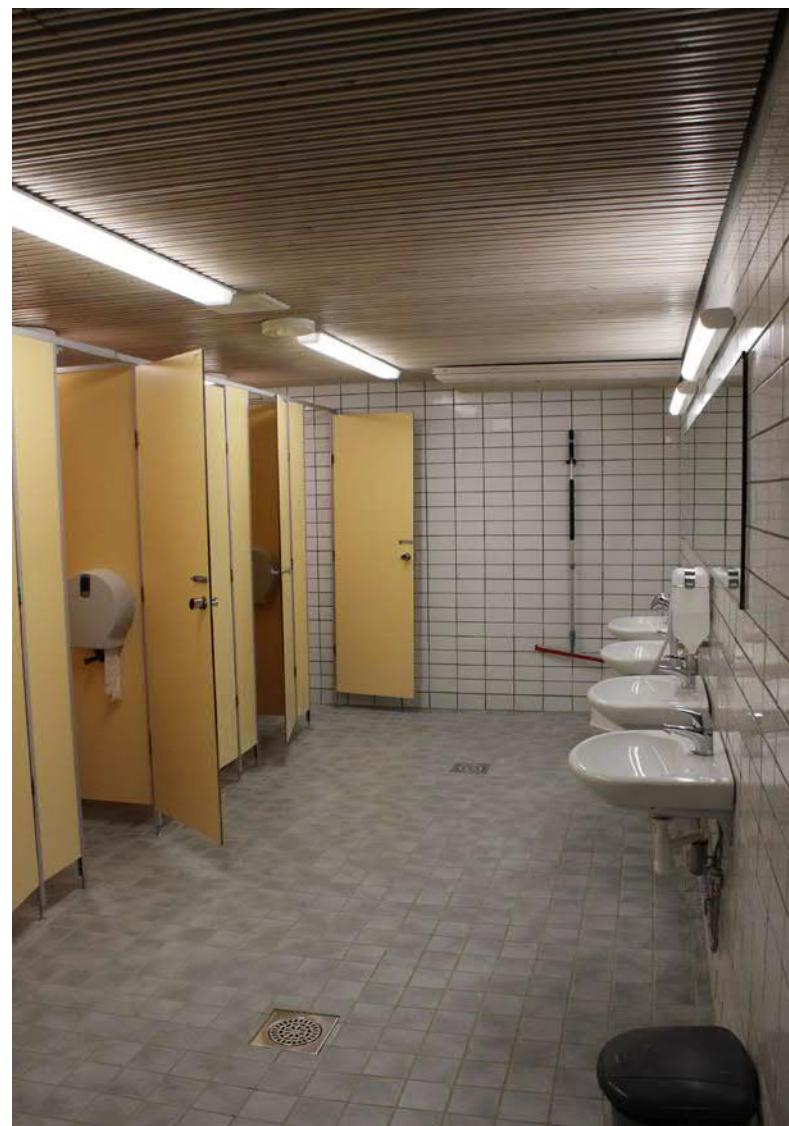
86. Naisten pukuhuoneen saniteettitila.
