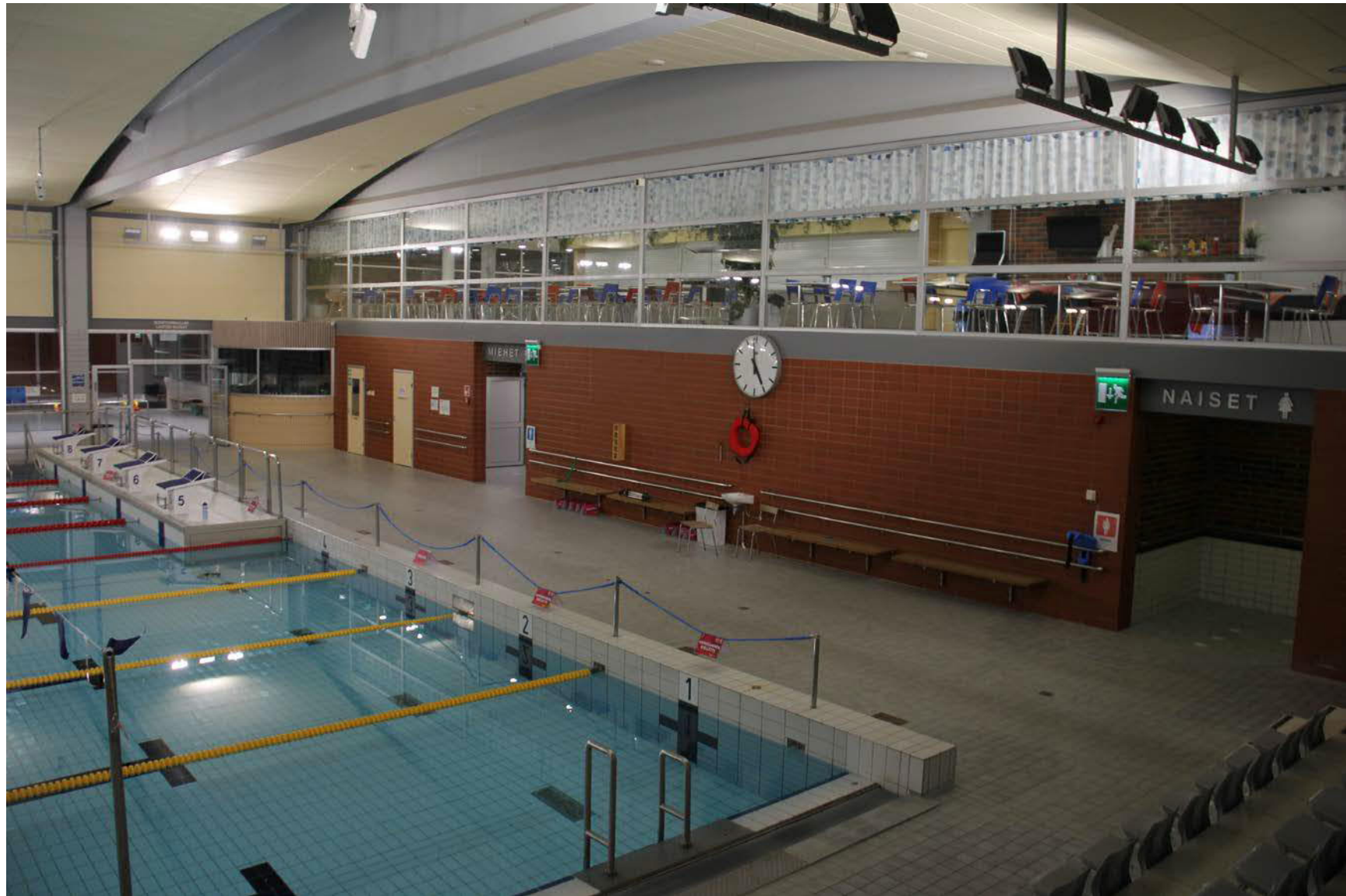
72. Pääaltaan nykyinen värимаailma ja muotokieli ovat muuttuneet. Tiili- ja betonipintoja on maalattu tai laatoitettu. Suurin muutos on alakaton avaaminen ja palkkien välien tekeminen kaareviksi. Päätyseinän reikätiili ja pilarit on laatoitettu peittoon. Päätyseinälle on tehty kiinteät istuimet. Teräskaitteita on poistettu. Valaistus on siirretty altaan yläpuolelta reunoille ja valo tulee nykyisin epäsuorasti sisäkaton kautta.
