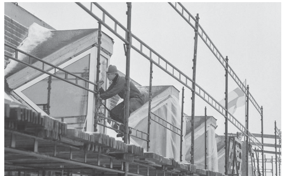
40. Laajennusosan ikkunalyhtyjä asennetaan harjannostajaispäivänä. KUVA: Eljas Sallmén / Kaleva / JOKA / Museovirasto
