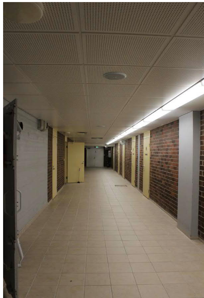
94. Kellarin käytävät ovat leveitä. Lattialaatoitus on uusittu. Alakatot ja ovet ovat alkuperäisiä.
