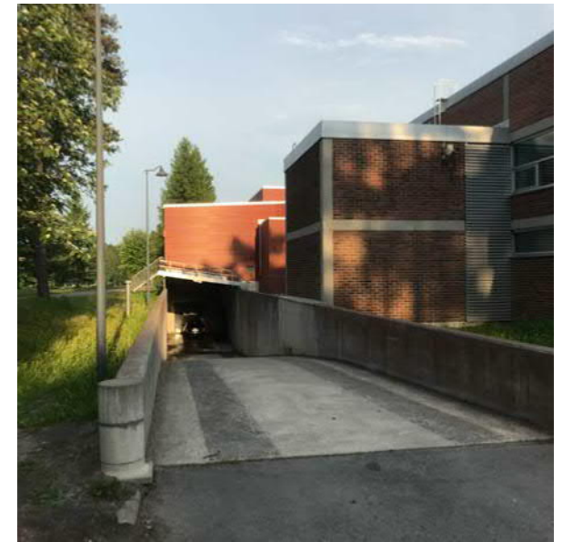
49. Huoltoliikenteen ajoluiska on tehty vuonna 2001.
