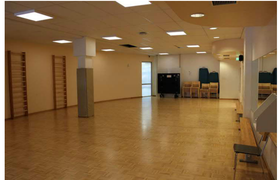
92. Toisen kerroksen liikuntasalia on laajennettu tekemällä uusi kaareva seinä.
