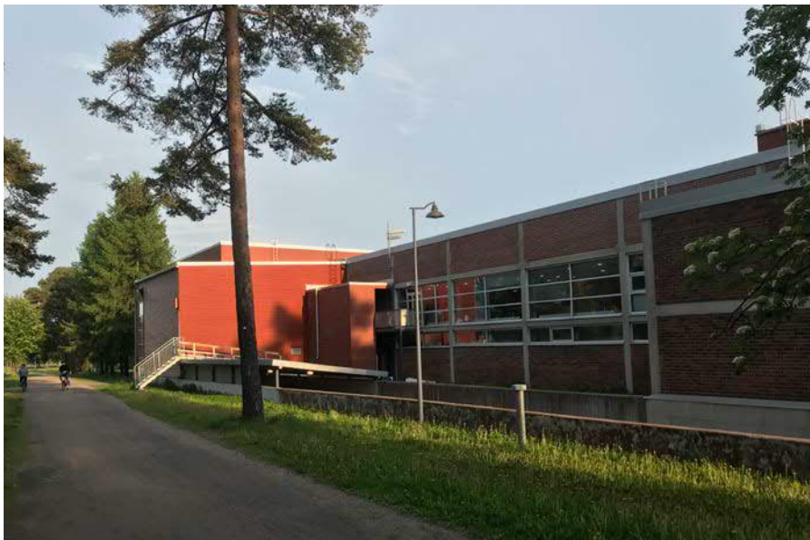
47. Uimahallin taakse rakennettiin laajennusosa 2014. Sen julkisivut vuorattiin punaisella teräsohutlevyllä.
