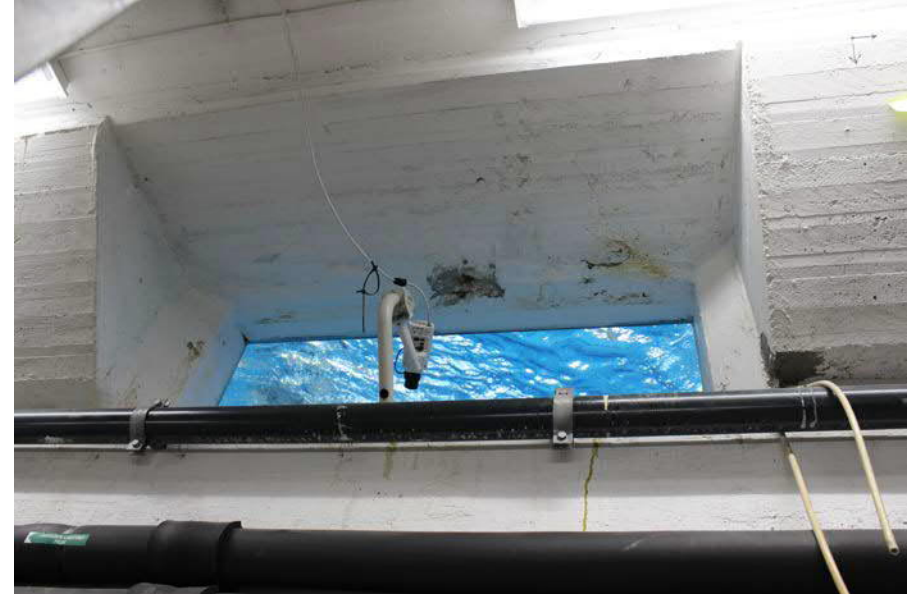
98. Altaan alapuolisesta tilasta on ikkuna päältäan syvään päähän. Ikkunassa on kameravalvonta.
