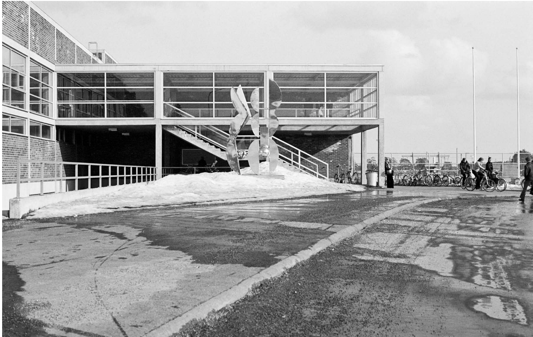
31. VASEMMALLA: Uimahalli lounaasta kuvattuna vuonna 1977. Laatikkomaista massoittelevaa rytmittävää betonielementtien kehystämää moduulit, joissa vuorotteleva punatiili sekä alumiinijärjestelmään sovitettuja lasipinnat. KUVA: Raimo Ahonen
