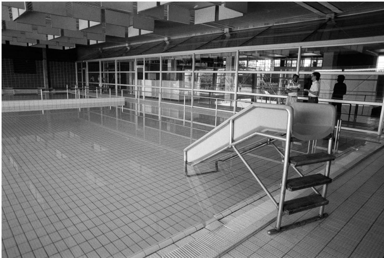
67. Oulun uimahallin laajennus ja peruskorjaus on loppusuoralla 29.6.1988. Etualalla on opetusallas, jonka liukumäki on nykymittapuun mukaan vaatimaton. Taustalla näkyy allashuoneiden väliin rakennettu pulpettikattoinen lasinen väliseinä. Sen takana näkyy alkuperäinen valvomo. Alakatossa on uimahallin henkilökunnan itse tekemät akustiikkakotelot. KUVA: Mauno Pälli / Kaleva / JOKA / Museovirasto
