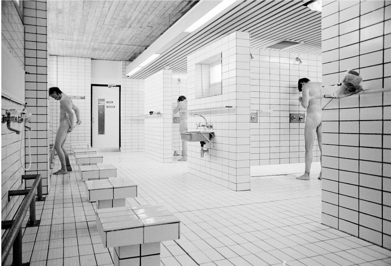
73. Miesten pesutilat vuonna 1977. Modulaarista järjestelmää on noudatettu laatoituksessa ja laatoitetuissa kiintokalusteissa. Laatoituksen graafisuutta korostaa tumma sauma. Alakatto on valupintaista betonia ja pesutilojen yllä alumiiniprofilia. KUVA: Raimo Ahonen
