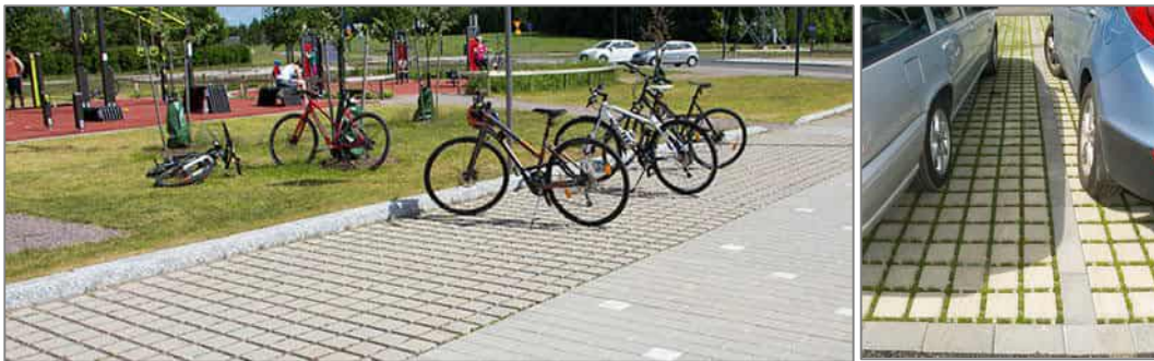
Kuva 10. Vettä läpäiseviä kiveyksiä pysäköintialueilla. (rakentaja.fi)
