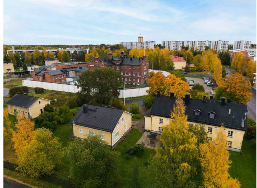
Viistokuva Nahkatehtaankadun ja Salmelantien risteyksestä päin Oulun vankilan rakennuksista syksyllä 2022. KUVA: Senaatti-kiinteistöt
