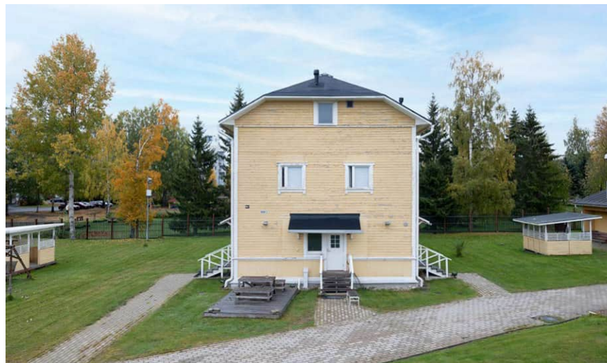
Päätyjulkisivu länteen. KUVA SK.
