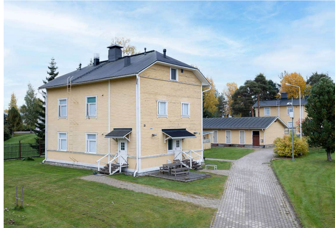
Rakennus 007 pohjoisesta nähtynä, taustalla rakennus 010 ja rakennus 006. KUVA SK.
