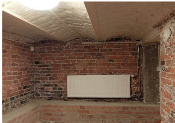
Rakennuksen osittainen kellari. KUVA: arkkitehdit MV oy 2022.
