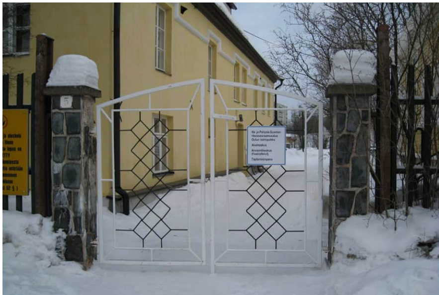
Metallirakenteinen ajoportti rakennuksen 003 vierustalla helmikuussa 2011. Luonnonkivipäällysteiset portin pielet on tehty 1950-luvun jälkeen. KUVA arkkitehdit MV oy.
