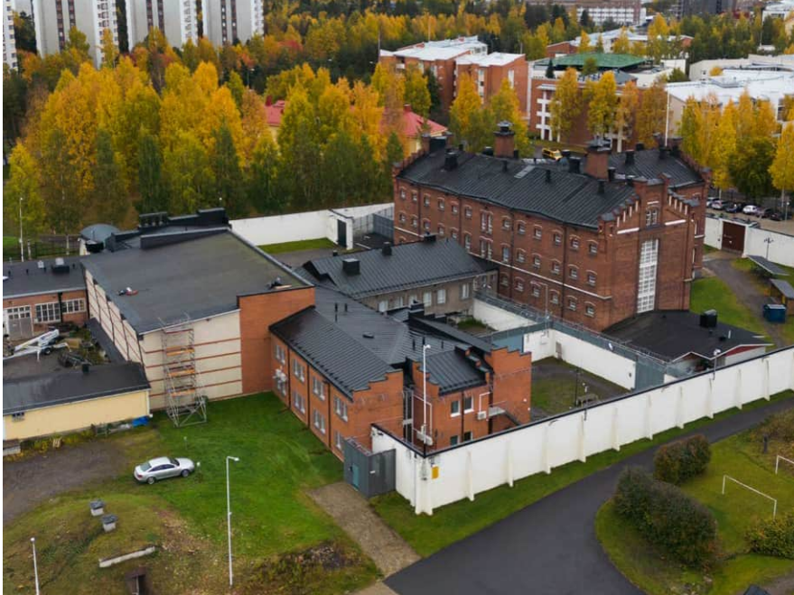
Viistokuva vankilarakennuksesta, kaikki rakennusvaiheet ovat näkyvissä. KUVASK.
