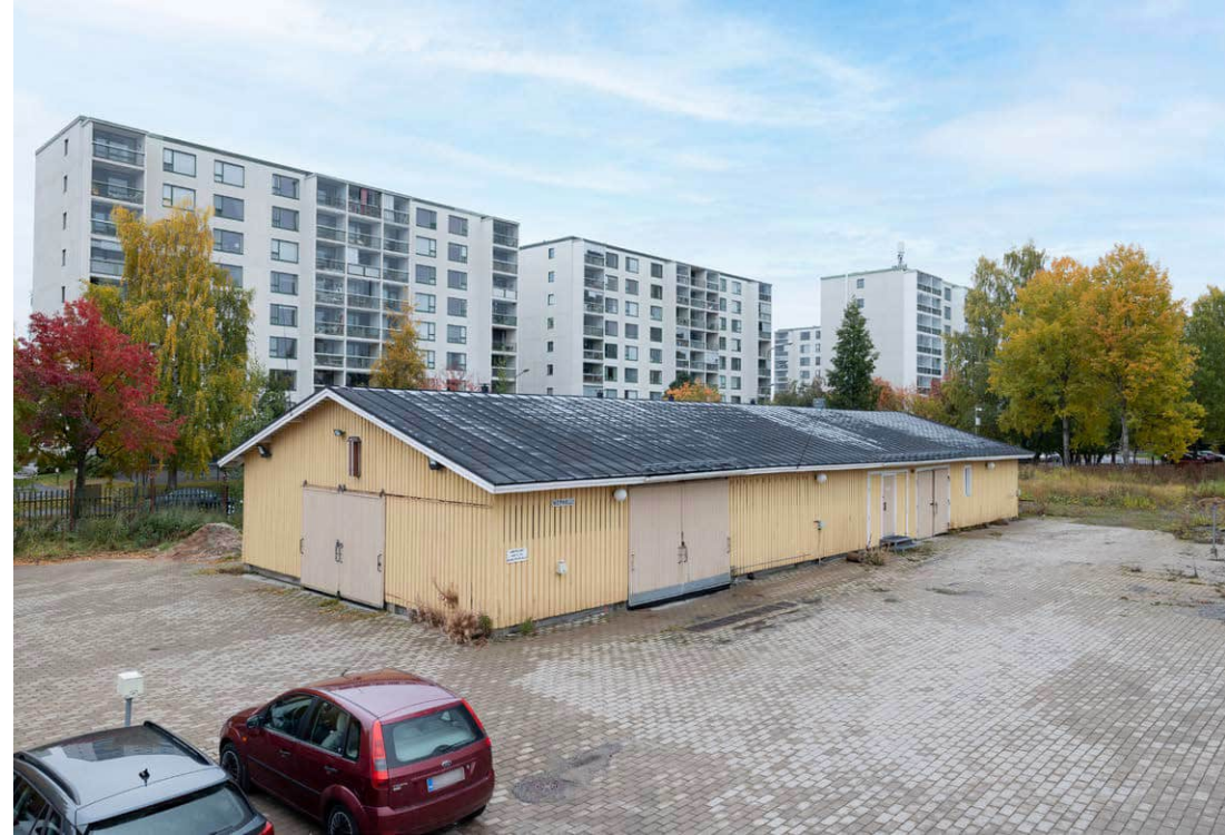
Julkisivut länteen ja etelään, taustalla Salmelantien kerrostaloja. KUVA SK.
