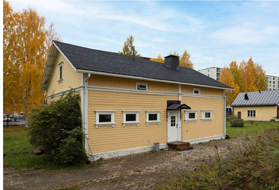
Julkisivu etelään, rakennus 017. KUVA SK.
