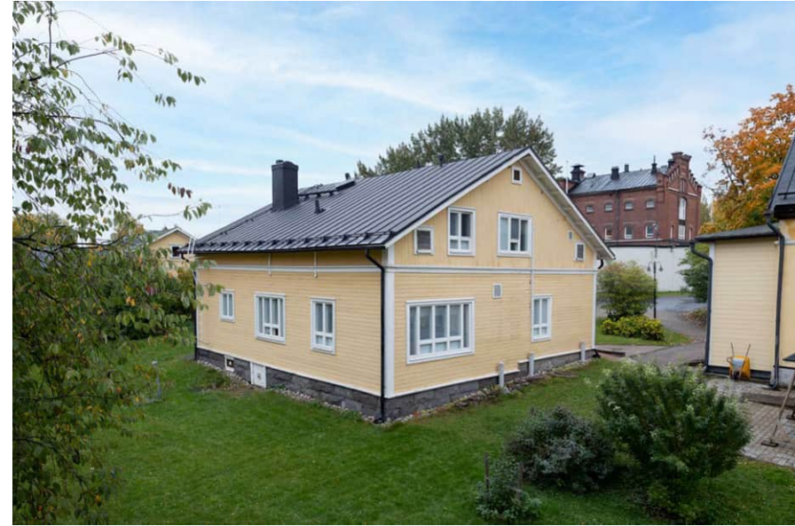
Julkisivut pohjoiseen ja länteen. KUVA SK.
