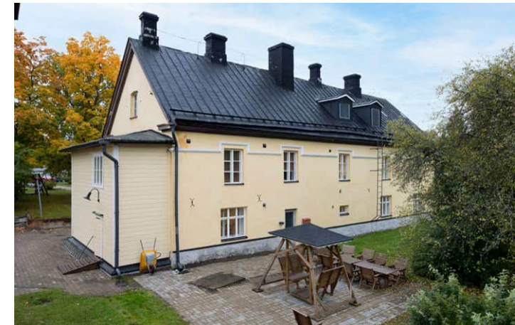
Julkisivu pohjoiseen. KUVA SK.
