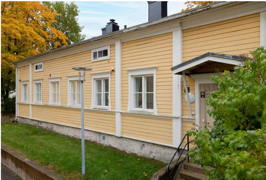
Julkisivua pohjoiseen. KUVA SK.
