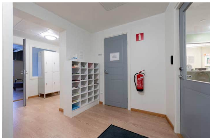
Käytävä 1 krs. KUVA SK.
