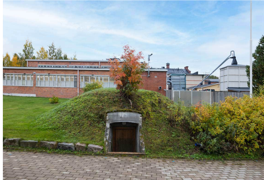
Kellarin sisäänkäynti, taustalla työhuonerakennus 008 ja purusiilo 018. KUVA SK.
