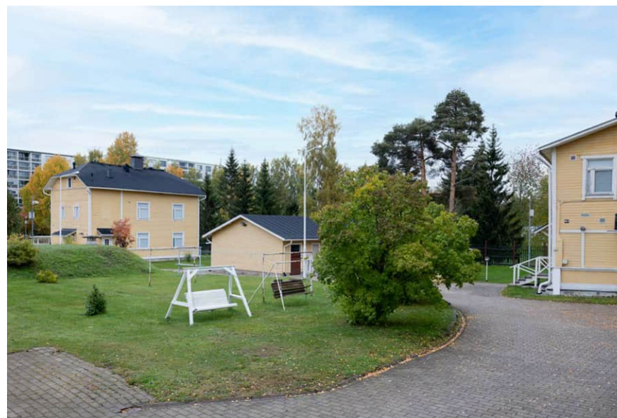
Näkymä rakennuksen 006 ja 007 pihalle, keskellä talousrakennus 010. KUVA SK.
