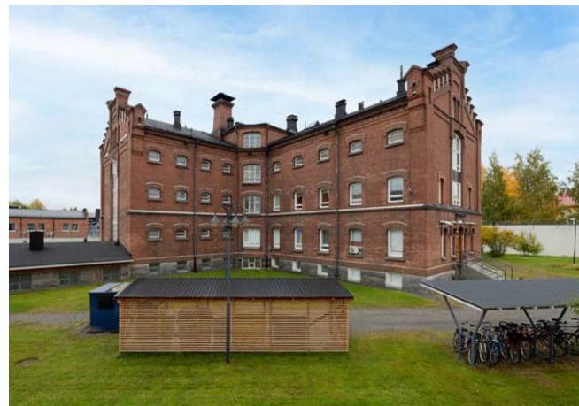
Länsisiipi ja pohjoissiipi, etualalla kevytrakenteisia katoksia. KUVA SK.
