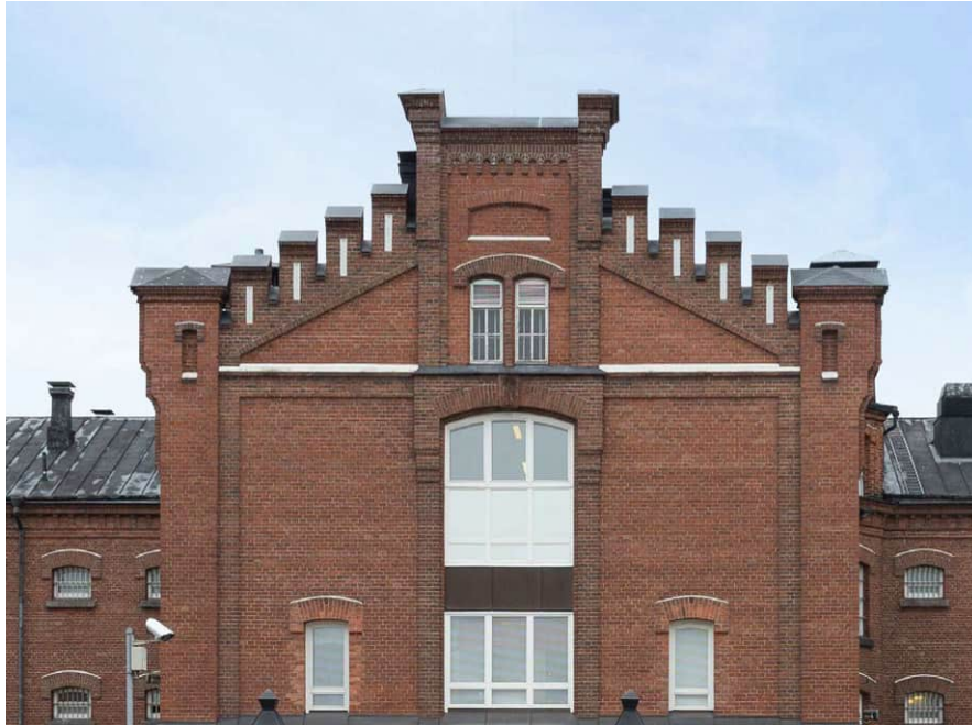
Länsipääty, julkisivun yksityiskohtia. Yksityiskohtiin liittyvät vaaleat rappaukset ovat peruskorjausten ajalta. KUVA SK.
