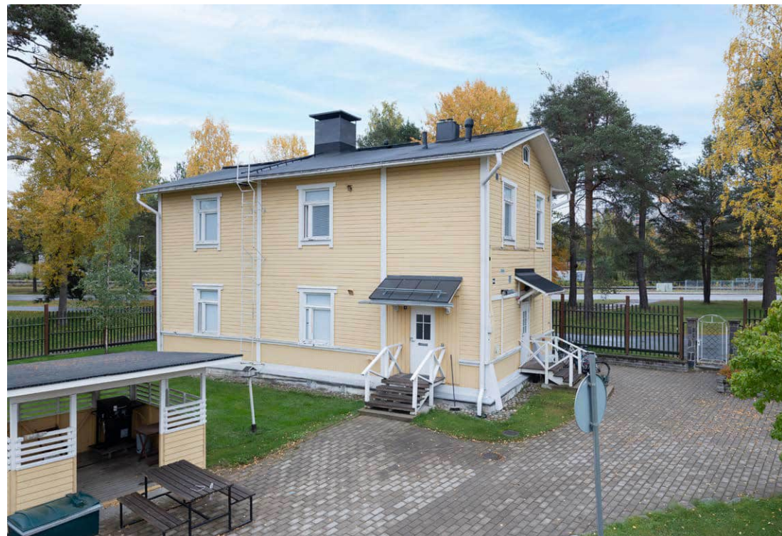
.Julkisivu pohjoiseen, taustalla vankila-alueen aita. KUVA SK.
