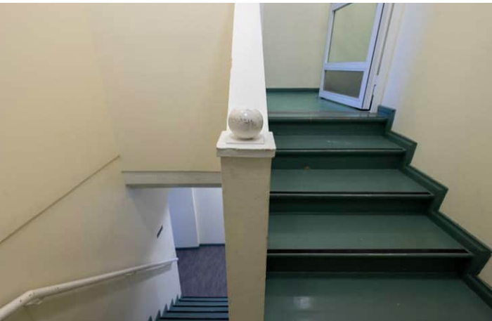
Portaan yksityiskohtia. KUVA SK.
