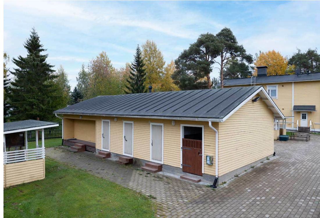
Julkisivu pohjoiseen, taustalla rakennus 006. KUVA SK.
