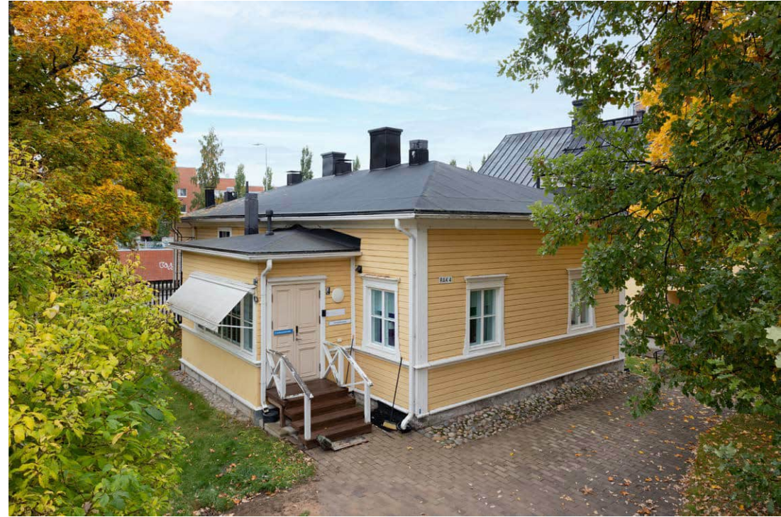
Julkisivu itään ja kuisti. KUVA SK.
