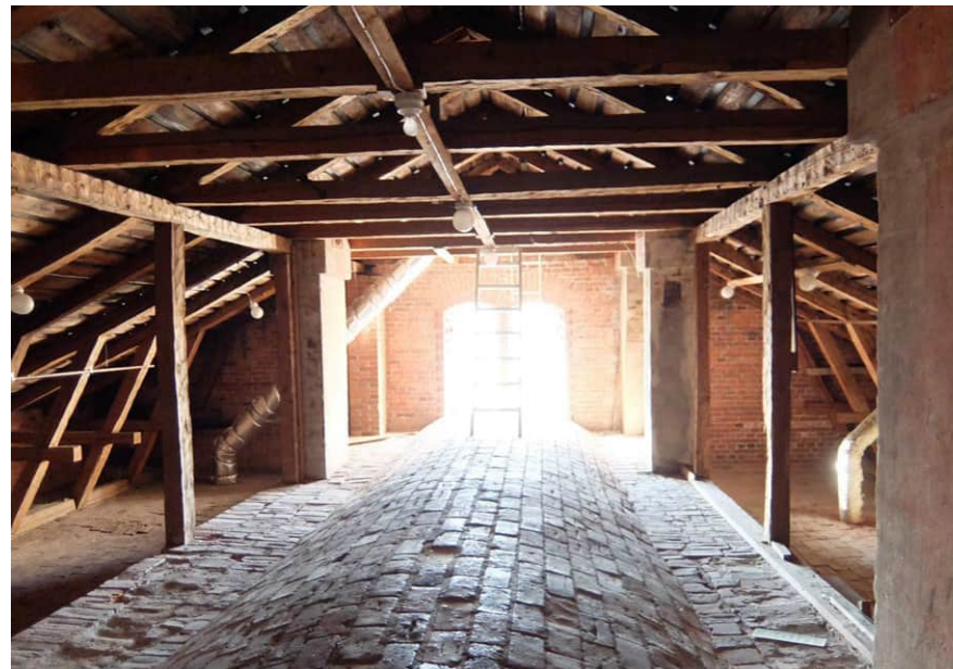
Pohjoissiiven ullakko, tiiliholvattu yläpohja ja kattorakenteita. KUVA arkkitehdit MV oy.
