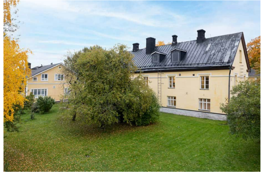
Julkisivu pohjoiseen, taustalla rakennus 003. KUVA SK.
