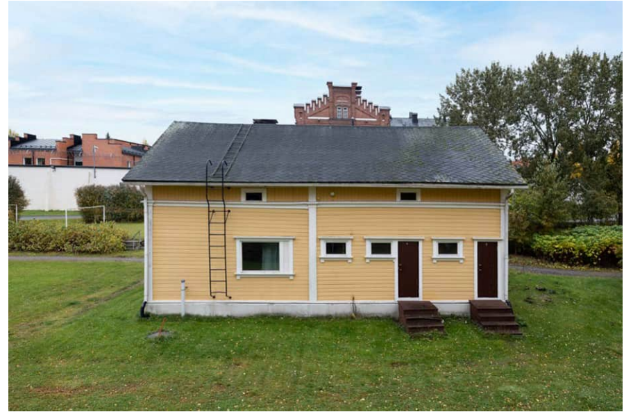
Julkisivu pohjoiseen. KUVA SK.
