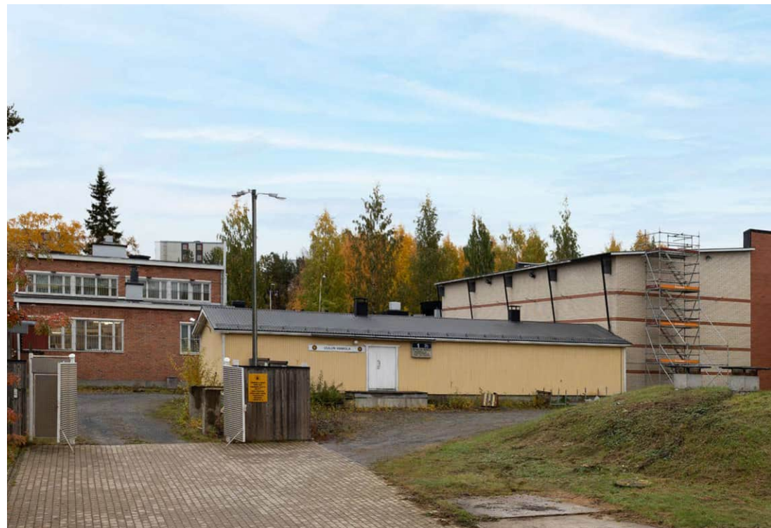
Julkisivu pohjoiseen, taustalla vankilarakennuksen lisärakennus ja työhuonerakennus 2011. KUVA arkkitehdit MV oy.
