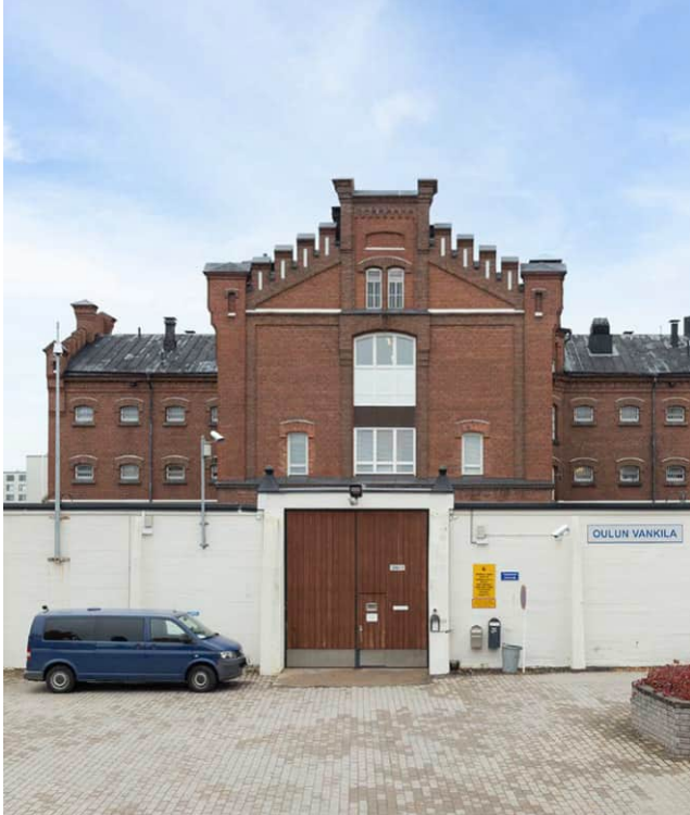
Kehämuurin pääportti, taustalla vankilarakennus. KUVA SK.
