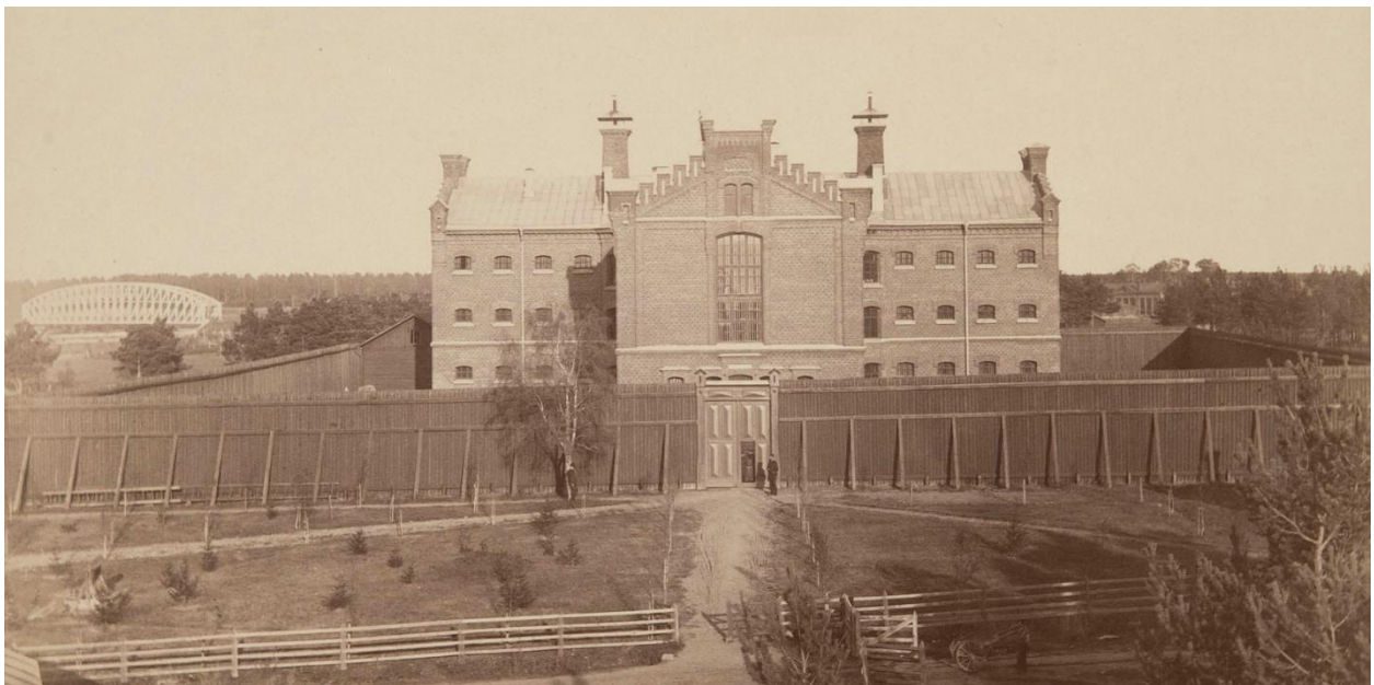
Kuva 11 Oulun lääninvankila ja sen hirsirakenteinen piiriaita vuonna 1890. Kuva: rakennushistoriaselvitys.
