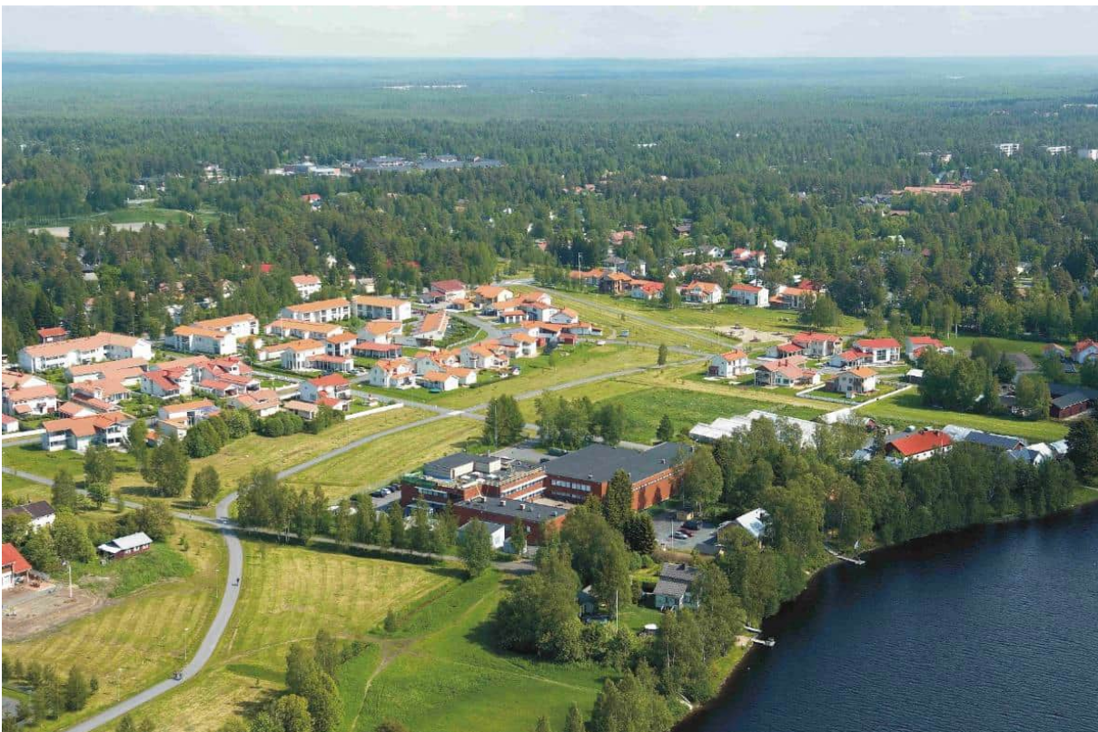
Kuva 2 Näkymäkuva nykytilanteessa (Oulun Vesi)
