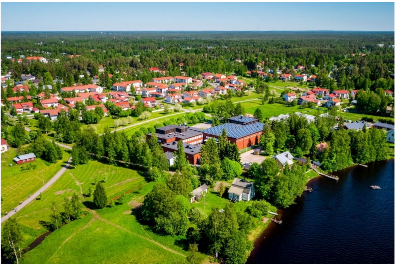
Kuva 1. Viistoilmakuva Hintan vesilaitoksesta ympäristöineen.
