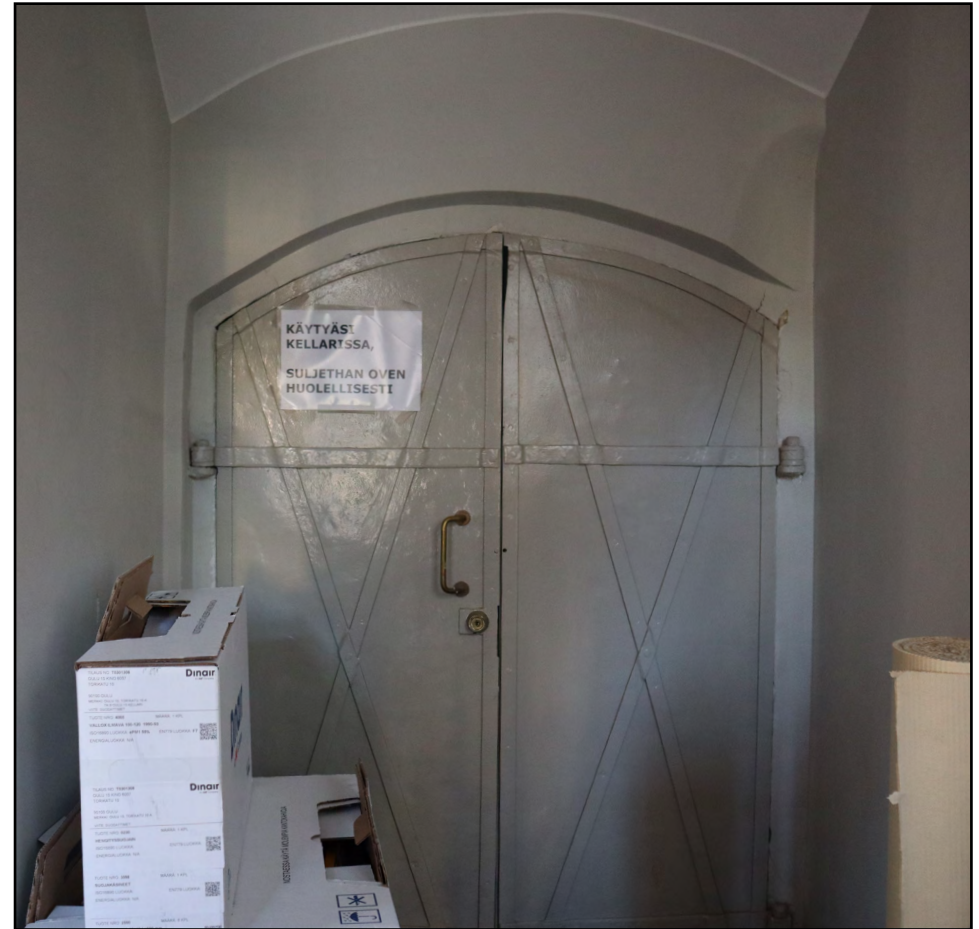
Jykevärakenteisessa, latoin jäykistetyssä, kaarevassa kellarin ovesa on taotut saranat.
