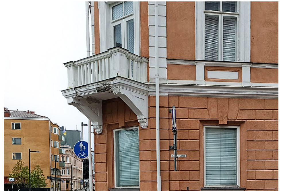
Nurkkaparvekkeen kipsikonsoleissa ja profiloitun laatan reunassa on näkyviä vaurioita ja patinaa. Kaupunkikuvassa 1800-luvun lopun nurkkaparveke on uniikki ja se rinnastuu esimerkiksi taustalla näkyviin 1950-luvun ulokeparvekkeisiin.
