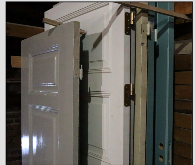
Myös ullakolta löytyy vanhoja peiliovia. Harmaassa peiliovesa on vanhempaa mallia oleva kartiopäinen sarana.
