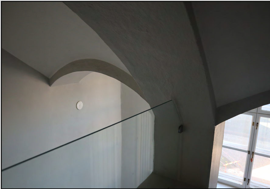
Ullakkokerroksen porrashuoneen holvirakenteet ovat alkuperäissuunnitelmien mukaiset. Lasi on lisätty putoamisenestosuojaksi.
