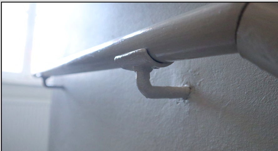
Puiset käsijohteet ja metallikannakkeet.
