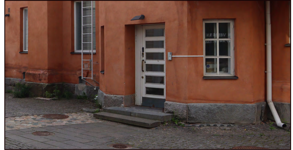
Sisäänkäyntien luonnonkiviportaat ovat säilyneet. Poikkeava lisäaskelma on myöhempi muutos.
