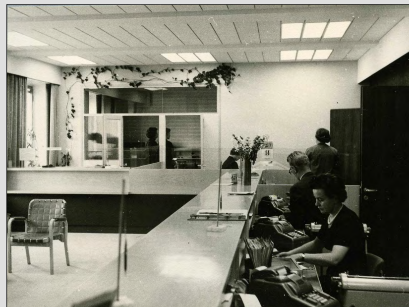
Oulun konttori. Suomen Pankin kuvatietueen mukaan toimisto vuonna 1962. uudistusten myötä tekniikkatila lisääntyy ja alakattopaneloinnit laskeutuvat alaspäin. Palkit ovat vielä näkyvillä. Valaisimet ovat modulaarisia alakattopaneeliin integroitavia 1960-luvun valaisimia. KUVALÄHDE: Suomen Pankki.
