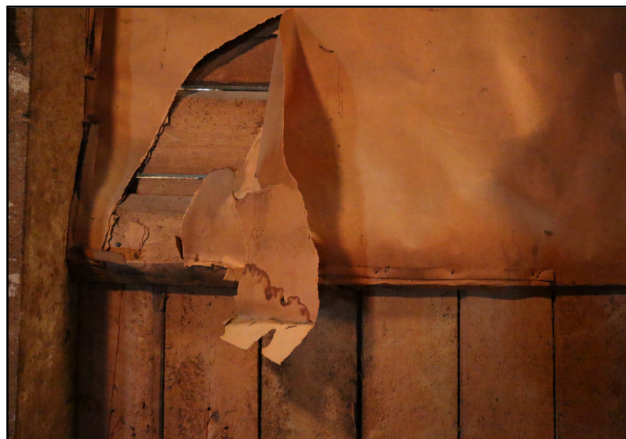
Entisen ullakkohuoneen pinkopahvitettu seinä.
