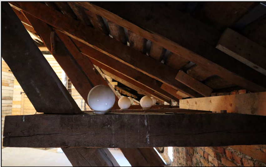
Käsinveistettyjen kattotuolirakenteiden päälle on aseteltu varastoitavaksi valaisinten opaailasikupuja. ruodelaudoitus on särmäämätöntä eli tuppeensahattua.
