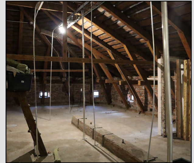
Vanha puupalkki nousee palopermannon päälle. Se on tuettu paikalleen rautaosin. Kromiputkistoa nousee vertikaalisesti palopermannon läpi
