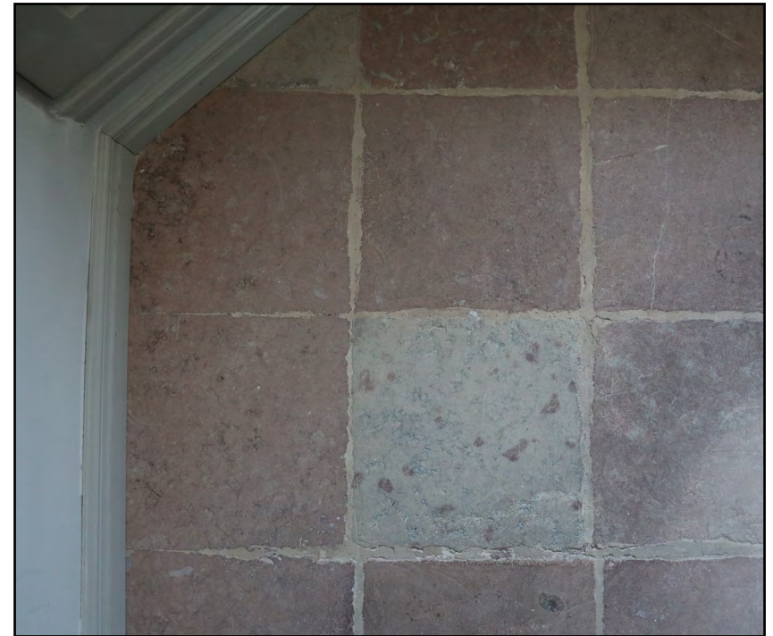
Porrashuoneen välitasanteella on hiekkakivilattiaa, jossa on käytetty erilaisia laattoja.
