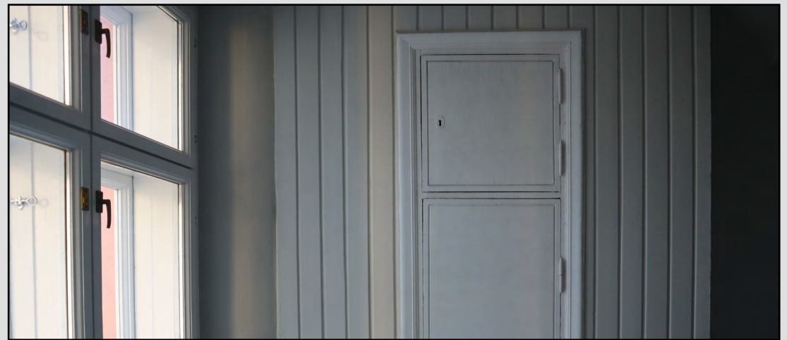
Tasanteella on komero, jonka ovissa on vanhempaa 1900-luvun vaihteelle tyypillistä suippokärkistä saranamallia. Alkuperäisleikkauksessa kohdalle ei ole piirretty komeroa.
