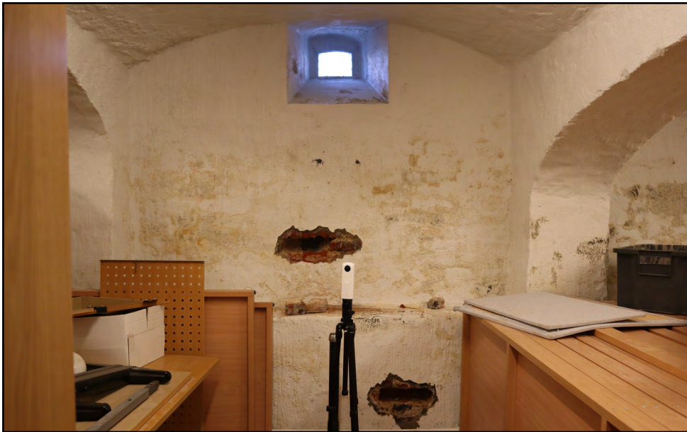
Rakennuksen sisätilat on dokumentoitu 360 kameralla. Taustalla kellarin holveja, jotka ovat voineet säilyä 1700-luvulta saakka.
