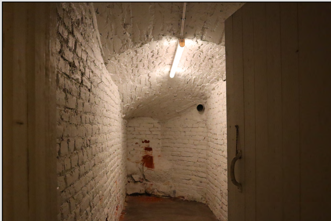
Portaiden alutila on säilynyt alkuperäissuunnitelmien mukaisena. Vasemmalla tiilimuuria yläpuolisten portaiden kielimuurin kohdalla. Portaiden tiiliholvaus kääntyy vaiheittain porrastuksien mukaisesti. Lautaovessa on käytetty toisella puolen kierrätettynä hellan kierrenuppia ja toisella puolella on pystyvedin. Perusmuurissa on rakenneavaus, jossa porauspöly on liejuuntunut. Valaistus on uusittu kauttaaltaan rakennuksessa 2000-luvulla.
