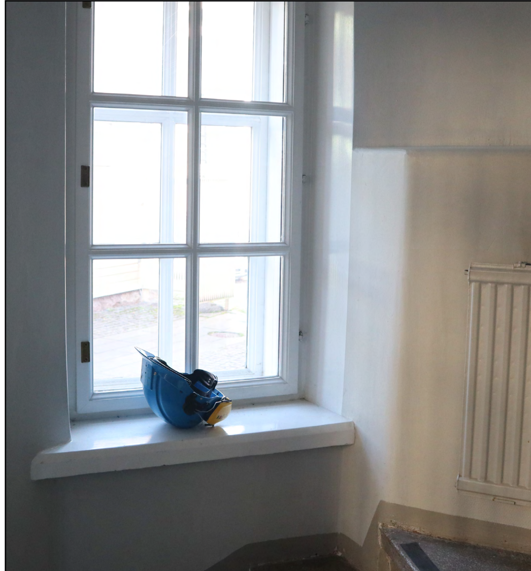
Sisäänkäyntitieteinen porrashuoneessa. Kuusiruutuinen ikkuna ja syvä ikkunapenkki ovat tyypillisiä ajan arkkitehtuurille. Radiaattorit ja sähkövalaisimet sekä -asennukset on kaikki vaihdettu uudempiin 2000-luvun standardimalleihin.
