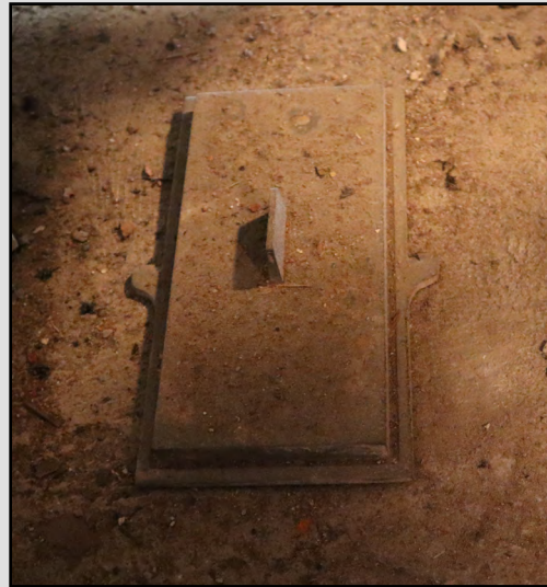
1930-luvun lämmitysjärjestelmämuutoksiin liittyviä uuniluukkuja.
