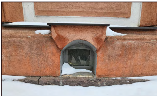
Rubble-muurattu tiilimuuri. Kellarin ikkunoista osissa on ritilät, osissa ummistukset ja osassa ikkunat.
