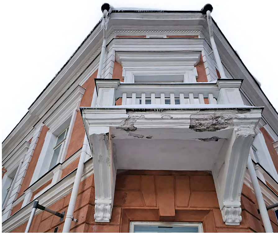
Uusrenessanssityylinen nurkkaparveke. Parvekkeen kaiteet ovat olleet alun perin sorvatut. Kipsikonsoleiden välistä näkyy rakennetta kannattelevat ratakiskot. Kuvassa näkyvät arkkitehtuurille ominaiset kerroslistat, profiloinnit ja räystäslistan alapuolinen gutta- eli pisara-aihe.
