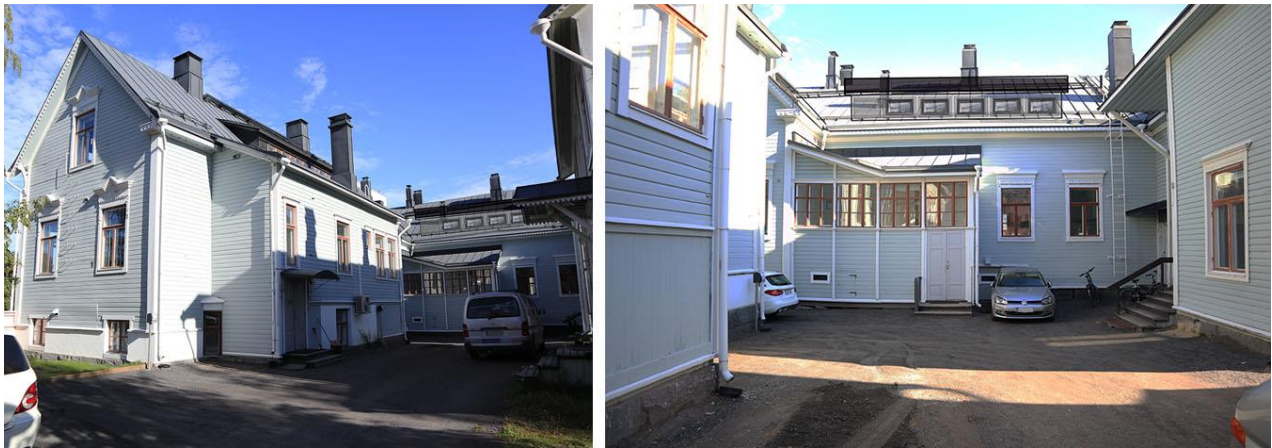
Kuva 11. Luonnos ns. Korsu-rakennuksen pihan puolen ullakkotilan ikkunoista. Kuva: Arkkitehtitoimisto Jorma Teppo Oy.
