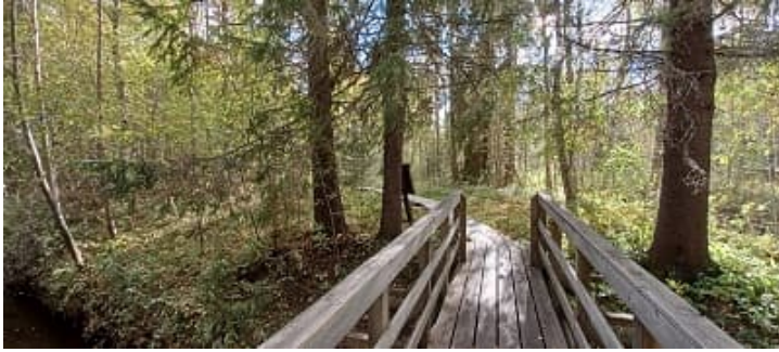
Kuva 9. Kalimenojan ylittävä silta selvitysalueen eteläpäässä.
