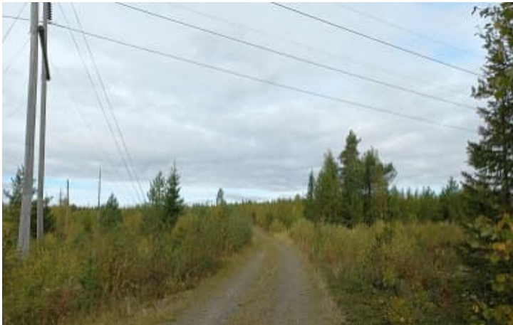
Kuva 13. Voimalinjan ja metsäautotien risteys.
