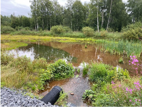
Kuva 27. Kosteikko, laskeutusallas. Osa Välikylän yrityspuistosta Kalimenojaan laskevasta kuivatusjärjestelmästä.
