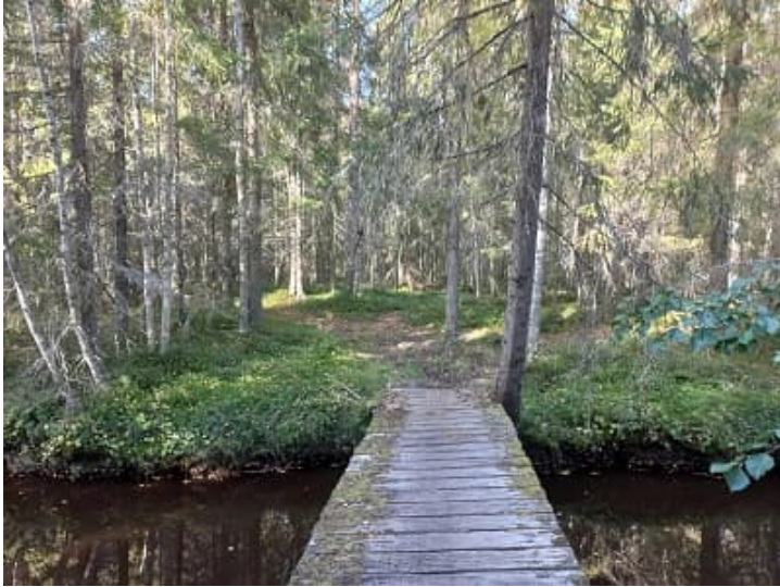
Kuva 24. Kalimenojan ylittävä silta selvitysalueen pohjoispäässä.
