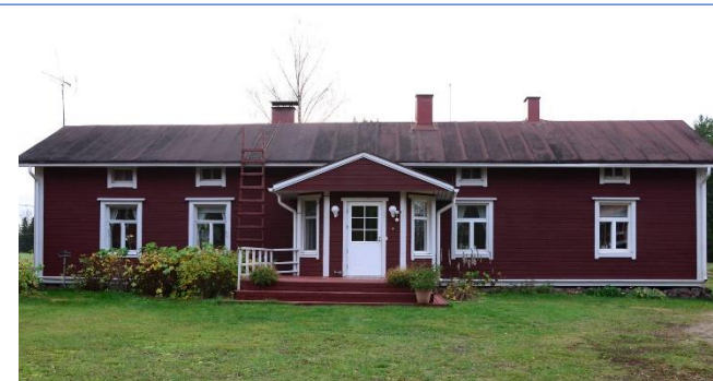
Pihapiirin asuinrakennusta on remontoitu.
