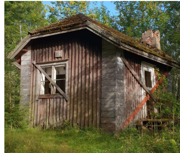
Saunarakennus. Rakennuksessa on samanlainen päädyistä aumattu katto kuin asuinrakennuksissa. (Kuva Oulun kaupunki).
