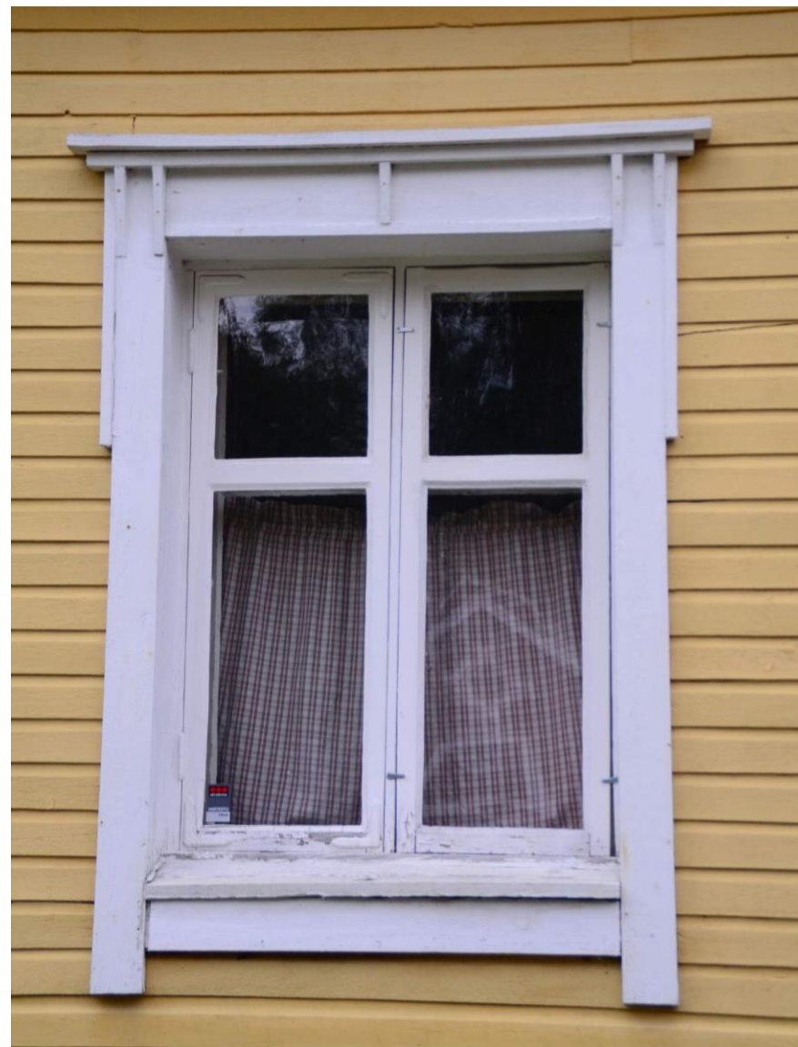
Kukkosen ikkunoiden vuorilautoissa on Ehnbergin ja Maksan kanssa saman kaltaiset mutta muodoltaan pelkistetyimmät koristeaiheet. Vuorilaudat lie jossain vaiheessa uusittu.
