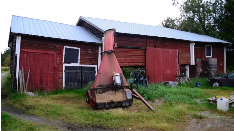
Pihan lounaislaidalla sijaitsevassa talli-latorakennuksessa näkyy ajan mittaan syntynyt kerroksellisuus – rakennusta on laajennettu tarpeen mukaan. Rakennukseen on tehty myös siihen huonommin sopivia muutoksia, kuten isoja oviaukkoja.
