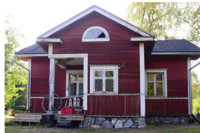
Vanhan asuinrakennuksen koillisjulkisivu.
