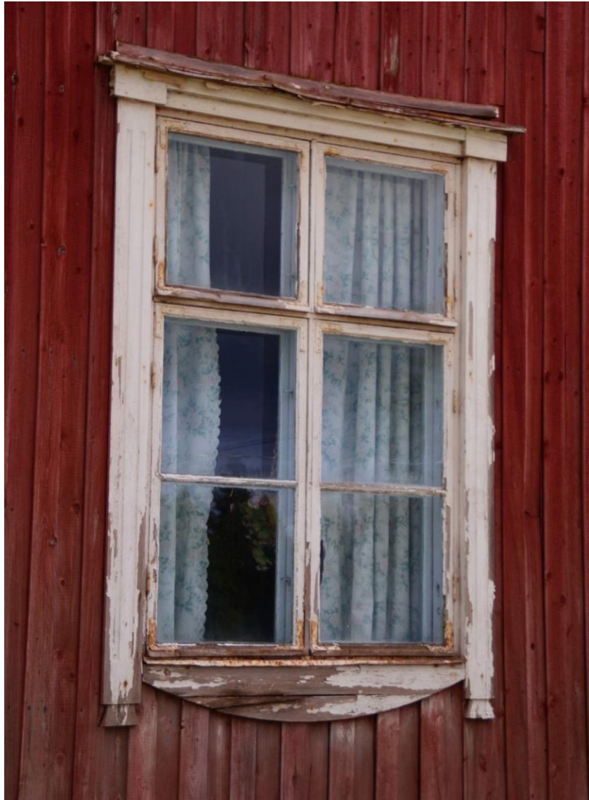
Jaakolan ikkunoita kehystävät samanlaiset vuorilaudat kuin Varjakansaaren rakennuksissa. Ikkunat ovat vanhat, todennäköisesti alkuperäiset.
