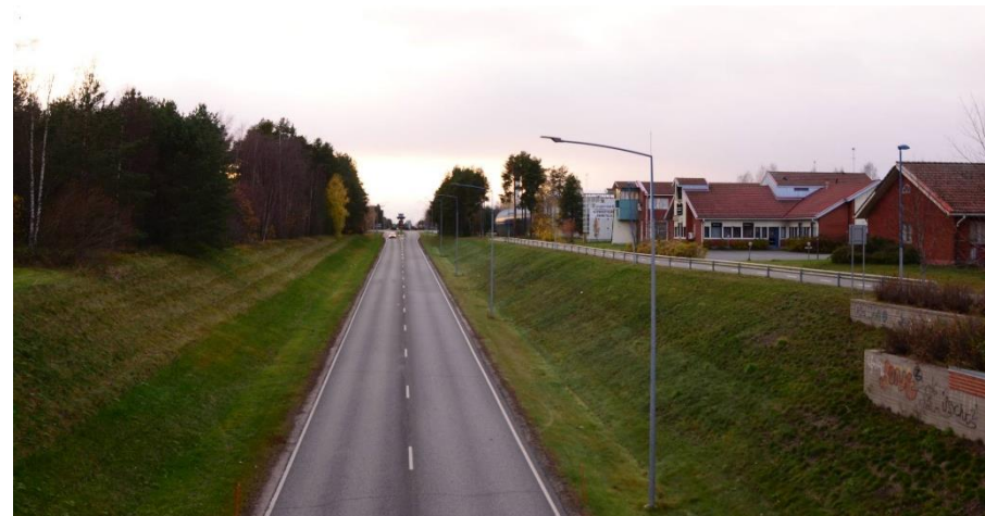
Sukellus. Taajaman keskustan kohdalla tie sukeltaa kevyen liikenteen sillan alitse. Lummintien varressa sijaitsevien toimitilarakennusten kapeat päädyt näkyvät maamerkkikohteena tiemaisemassa. Niiden takana näkyy Kauppakeskus Kapteenin kaareva julkisivu. Tien päätteenä erotuu lennonjohtotorni.
