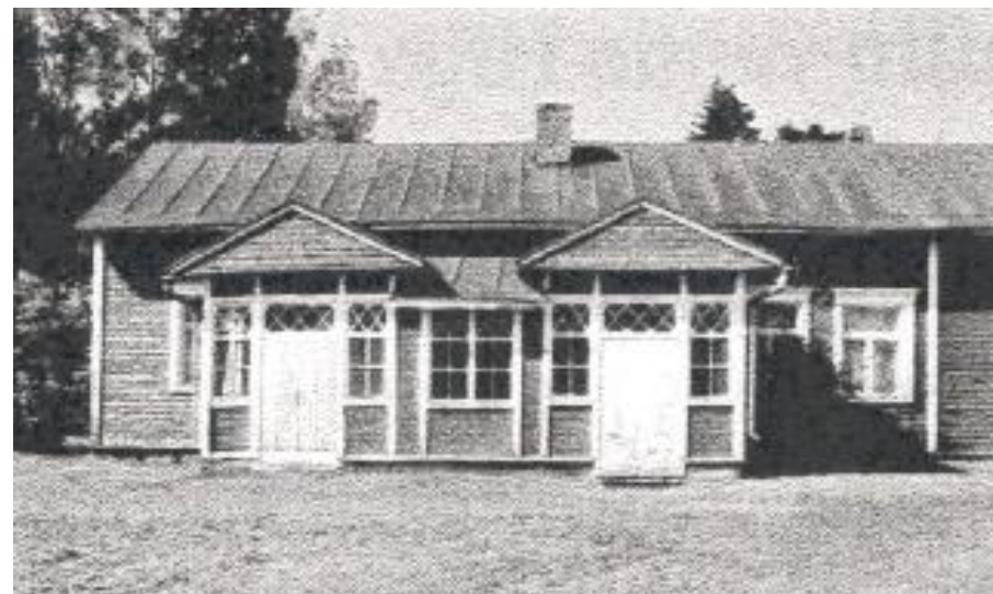
Yli-Kaakisen lasikuisti vuoden 1999 inventoinnin mukaan. (Kuva Oulunsalon yleiskaava-alueen rakennusinventointi 1999).
