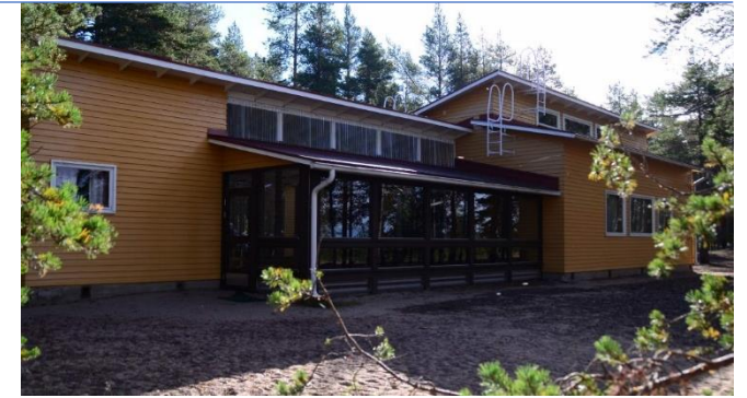
Päärakennuksen julkisivu rannan puolelle.
