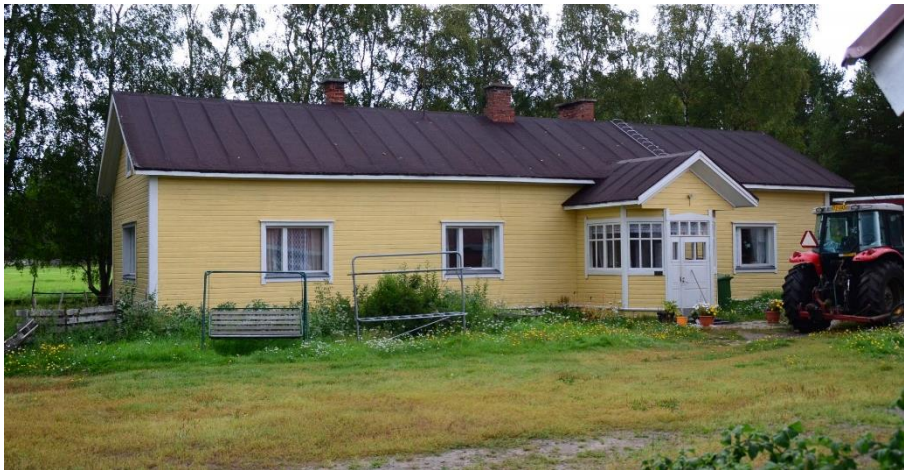
Kuivala-Lääkön asuinrakennus vuonna 2020. Kuisti on säilynyt vanhassa asussaan. Asuinkerroksen ikkunat on uusittu ja pärekate on uusittu kolmiorimahuopakatteeksi. Ullakkokerroksessa rakennuksen päädyissä on alkuperäiset ikkunat. Piiput ovat entisillä paikoillaan, joten tulisijat ovat säilyneet.
