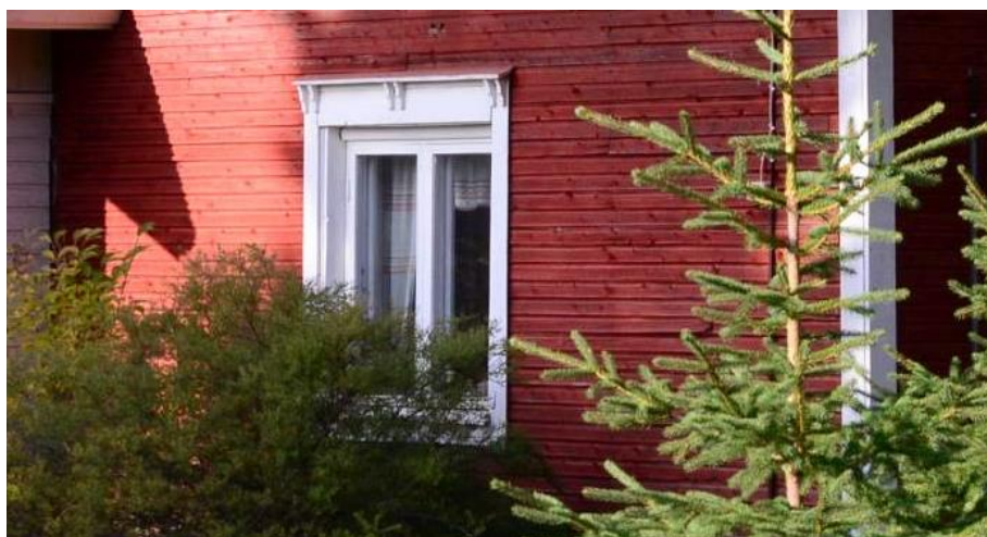
Maksan asuinrakennuksessa on saman kaltaiset konsoliaiheet ikkunan yläpuolella. Ikkunat on muodostaan päätellen uusittu, myös vuorilaudat voivat olla samassa yhteydessä uusitut.
