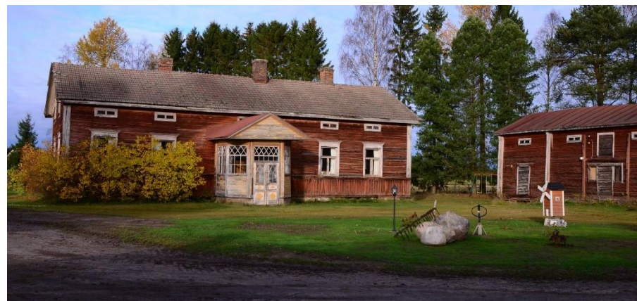
Ala-Kaakisen vanhat rakennukset ovat rakennushistoriallisesti arvokkaita. Ne ovat edustavia esimerkkejä talonpoikaisesta rakennusperinnöstä. Asuinrakennuksessa omaleimaisuutta luovina piirteinä erottuvat mm. ikkunoita kehystävät klassistiset vuorilaudat sekä siropuitteisten ruutuikkunoiden koristama lasikuisti. Oulunsalossa kuusikulmaiset kuistit, ns. mutterikuistit, erottuvat paikallisena erityispiirteinä. Saman kaltainen kuisti on mm. Prokkolan, Kukkosen ja Jääskön taloissa.
