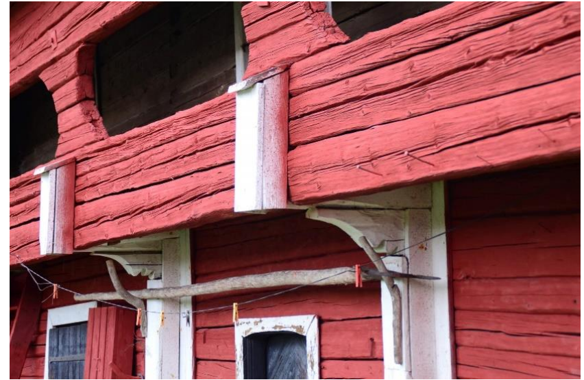
Luhtiaitan yksityiskohtia. Luhtia kannattaviin konsoleihin on veistetty koristeaiheet.
