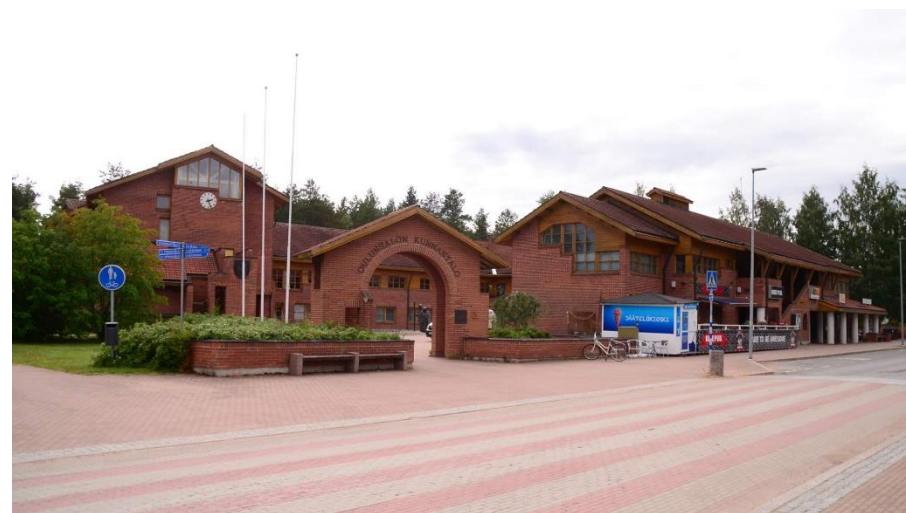
Taajaman keskustassa sijaitseva Oulunsalon kunnantalo on Oulun koulun merkkirakennus.
