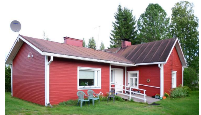
Asuinrakennus koostuu 1920- ja 1930-luvulla rakennetusta torppasta ja 1970-luvulla rakennetusta laajennusosasta.
