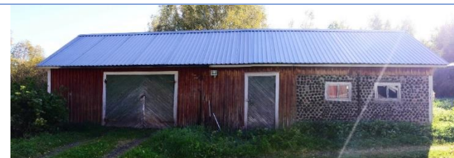
Pellikan pölkkynavetan pihan puolen julkisivu.
