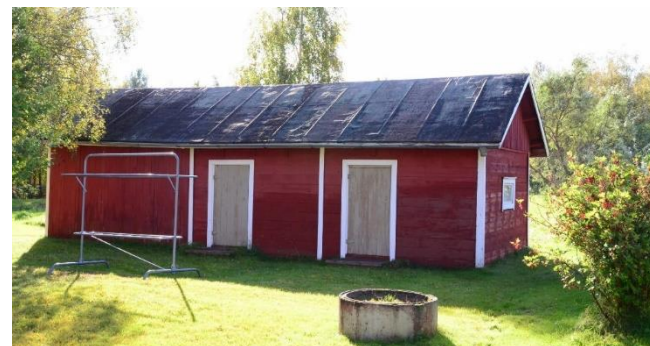
Puohi/liiteri, pihan puoli.
