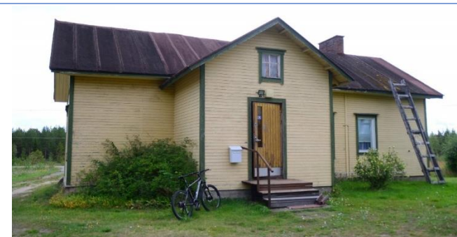
Asuinrakennus pihan puolelta.
