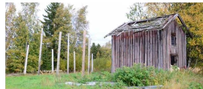
Aitta. Taustalla rakenteilla olevan konehallin paalut.
