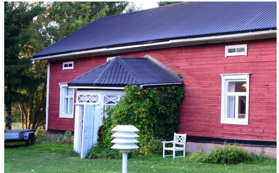
Lassilan asuinrakennuksessa on koristeellinen aumakattoinen mutterikuisti.
