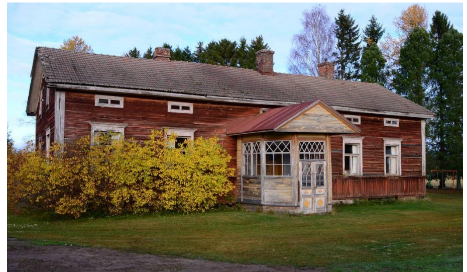
Ala-Kaakisen asuinrakennus vuonna 2020. Rakennus on säilynyt vanhassa asussaan.
