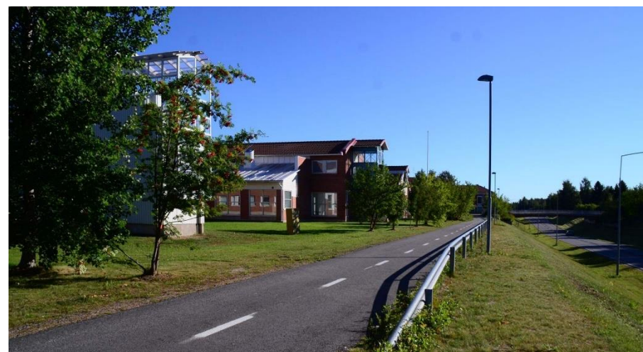
Suunnittelukylä -yritystalon ja sen vierellä sijaitsevien toimisto- ja liikerakennusten kapeat päädyt kattolyhtyineen erottuvat maamerkkikohteena Lentokentäntien maisemassa.
