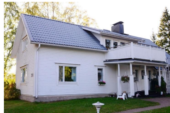
Asuinrakennuksen vanha pääty pihan puolelta.
