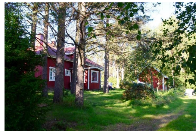
Päärakennus ja piharakennus.
