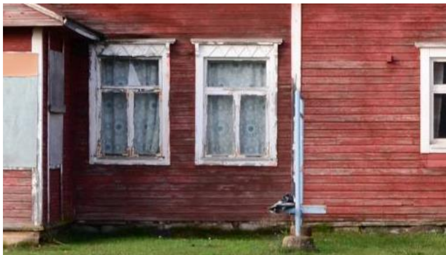
Yli-Kaakinen. Asuinrakennuksessa vanhojen ikkunoiden yläpuolella on sahalaitakoristelut ja molemmilla reunoilla pienet kaarevat konsolit.
