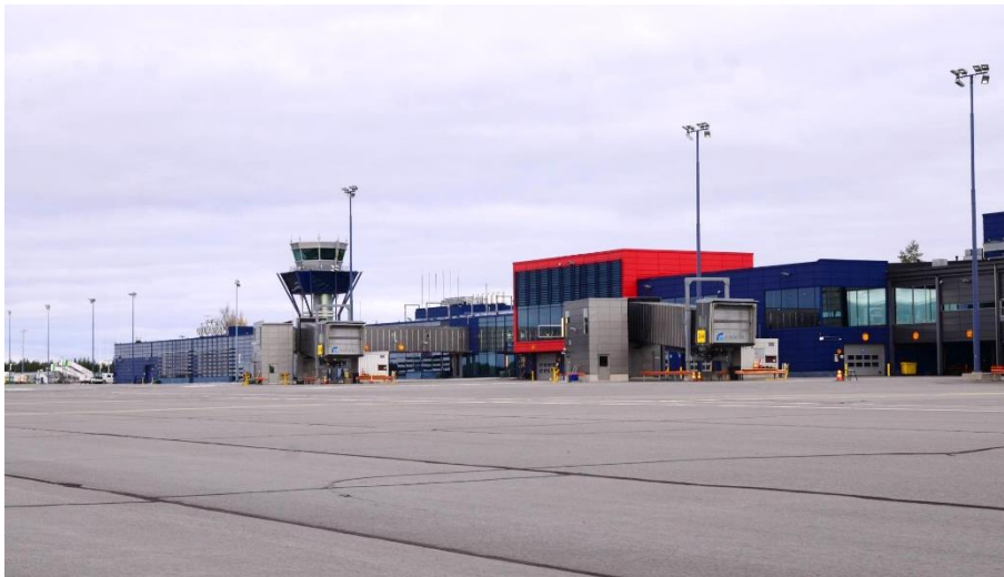
Terminaalirakennuksen kiitotien puoleista julkisivua rytmittävät polveilevat, keskenään hieman vaihtelevan korkuiset eri aikoina rakennetut laajennusosat ja matkustajasillat. Taustalla näkyy lennonjohtotorni.
