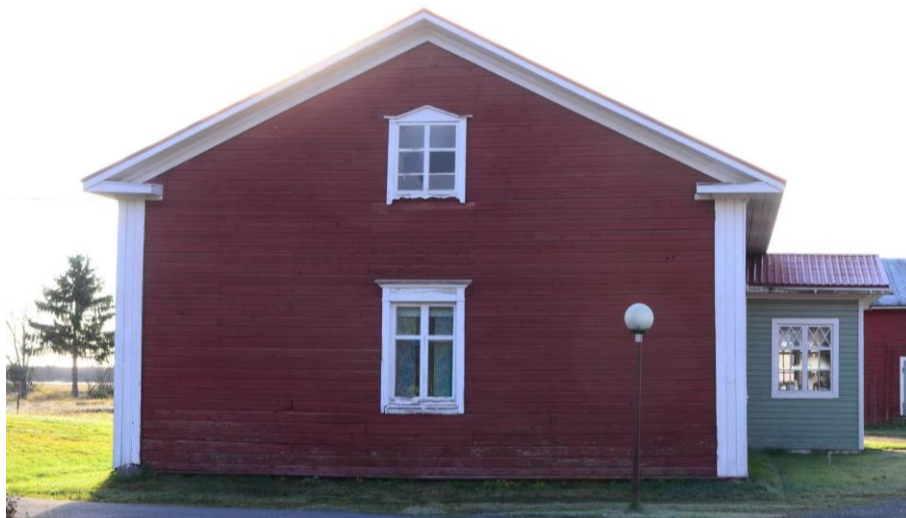
Junkkonen. Tien puoleisessa päädyssä asuinkerroksen ikkunaa kehystävät tyyliltään klassistiset vuorilaudat. Ullakkokerroksen ikkunassa vuorilaudat ovat koristeelliset.
