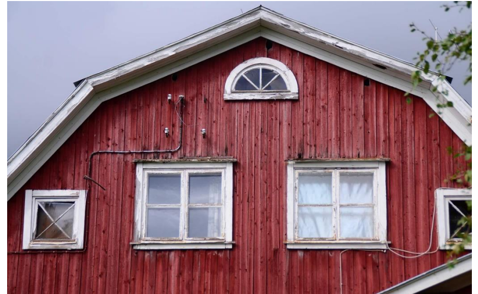
Jaakolan päädyissä on 1920-luvun klassismille tyypilliset puolipyöreät lunetti-ikkunat.
