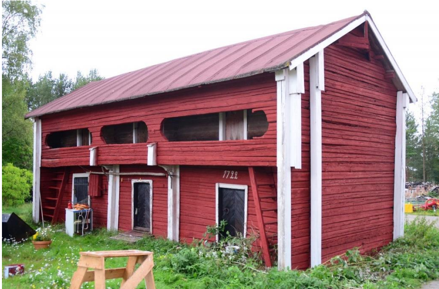
Kuivala-Lääkön pihapiiriä rajaava luhtiaitta on rakennettu vuonna 1722. Keskellä ollut läpiajosola on rakennettu umpeen.
