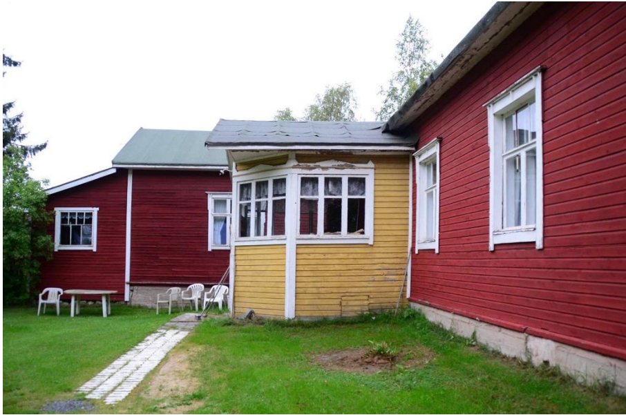
Jääskön asuinrakennusta on useaan otteeseen laajennettu.
