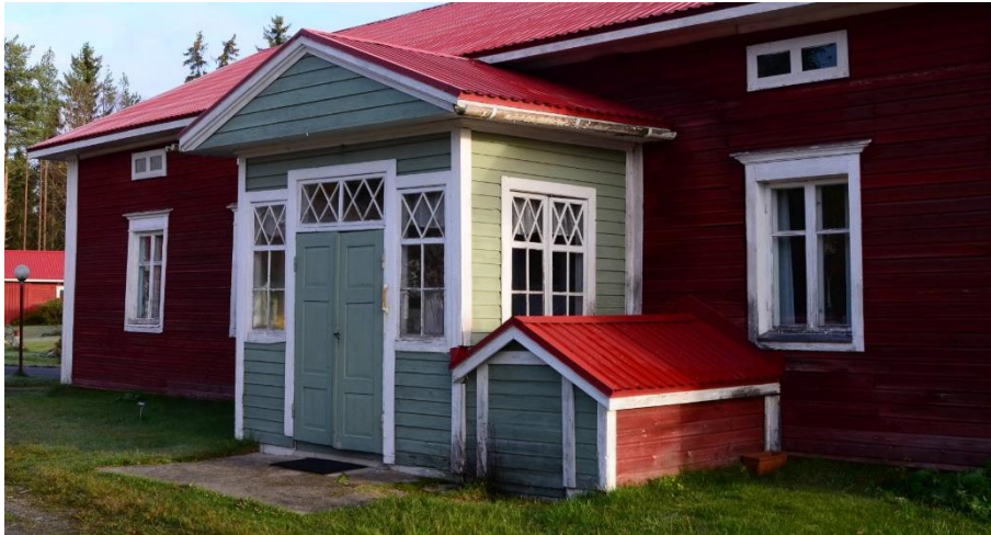
Kylänpuolen kylässä sijaitsevan Junkkosen asuinrakennuksen kuistissa on saman kaltaiset ruutuikkunat kuin Ala-Kaakisen kuistissa. Kuistin kulmia ei ole viistetty siten kuin mutterikuisteissa. Kuistin vieressä on kellarin johtava halssi. Kuistia on korostettu maalaamalla sen julkisivut eri värillä kuin asuinrakennuksessa.
