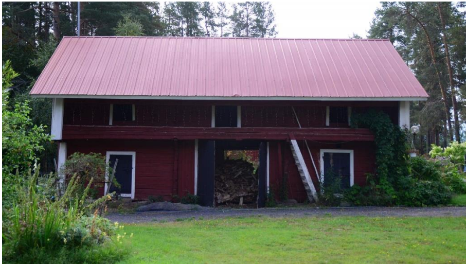
Helasen luhtiaitta. Aitan keskellä on edelleen läpikuljettava sola.
