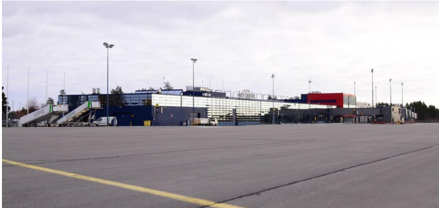
Lentokentän terminaalirakennus on siluutiltaan matala ja pitkä. Julkisivussa vuorottelevat lasi ja maalattu teräs. Kiitotien puolella eri aikoina rakennetut osat eivät erotu toisistaan yhtä selvästi kuin sisääntulopuolella.
