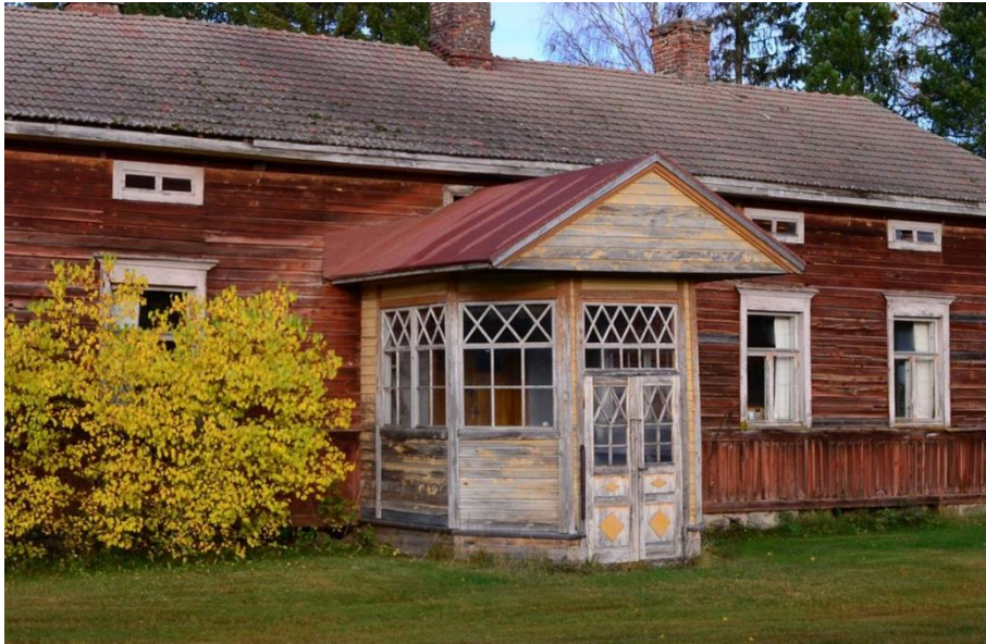
Ala-Kaakisen kuistissa on siropuitteiset ruutuikkunat.
