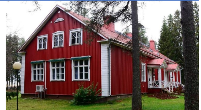
Entinen koulurakennus, itäpäätty ja pohjoisjulkisivu.
