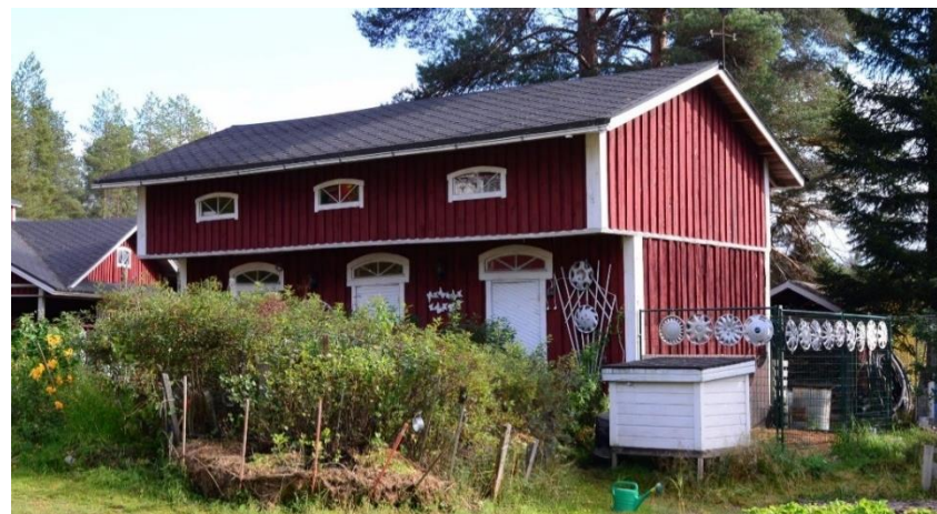
Puohirakennuksessa on 1920-luvun tyyliiset kaari-ikkunat. Rakennuksen ulkoasua on aikojen kuluessa uudistettu, kate ja ainakin osa ulkoverhouksesta on uusittu. Ovien päällä olevat kaari-ikkunat vaikuttavat vanhoilta. Luhdin ikkunat ovat nelikulmaiset, ne on naamioitu kaari-ikkunoiksi yläpuolella olevilla kaarevilla vuorilaudoilla.
