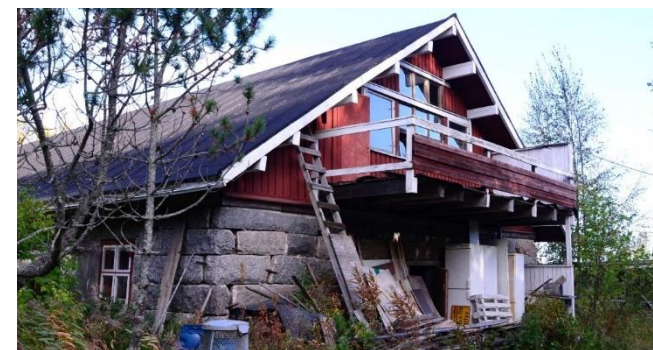
Navetta. Päädyn alaosa on tehty massiivisista kiviharkoista.
