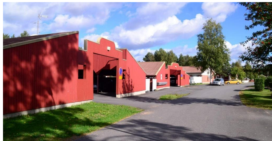
Lepikkotie 2. Pitkäkankaan asuinalueella sijaitseva yksikerroksisista rivitaloista muodostuva korttelialue on valmistunut vuonna 1982. Rakennukset on suunnitellut arkkitehti Tero Paldanius. Korttelialueella sijaitsevat autokatokset ovat omaleimaiset. Julkisivuiltaan punatiiliset asuinrakennukset ovat tavanomaista oman aikakautensa asuinrakentamista.
