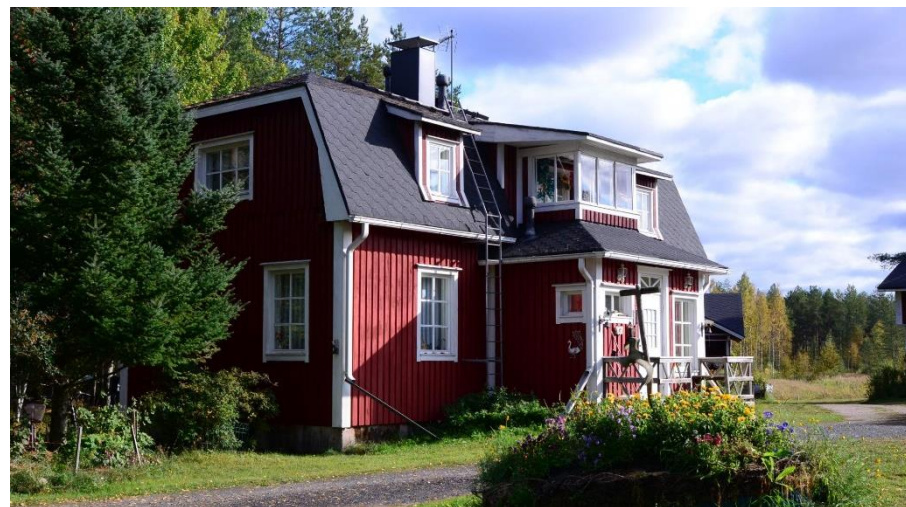
Mäntyharjun asuinrakennuksessa on saman kaltainen taitekatto kuin Varjakan asuinrakennuksissa. Rakennukseen on tehty aikojen kuluessa muutoksia. Kate on uusittu palahuopakatteenksi. Kuisti lienee ainakin osittain uusi.
