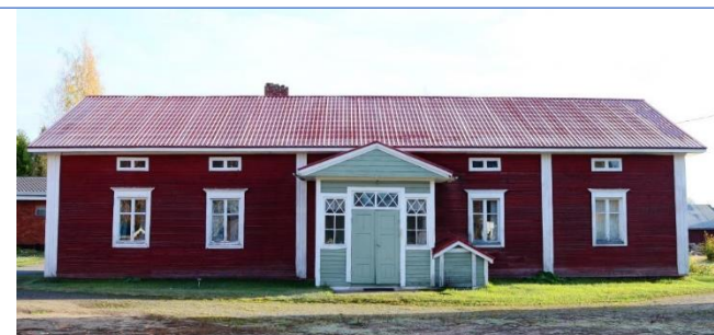
Vanha asuinrakennus. Kuistin vieressä on halssi.
