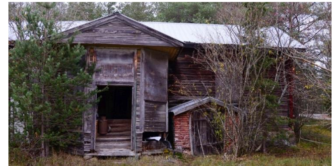
Vanha asuinrakennus, pihan puoli.
