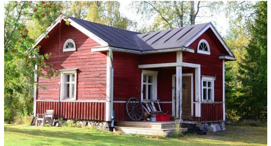
Ehnbergin pienikokoisessa asuinrakennuksessa ullakkokerroksessa on lunetti-ikkunat. Rakennus on rakennettu 1920-luvulla paikalle siirretyistä hirsistä.
