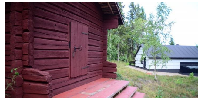
Aitta ja taustalla uusi huvilarakennus.
