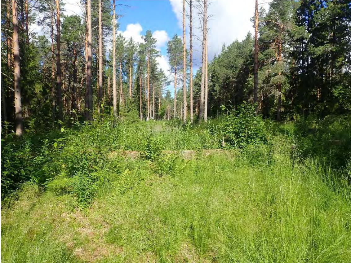
Peitteisessä maastossa sijaitseva rakennuksen betoninen perustus. Kaakkoon.
