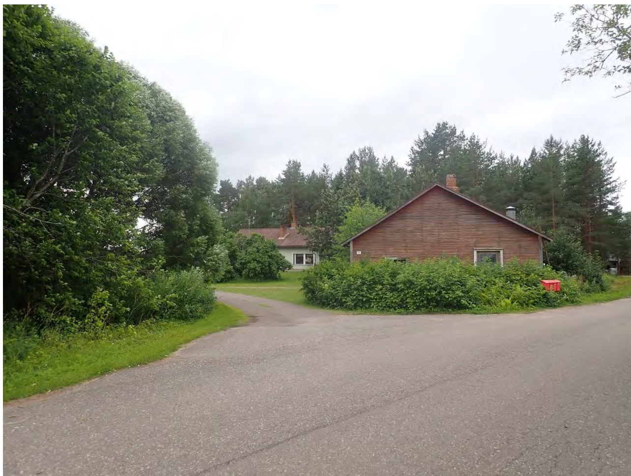
Helasin tilan rakennuksia sekä Päätalolle johtava tie. Lounaaseen.
