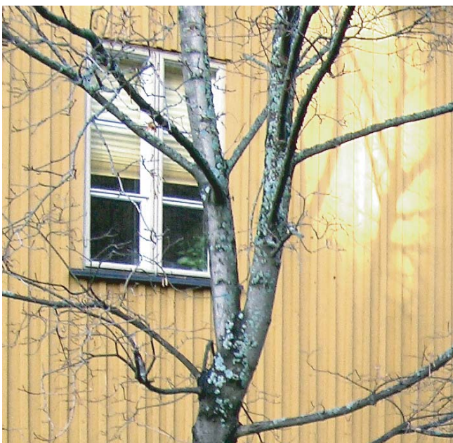
Kuva 11: Esimerkki yhtenäisestä julkisivuverhouksesta ja hillityistä pielilaudoista.
