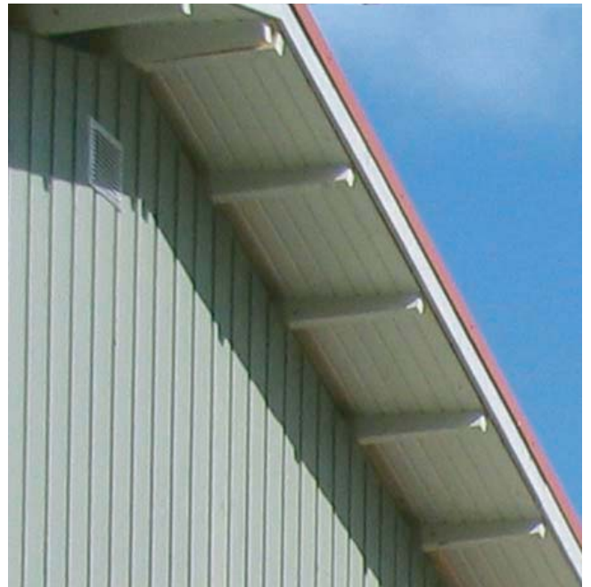
Kuva 4: Esimerkki avoräystästä ja yhtenäisestä julkisivuverhouksesta.
