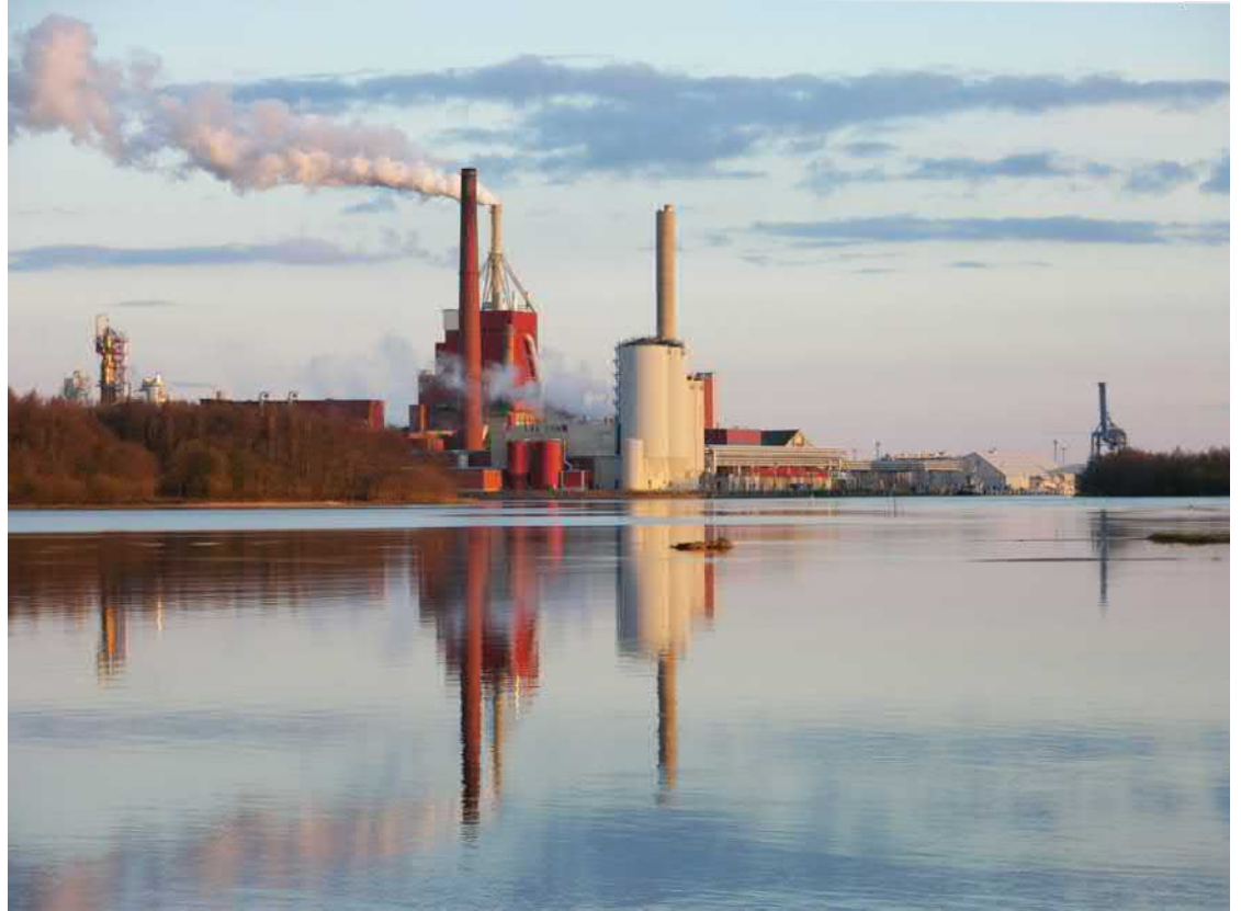
Nuottasaarelle rakennettiin Oulu Oy:n sulfaattiselluloosatehdas 1936. Stora Enson tehtaassa valmistetaan nykyisin kartonkia. Punainen tiilipiippu purettiin muutama vuosi sitten. Kuva on vuodelta 2017.
