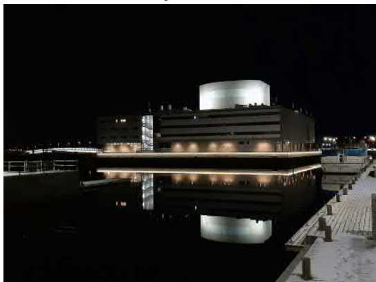
Vesipeilin visuaalinen teho on voimakas. Saaren reunojen valaistus on vastikään korjattu.
